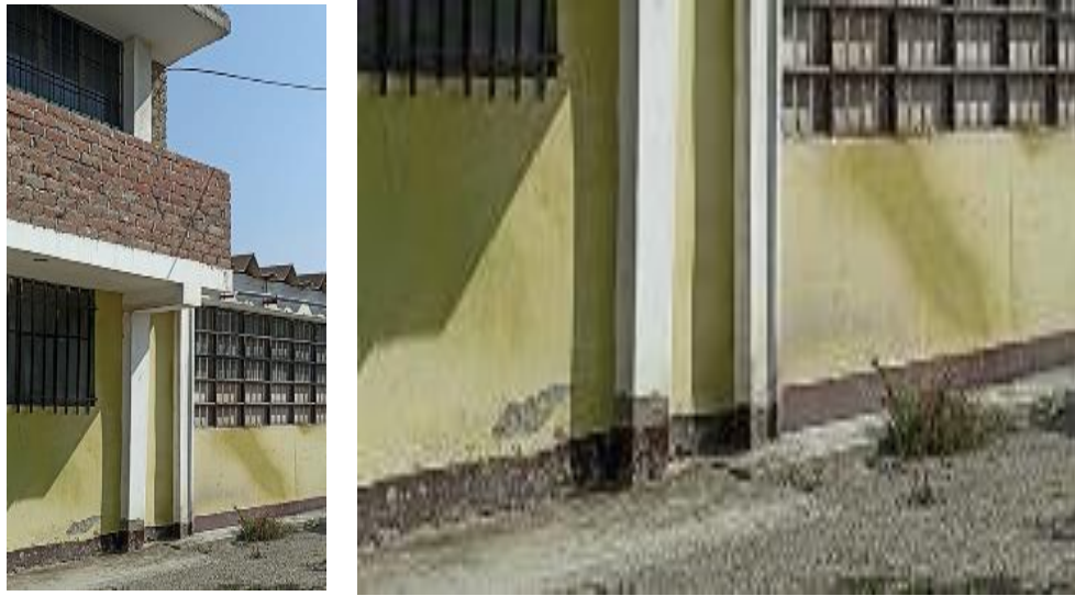
Figura 15. Comparación de patología de compresión por segundo nivel (izquierda) y sin segundo nivel (derecha).
