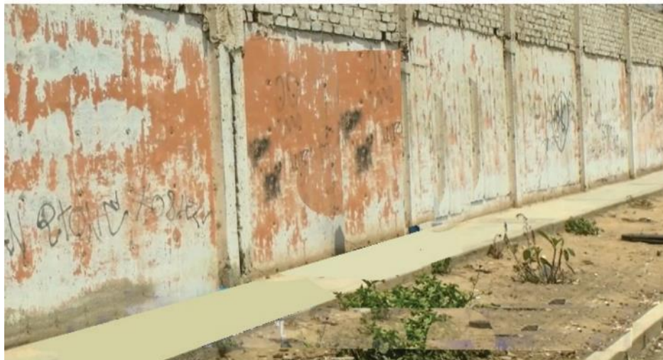
Figura 21. Vista del muro perimetral.
