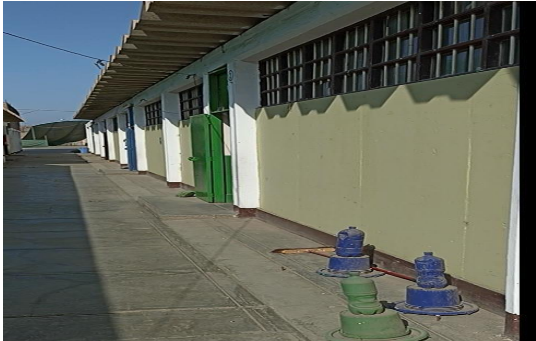
Figura 4. Pabellón 1, el mismo que tiene 5 aulas se aprecia la construcción basada en vigas y columnas, muros externos no tienen función estructural.
