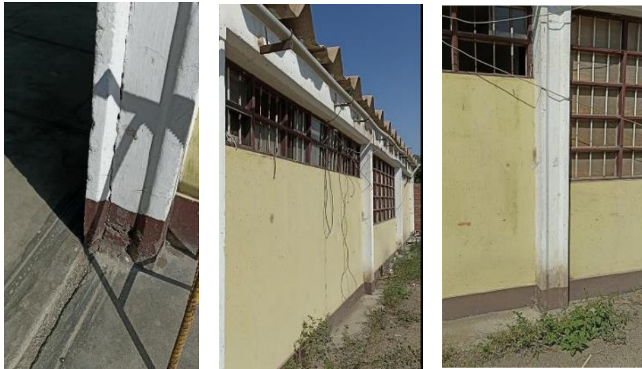
Figura 19. Vista posterior del pabellón administrativo.
