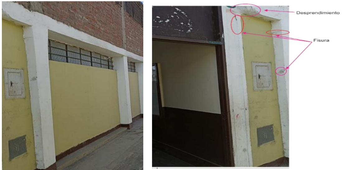
Figura 9. Construcción sobre el pabellón 2.
