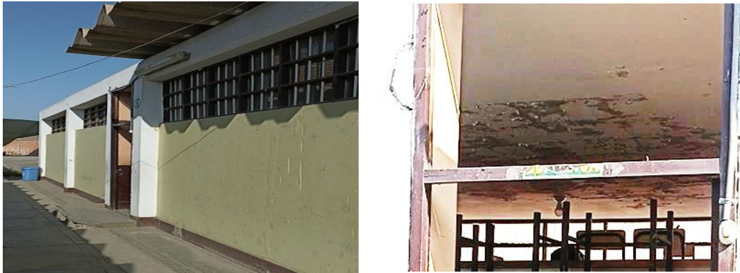
Figura 7. Techo aligerado, diferente a los demás del aula 05. Nota. Fuente: Elaboración el autor
