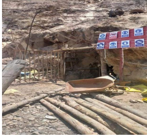
Anexo 8. Entrada a la mina San Jorge con su reglamento de seguridad
