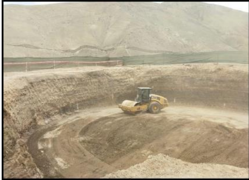
Fotografía N° 12: Control de nivelación de fondo de cimentación
