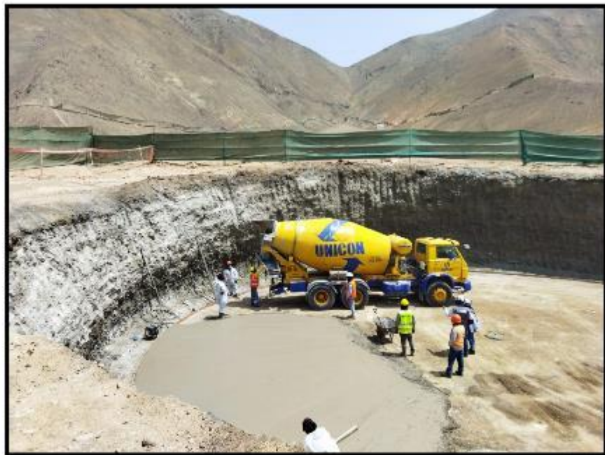
Fotografía N° 15: Vaciado de concreto en solado.
