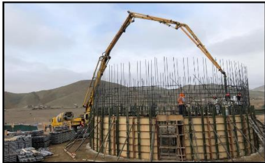
Fotografía N° 11: Vaciado del primer anillo de fuste del reservorio elevado.
