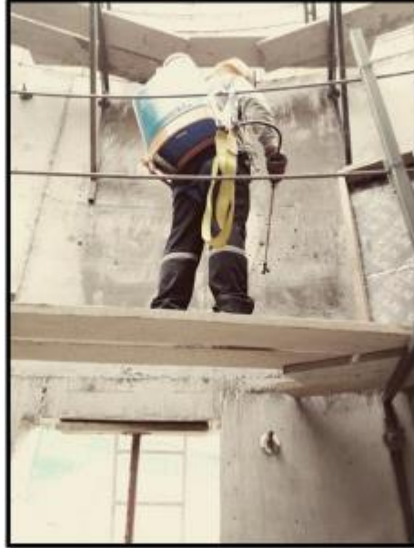
Fotografía N° 20: Curado del interior del primer anillo con mochila pulverizadora.
