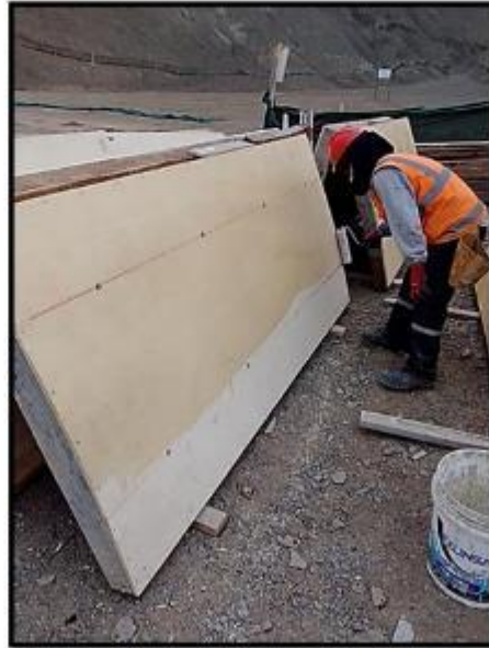
Fotografía N° 06: Colocación de desmoldante a paneles.
