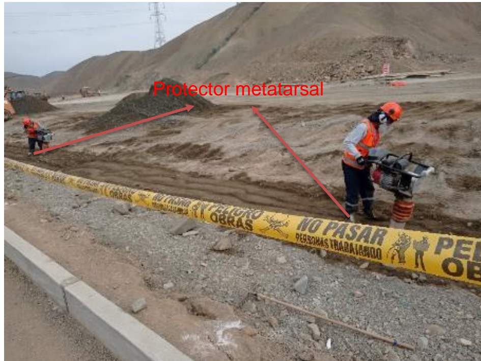
Figura 26. EPP para compactación con apisonador
