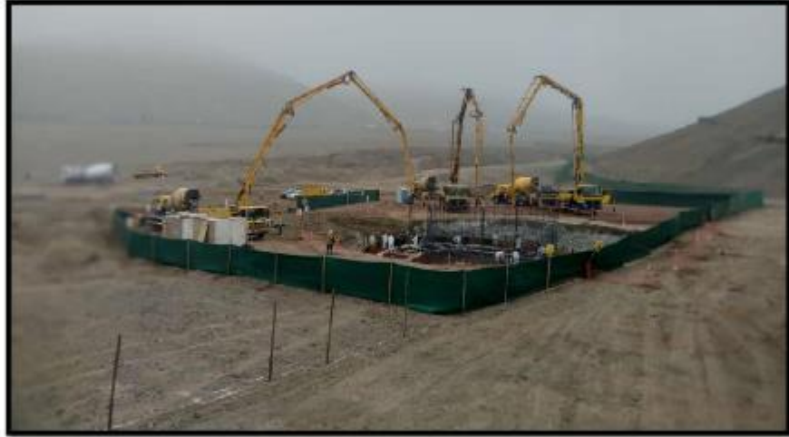
Fotografía N° 25: Vaciado masivo de losa de cimentación.
