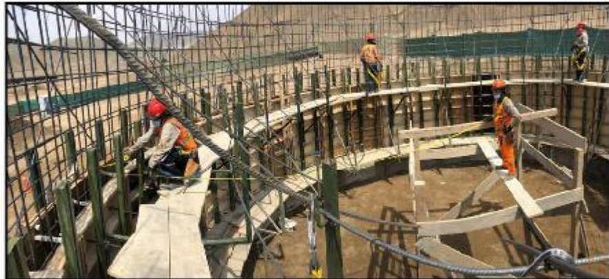
Fotografía N° 09: Control y medición de radio del 1er anillo de fuste.
