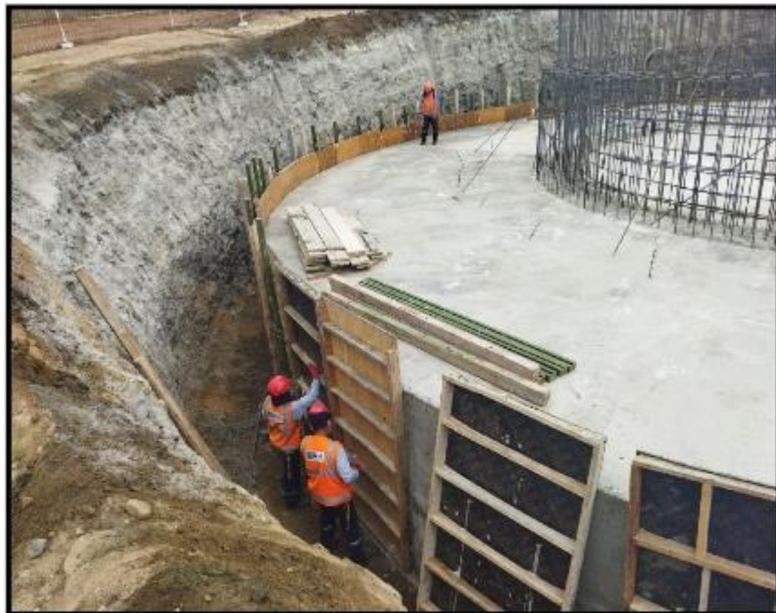
Fotografía N° 31: Desencofrado de losa de cimentación.
