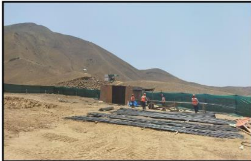
Fotografía N° 05: Habilitación de acero de cimentación para reservorio.
