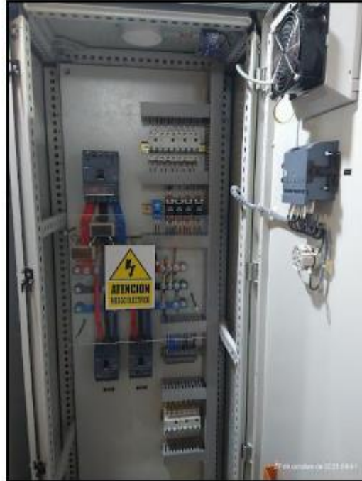
Fotografía N° 12: Tablero banco de condensador N.° 01 PLACA
