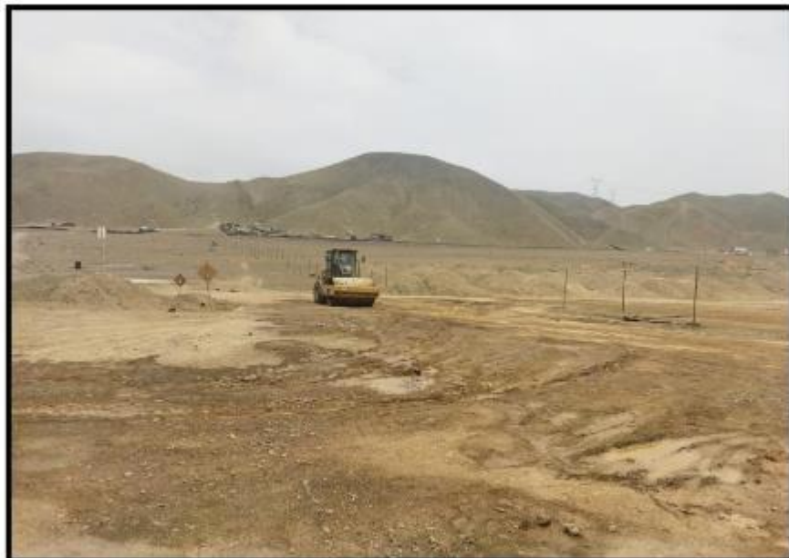
Fotografía N° 23: Conformación de acceso vehicular previo al vaciado.
