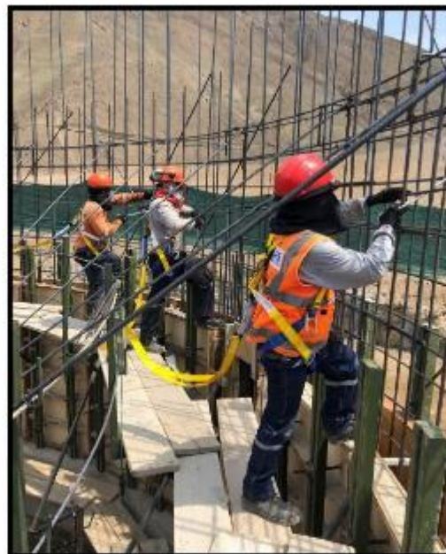
Fotografía N° 15: Armado de acero para fuste del 2do anillo.
