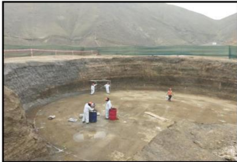
Fotografía N° 13: Estabilización de taludes con agua-cemento.
