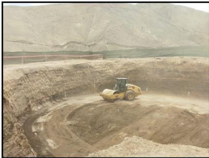
Fotografía N° 11: Compactación de fondo de cimentación
