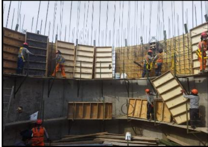
Fotografía N° 17: Instalación de encofrado en el interior del segundo anillo.
