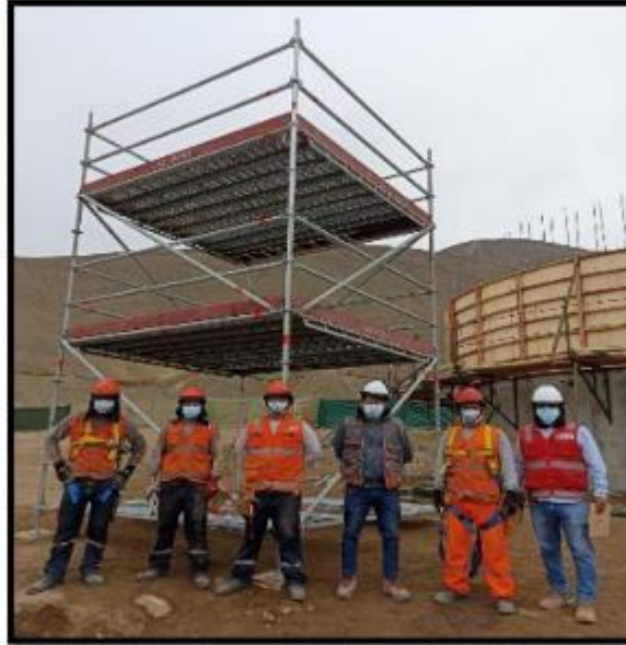
Fotografía N° 14: Instalación de andamios para actividades en el segundo anillo de fuste.
