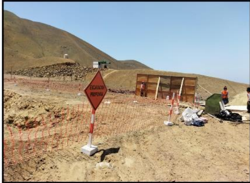
Fotografía N° 04: Instalación campamento de obra.
