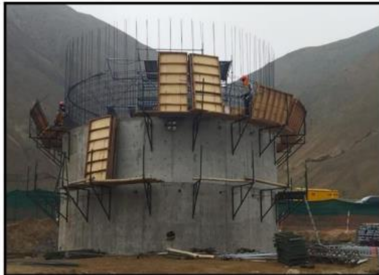
Fotografía N° 21: Armado de acero del 3er anillo de fuste.
