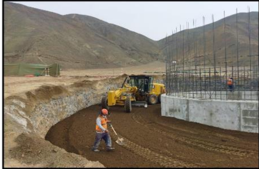
Fotografía N° 43: Relleno y compactado a los laterales de viga de cimentación.
