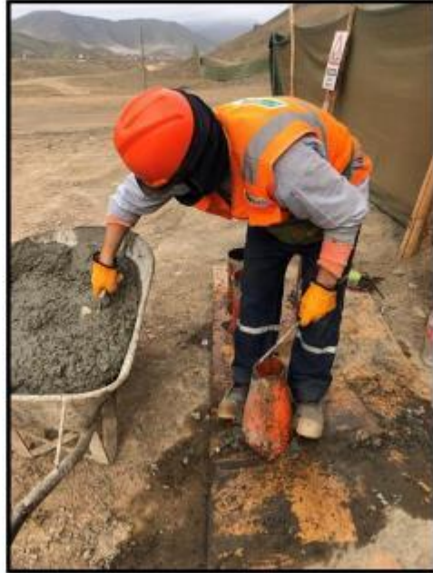
Fotografía N° 11: Vaciado del primer anillo de fuste del reservorio elevado.
