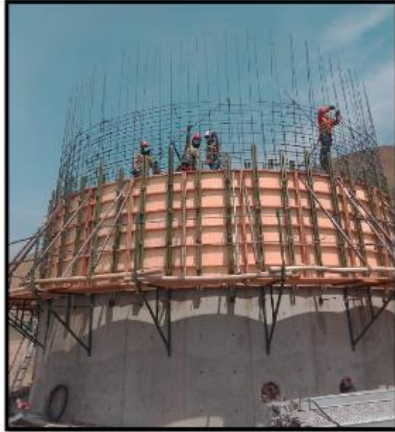
Fotografía N° 18: Instalación de encofrado en el exterior del segundo anillo.
