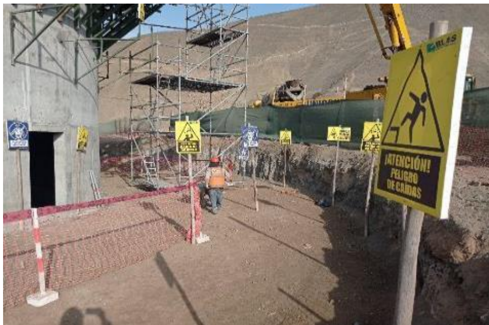
Figura 39. Señalización en zona de trabajo
