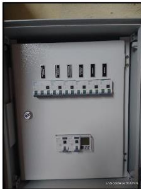
Fotografía N° 10: Tablero de distribución CP-01 PLACA
