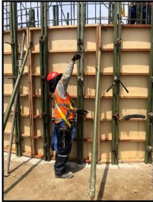
Fotografía N° 08: Instalación de encofrado exterior en el primer anillo de fuste.
