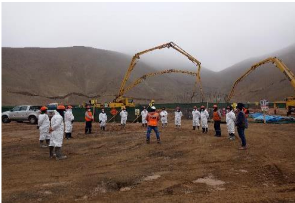
Figura 32. Capacitación para vaciado masivo
