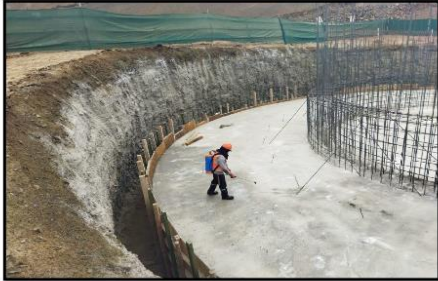
Fotografía N° 33: Acero para viga anular de cimentación del reservorio elevado.
