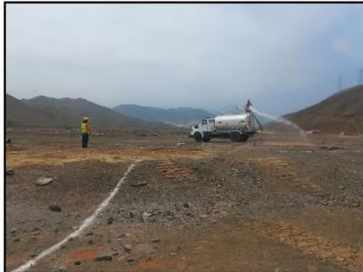
Fotografía N° 06: Mitigación de impacto ambiental, mediante el uso de la cisterna.
