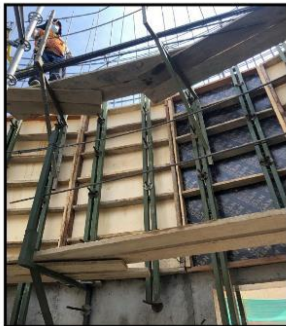
Fotografía N° 17: Instalación de encofrado en el interior del segundo anillo.
