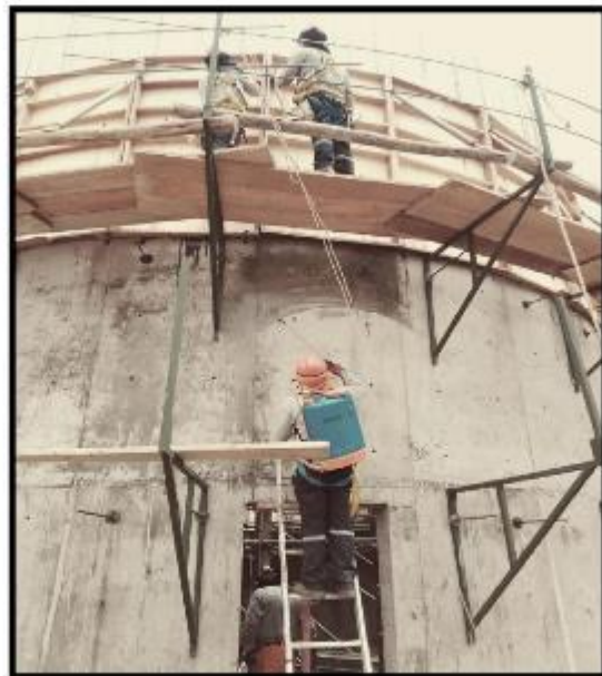
Fotografía N° 19: Curado del exterior del primer anillo con mochila pulverizadora.
