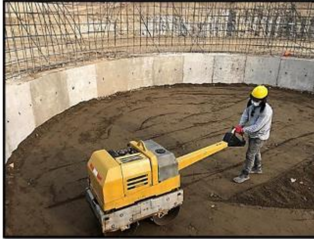
Fotografía N° 04: Compactación en la parte interior del reservorio.
