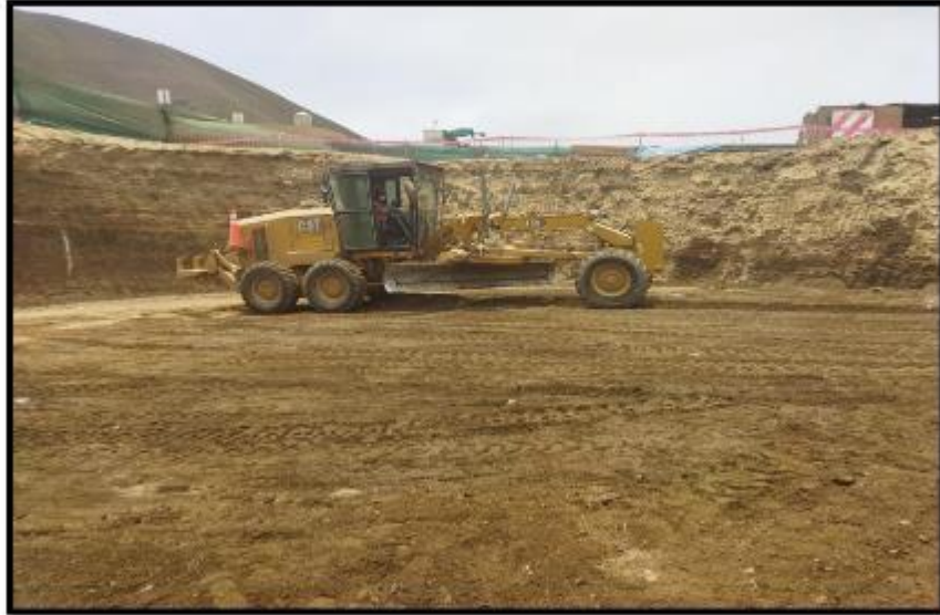
Fotografía N° 10: Nivelación y refine de fondo de cimentación.
