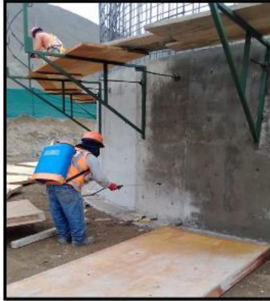
Fotografía N° 12: Curado del exterior del primer anillo con mochila pulverizadora
