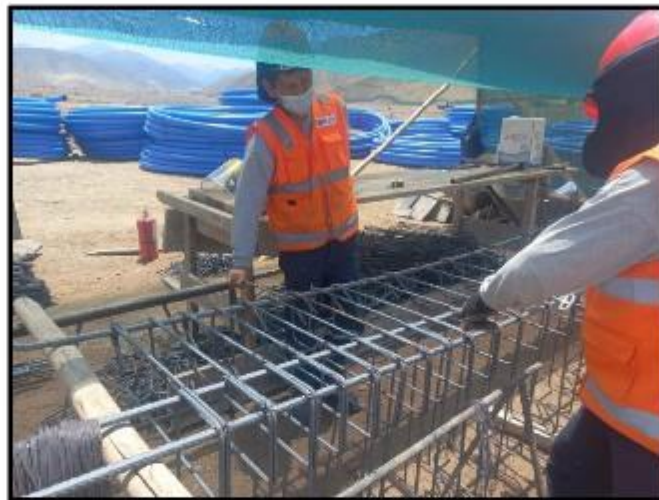
Fotografía N° 08: Habilitación del acero (columnas para la cisterna)
