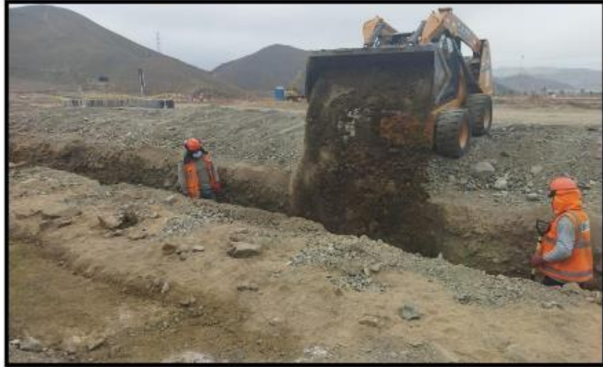
Fotografía N° 29: Tendido de tuberías de 200 mm para línea de impulsión.
