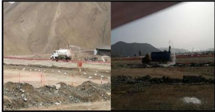
Fotografía N° 02: Mitigación de impacto ambiental, mediante el uso de la cisterna.
