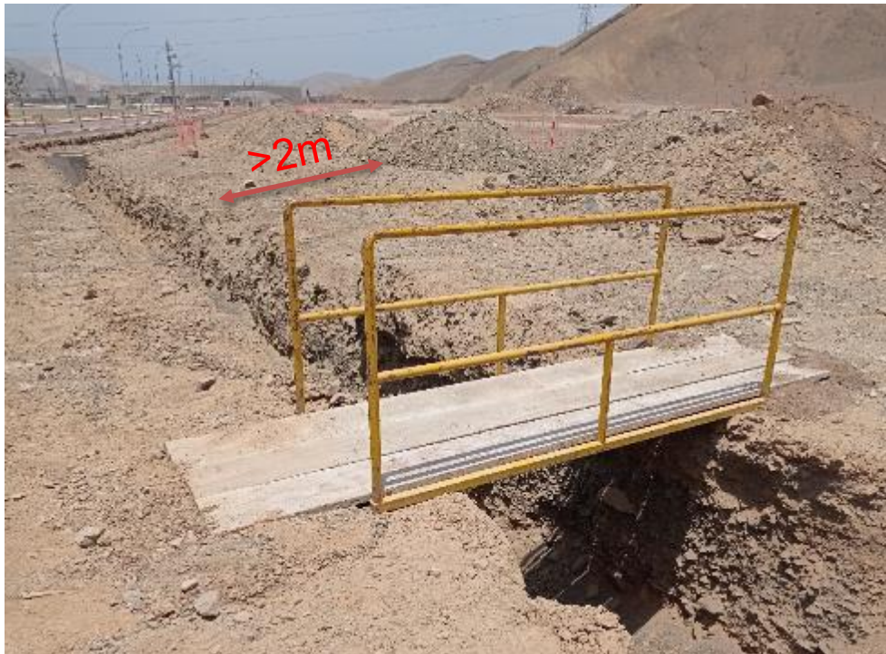
Figura 23. Distanciamiento de material saliente de zanja.
