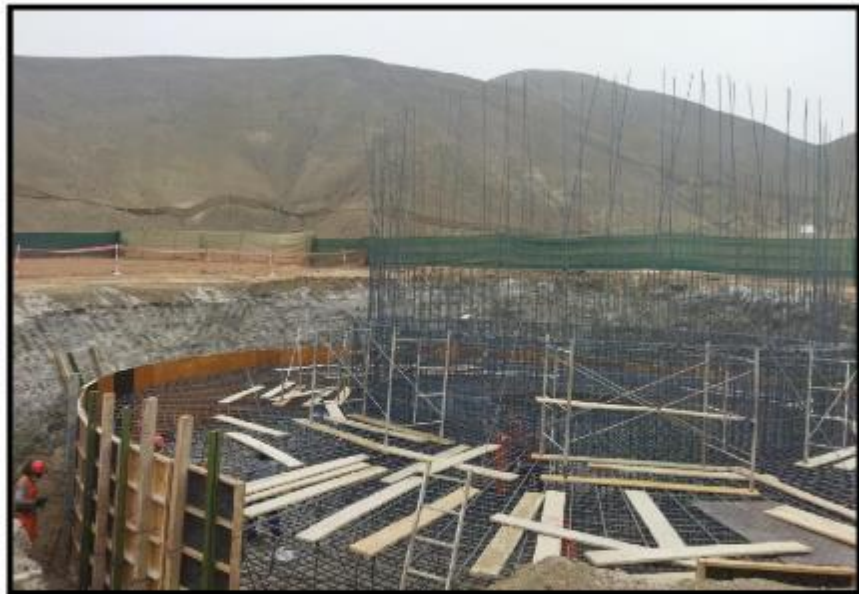
Fotografía N° 21: Encofrado de losa de cimentación.
