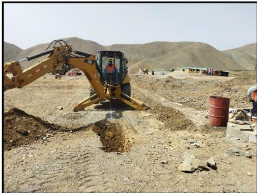
Fotografía N° 27: Excavación de zanjas para línea de impulsión.
