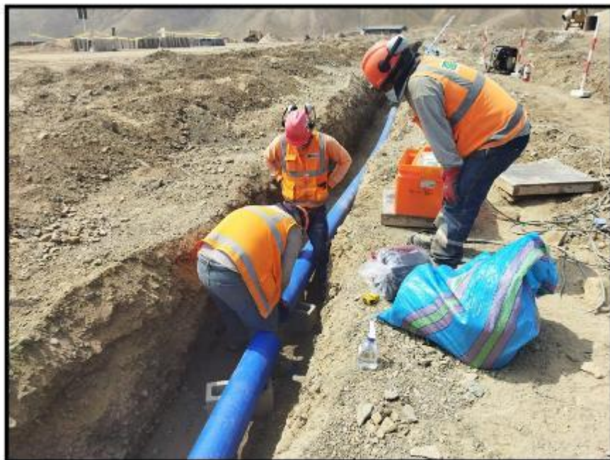
Fotografía N° 29: Tendido de tuberías de 200 mm para línea de impulsión.
