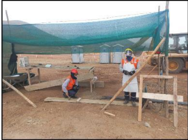
Fotografía N° 07: Instalación de taller de habilitación del acero para a cisterna
