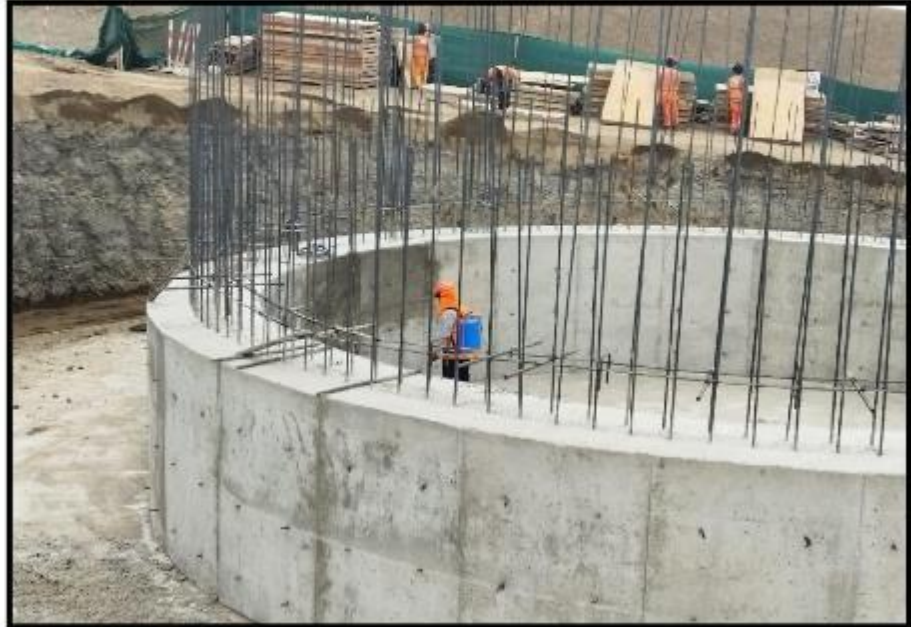
Fotografía N° 40: Curado interior de viga de cimentación.
