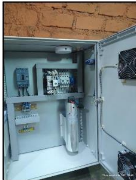
Fotografía N° 12: Tablero banco de condensador N.° 01 PLACA
