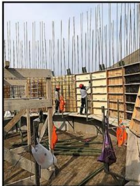
Fotografía N° 07: Instalación de encofrado interior en el primer anillo de fuste.
