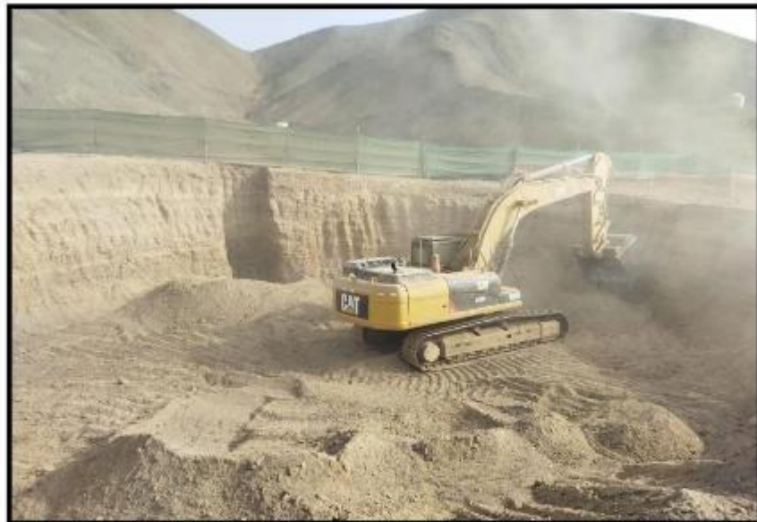
Fotografía N° 07: Perfilado de excavación de reservorio.
