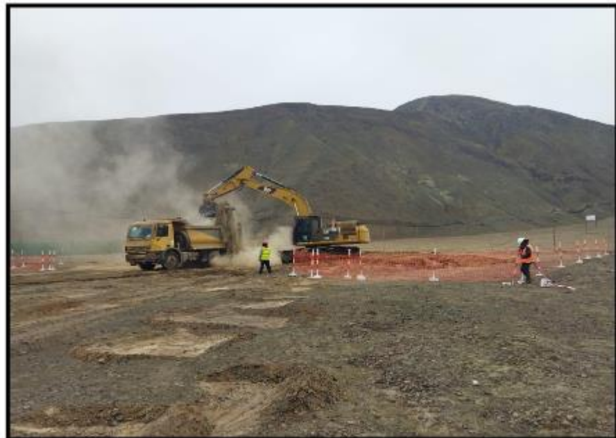
Fotografía N° 03: En esta imagen se observa el inicio de excavación del reservorio.
