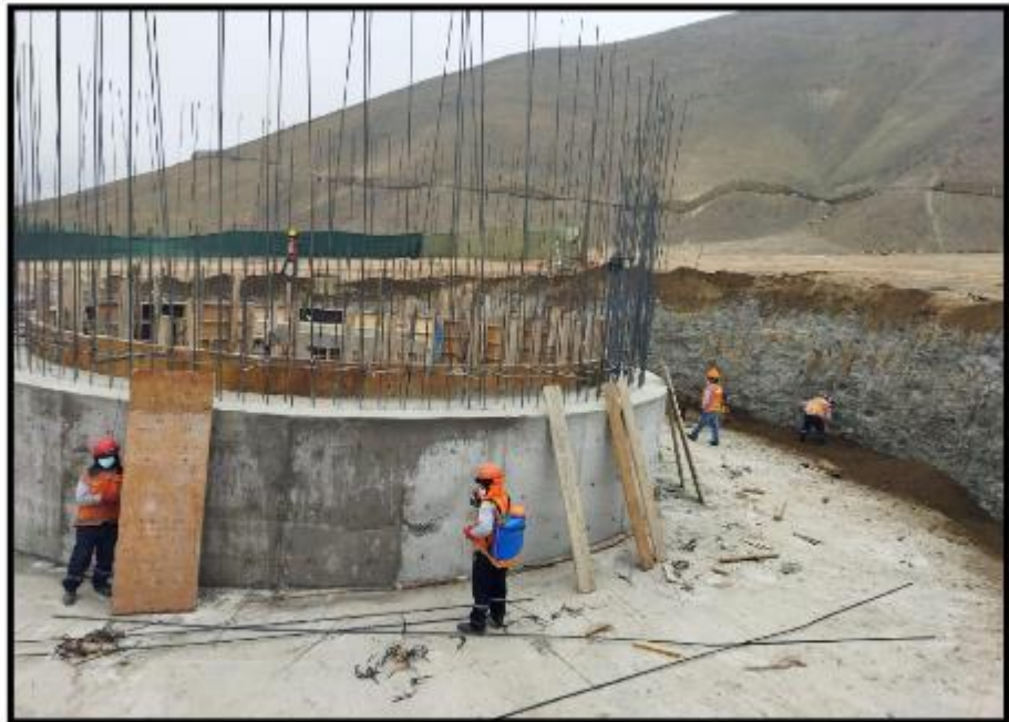
Fotografía N° 39: Curado exterior de viga de cimentación.
