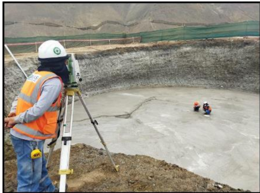
Fotografía N° 17: Trazo y replanteo para acero de cimentación.
