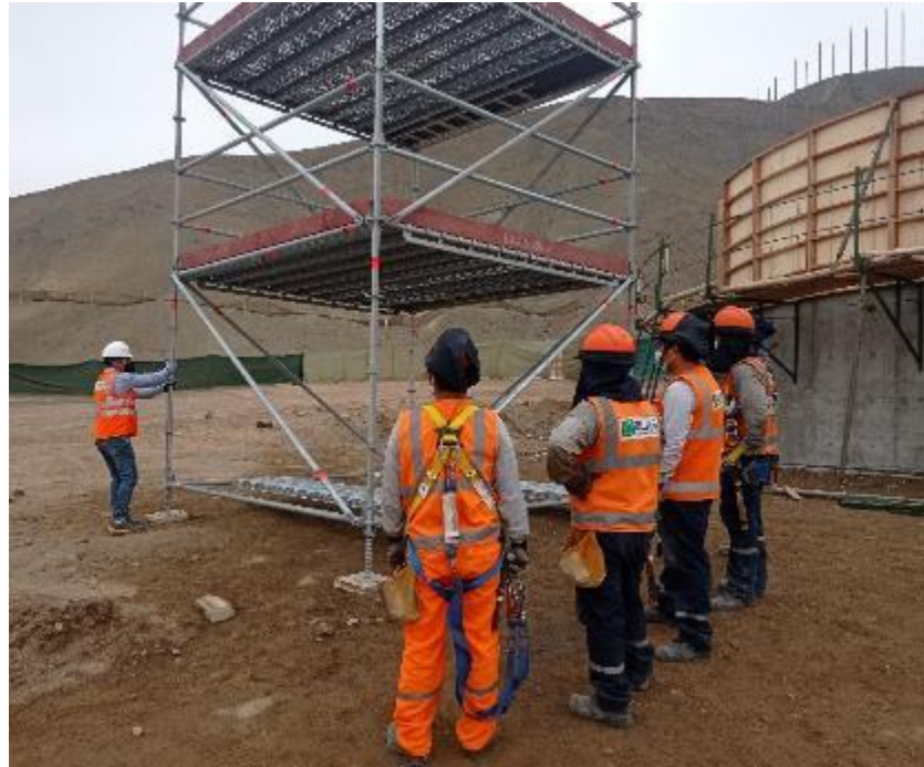
Figura 34. Capacitación de armado de Andamios Layher
