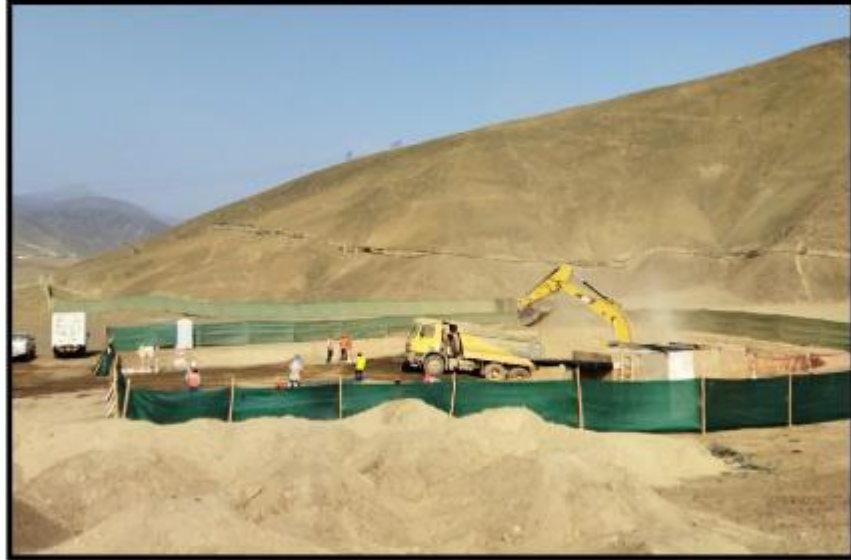
Fotografía N° 06: Eliminación de material excedente.
