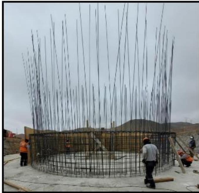
Fotografía N° 33: Acero para viga anular de cimentación del reservorio elevado.
