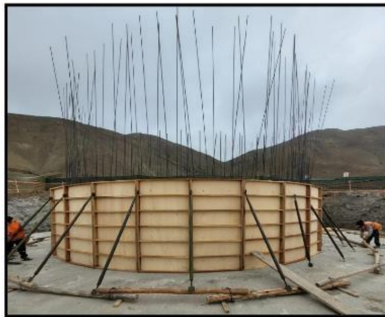
Fotografía N° 35: Encofrado de la viga anular de cimentación.
