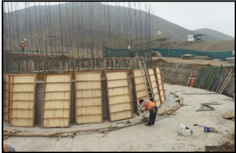
Fotografía N° 38: Desencofrado de viga de cimentación.
