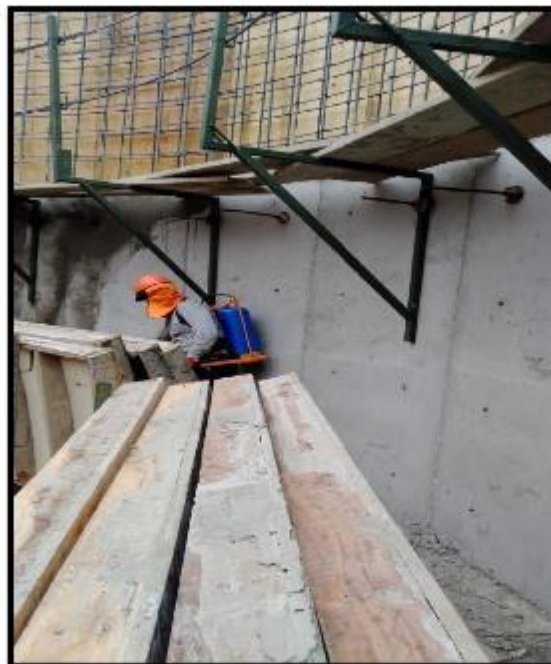
Fotografía N° 13: Curado del interior del primer anillo con mochila pulverizadora
