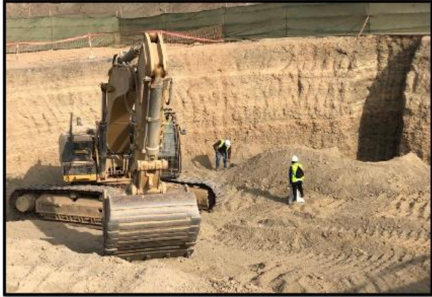
Fotografía N° 08: Toma de muestras para ensayos en laboratorio de suelos.
