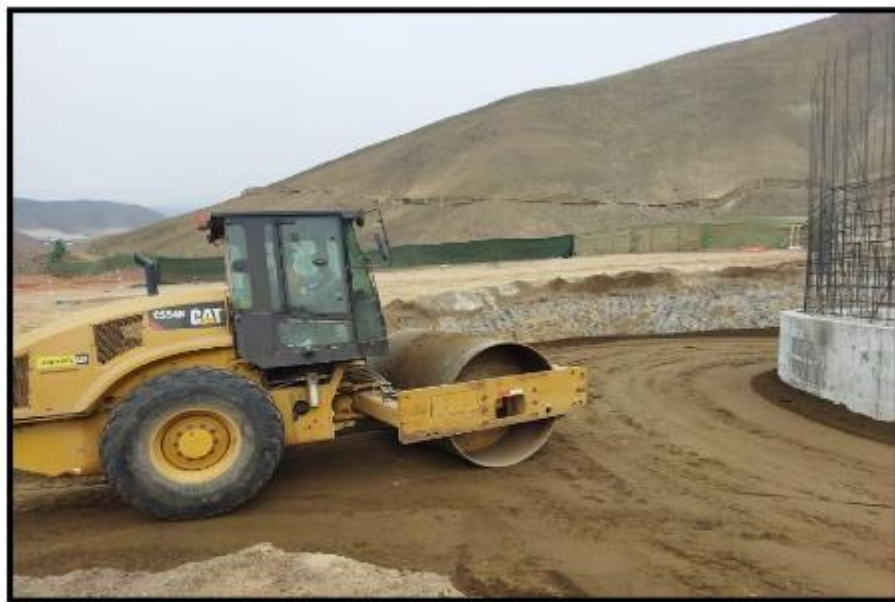
Fotografía N° 43: Relleno y compactado a los laterales de viga de cimentación.
