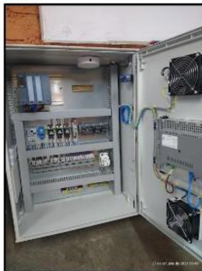
Fotografía N° 14: Tablero de control Reservorio Elevado
