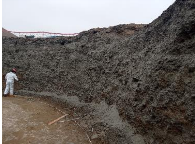
Figura 30. Colocación de lechada en paredes de excavación
