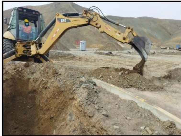
Fotografía N° 23: Excavación de zanjas para línea de impulsión.
