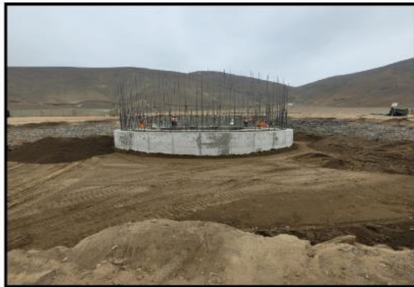
Fotografía N° 41: Relleno compactado y controlado con maquinaria.
