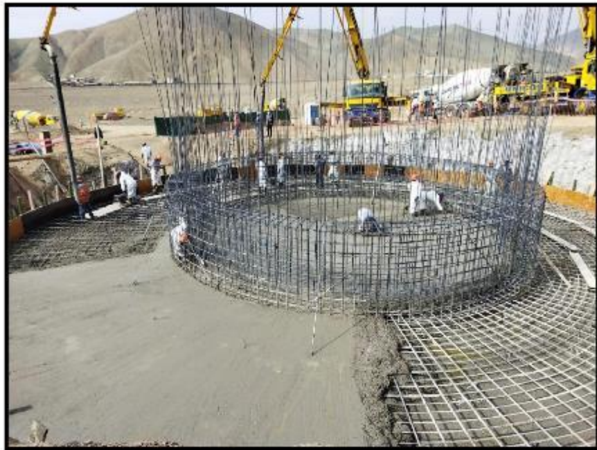
Fotografía N° 25: Vaciado masivo de losa de cimentación.
