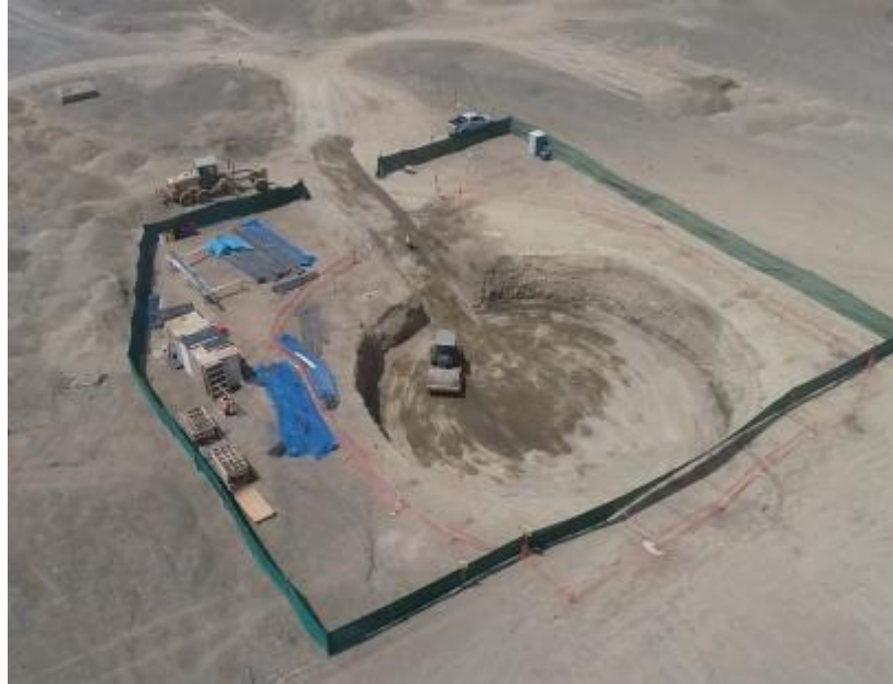
Figura 29. Vista aérea de zona de reservorio
