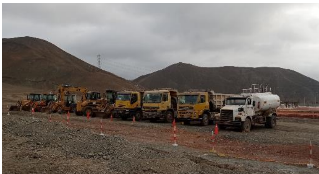
Figura 22. Maquinaria pesada y vehículos mayores.
