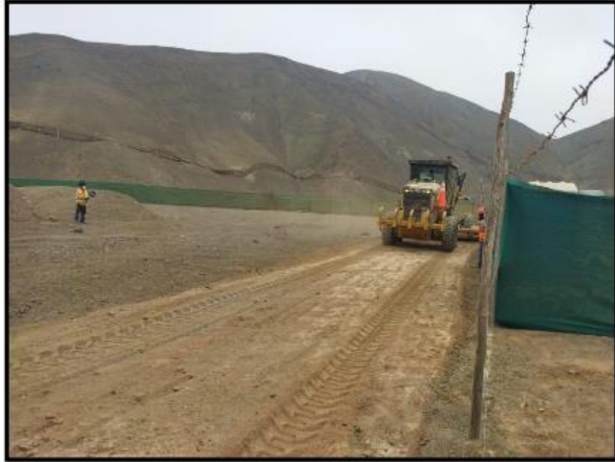
Fotografía N° 23: Conformación de acceso vehicular previo al vaciado.
