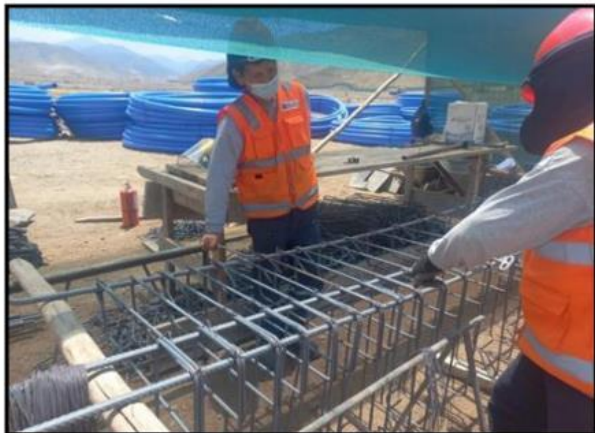
Fotografía N° 09: Habilitación de acero para cisterna
