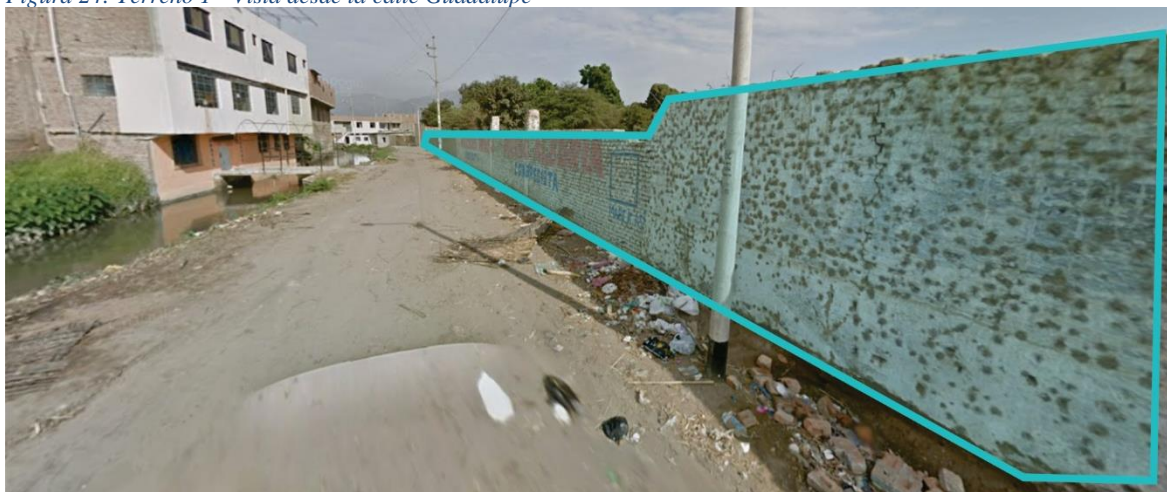
Figura 24: Terreno 1 - Vista desde la calle Guadalupe
