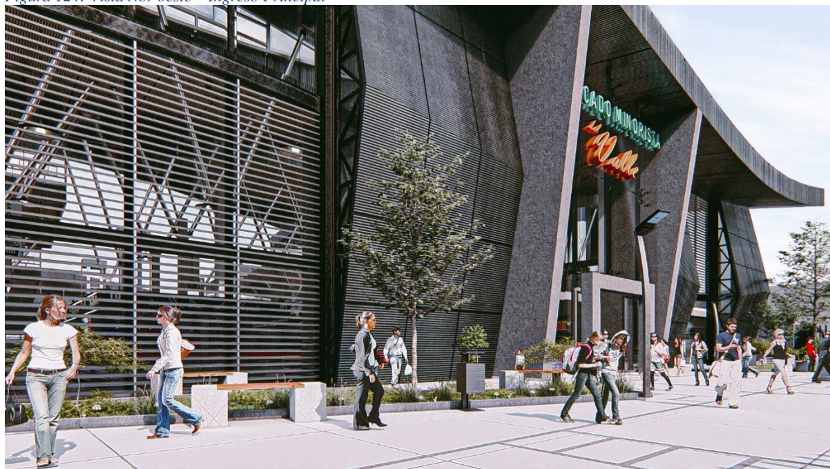
Figura 124: Vista Nor oeste – Ingreso Principal
