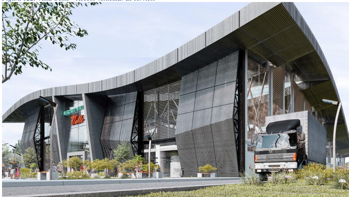
Figura 122: Vista Oeste – Acceso vehicular de servicio
