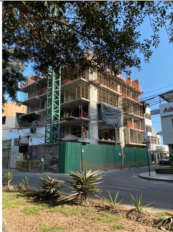
Residencial en etapa de ejecucion
