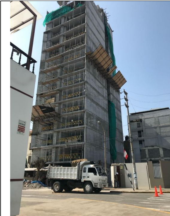
Residencial en etapa de ejecucion
