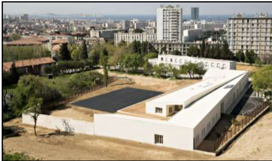
Figura 01. Vista de la fachada principal del caso internacional 01
