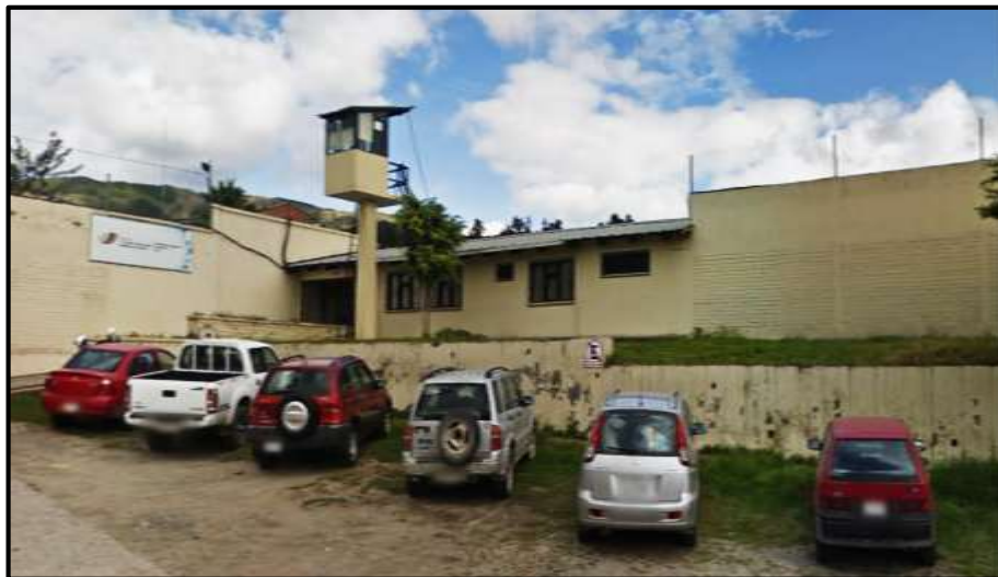
Figura 02. Vista de la fachada principal del caso internacional 02
