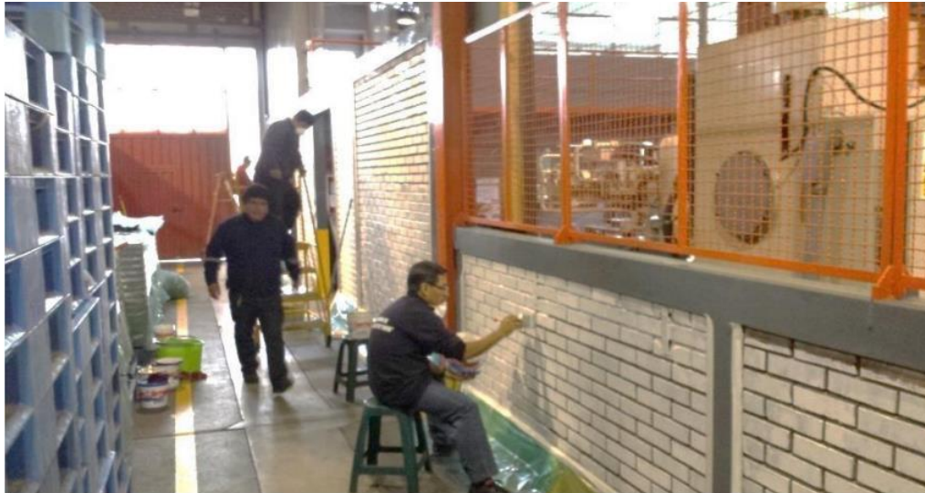
Figura 16. Limpieza y pintado del área Fuente: Elaboración propia.
