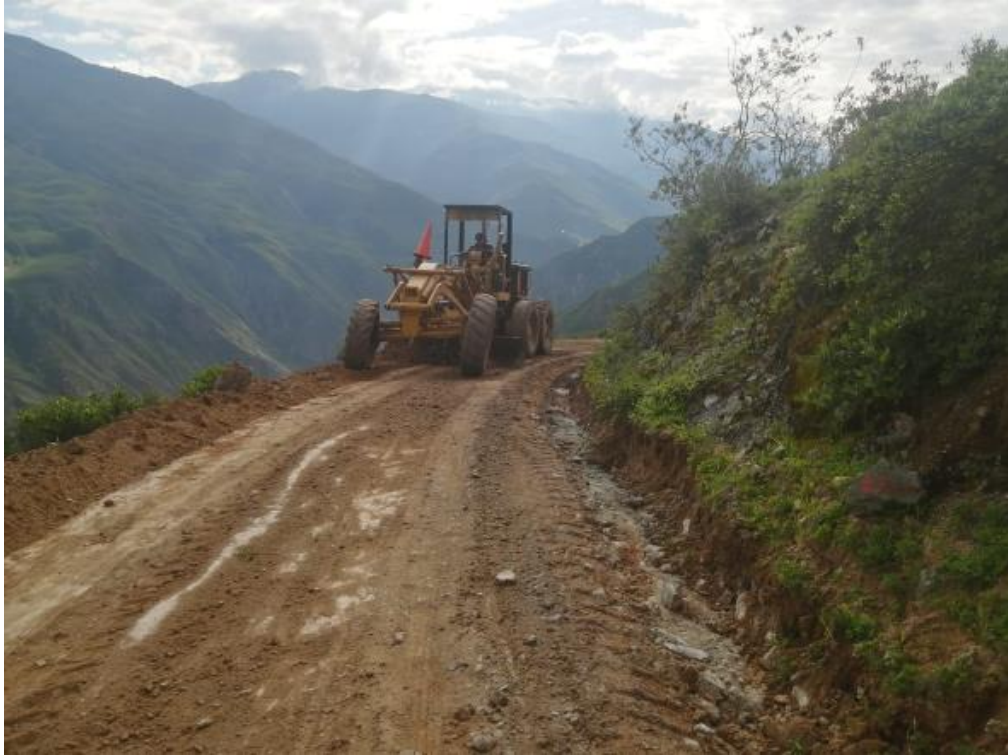
Figura 43. Nivelación de afirmado con Motoniveladora
