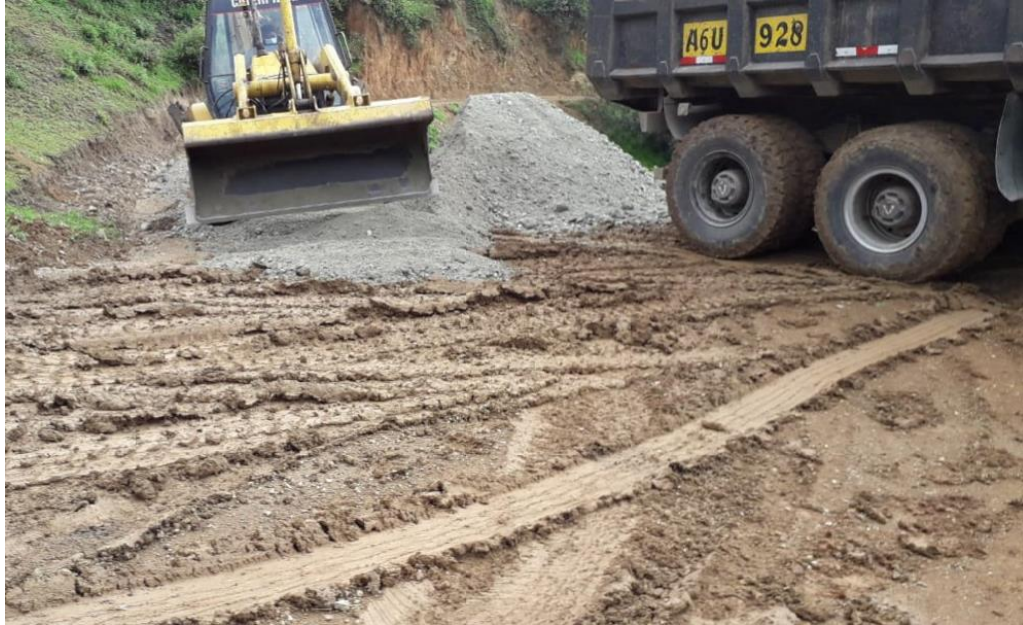
Figura 42. Esparcimiento de Material de cantera con retroexcavadora
