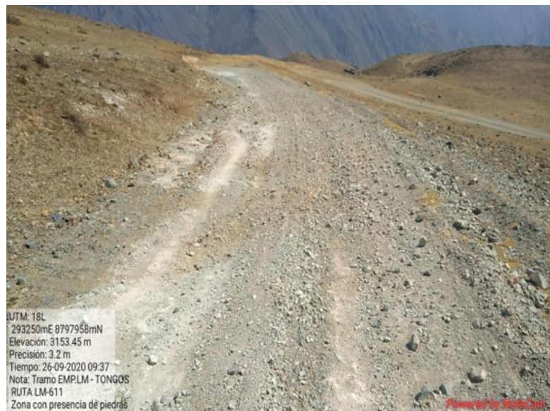
Figura 16. Primera visita - material desprendido de la vía
