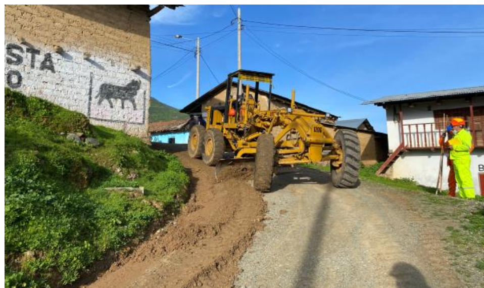
Figura 47. Reconformación de cunetas con motoniveladora
