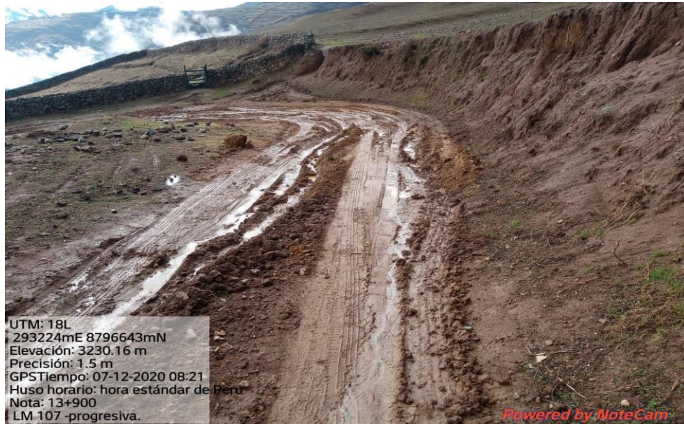
Figura 79. La imagen muestra la vía en mal estado en la progresiva 13+900 a consecuencia de las lluvias intensas registrada durante la semana
