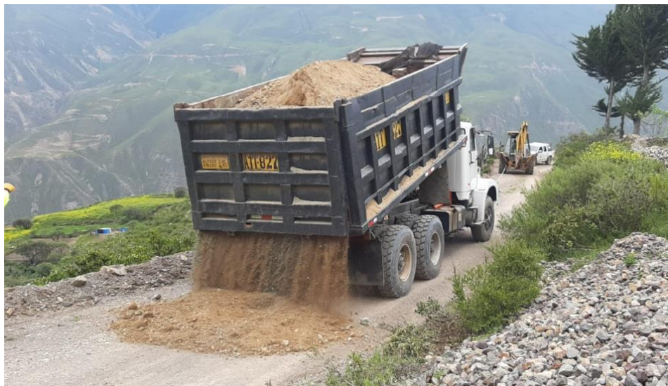
Figura 41. Colocación de material de cantera con volquete E=0.15m
