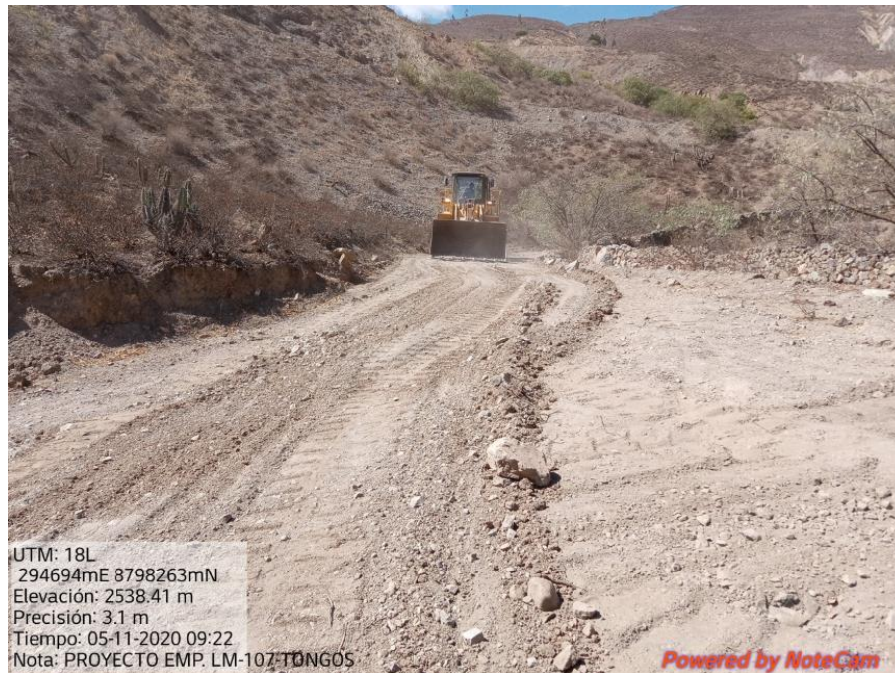
Figura 39. Retroexcavadora realizando la partida de Capa Nivelante E=0.05m
