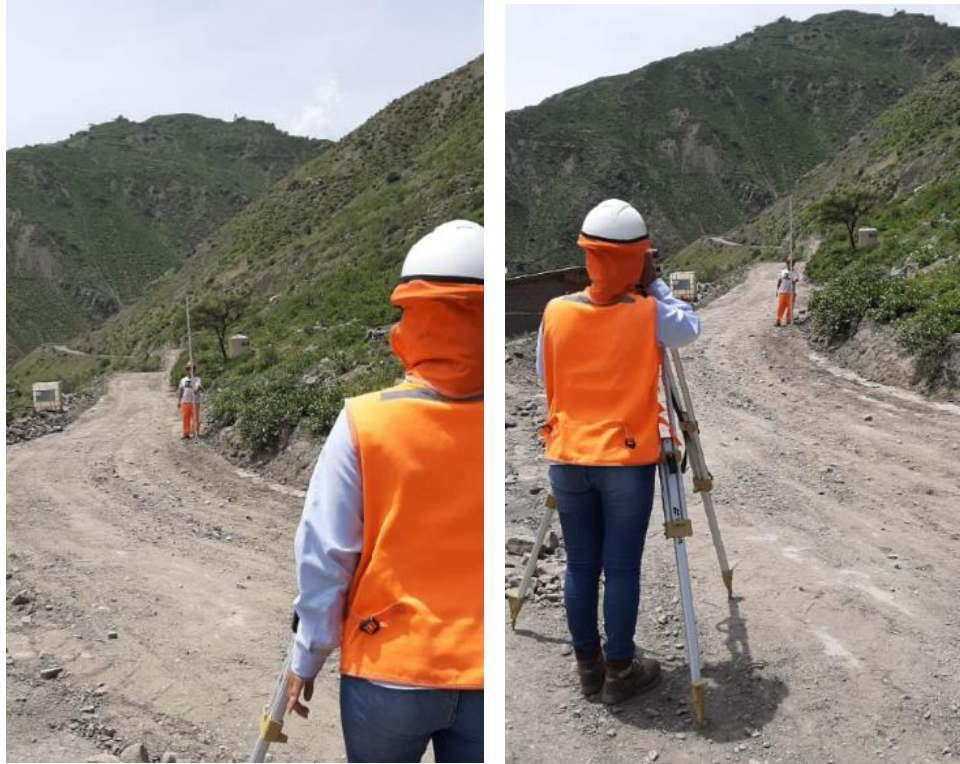
Figura 38. Trazo y Replanteo
