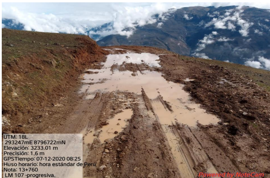
Figura 80. La lluvia intensa ha inundado tramos en la carretera en mantenimiento, dejándola peligrosa para su transitabilidad
