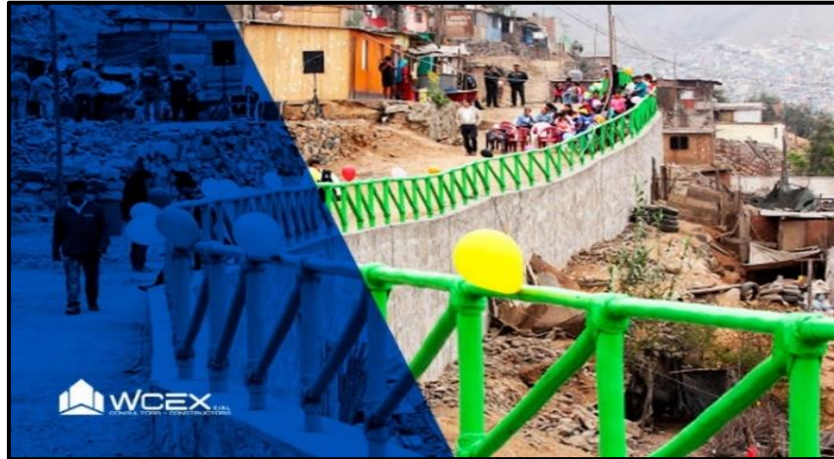
Figura 3. Construcción de Muro de Contención
