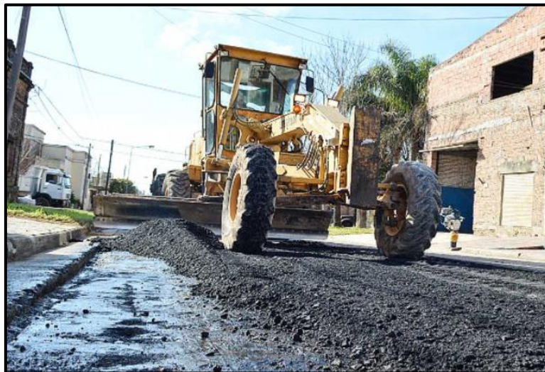
Figura 4. Mejoramiento de Vía auxiliar Túpac Amaru
