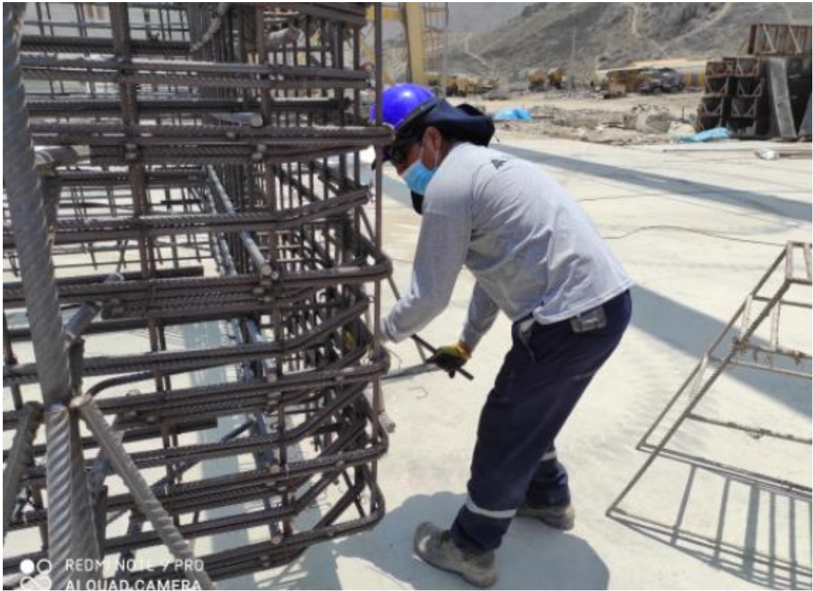
Instalación de la armadura del Box
