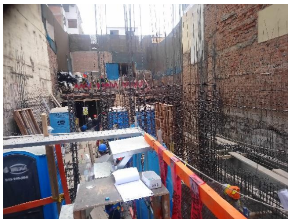
Figura 32. Obra ejecutada en la inspección
