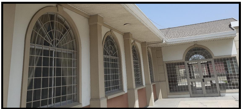
Figura 21. Pintado de muro exterior del edificio.
