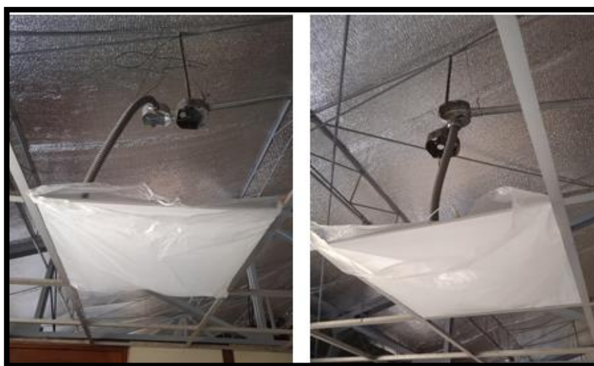
Figura 32, Reemplazo de luminarias Led
