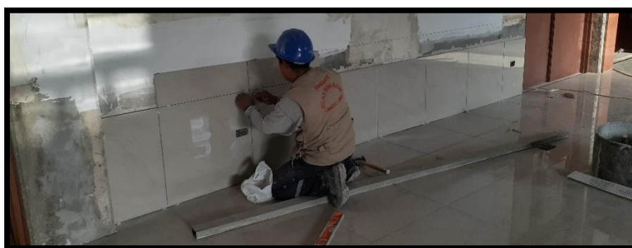
Figura 36, Colocación de porcelanato en piso y pared
