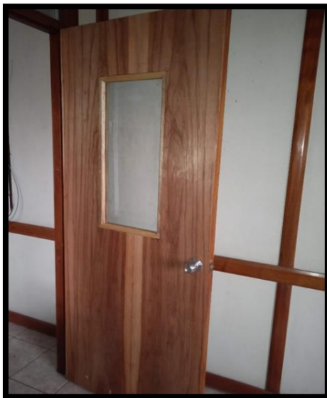
Figura 8. Mantenimiento y cambio de puertas
