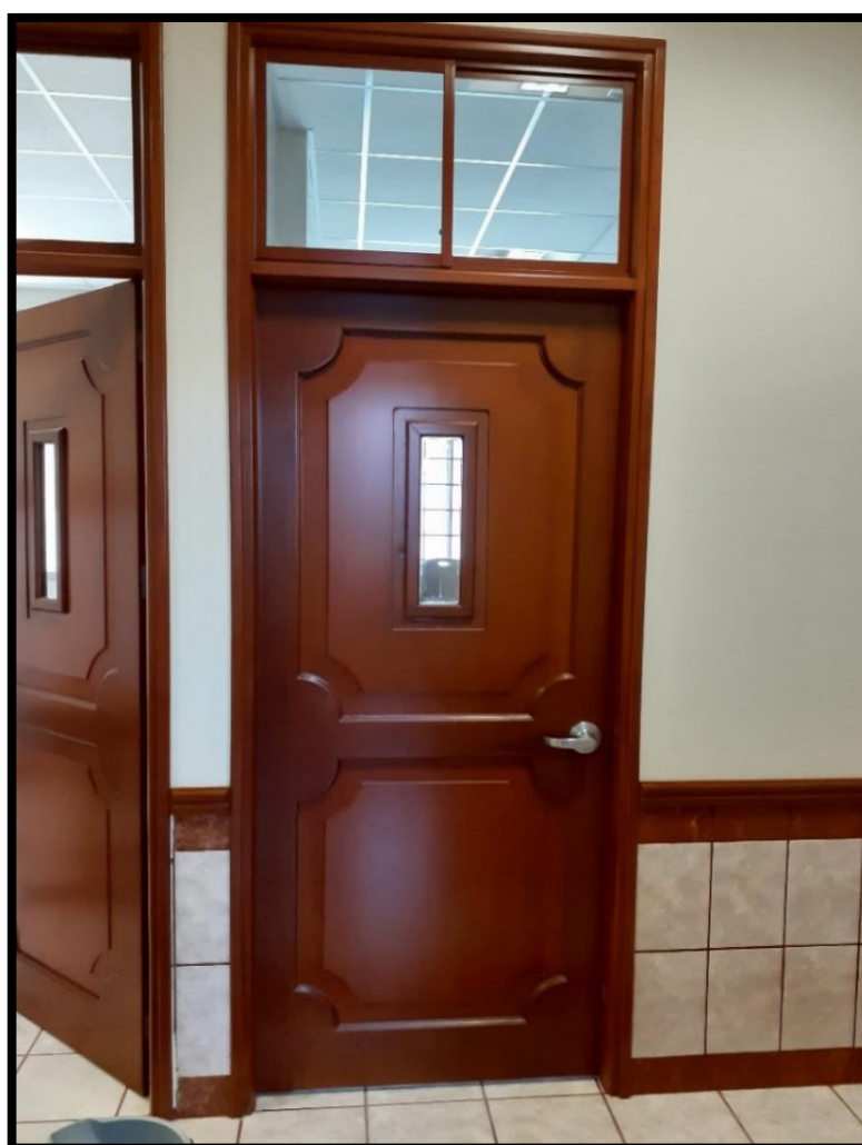
Figura 25, acabado final de pintado de madera en puertas utilizando BIM
