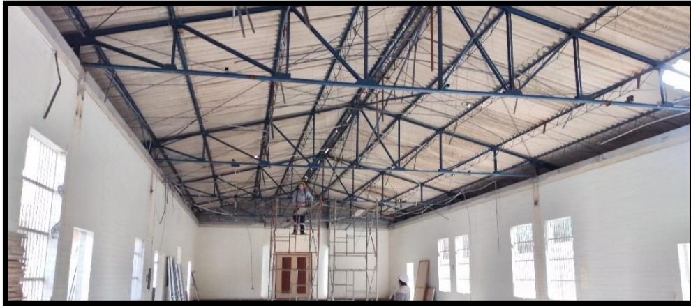
Figura 16. cambio de cielo raso con baldosa.
