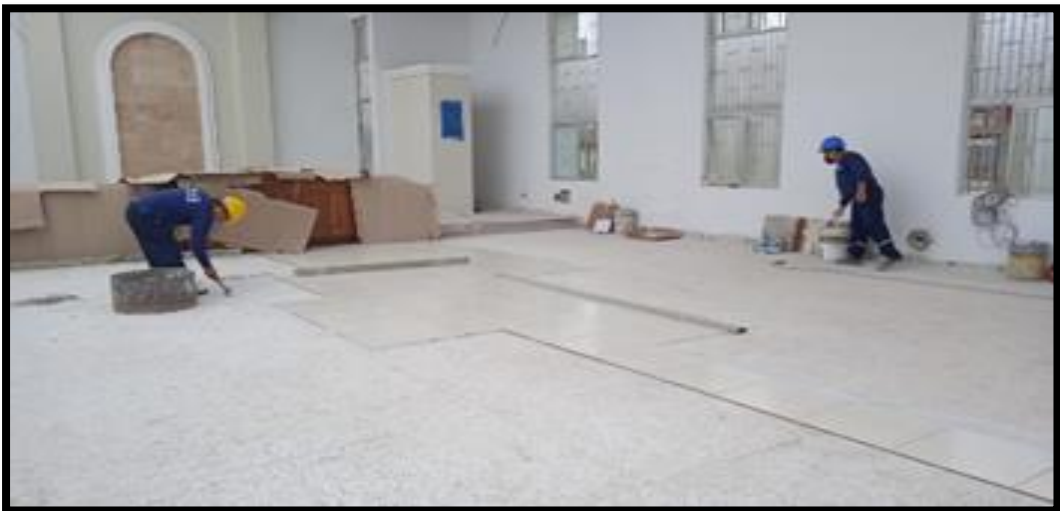
Figura 7. Colocación de porcelanato
