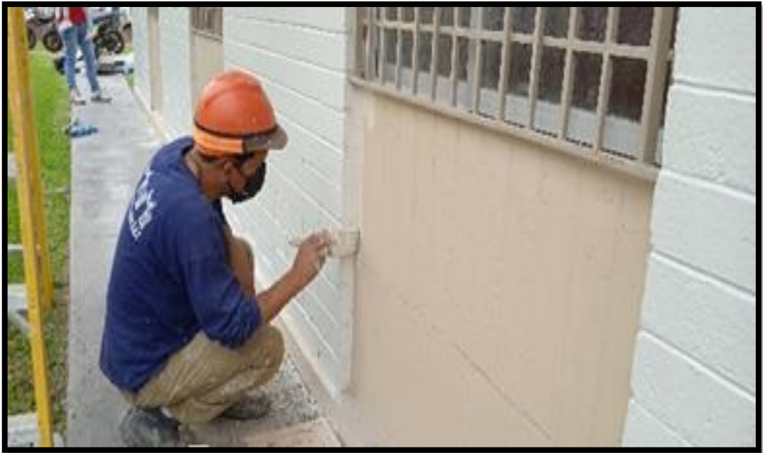
Figura 6. Pintado de muro exterior
