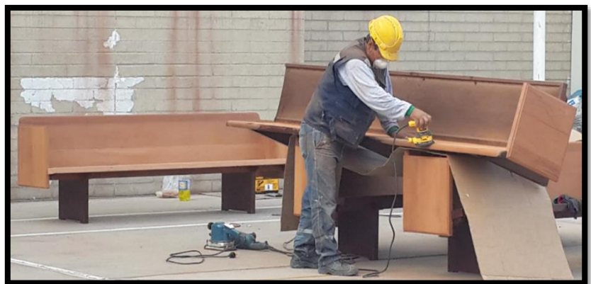
Figura 27, decapado de bancas Fuente: elaboración propia
