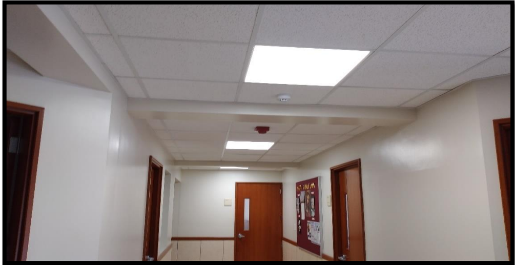
Figura 22, pintado de pared interior del edificio.
