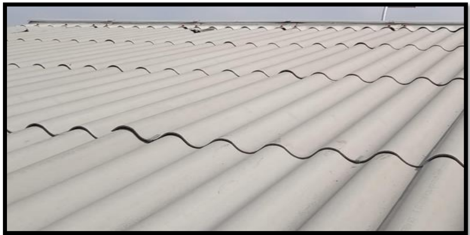
Figura 34, Eternit nuevo, instalado correctamente con BIM
