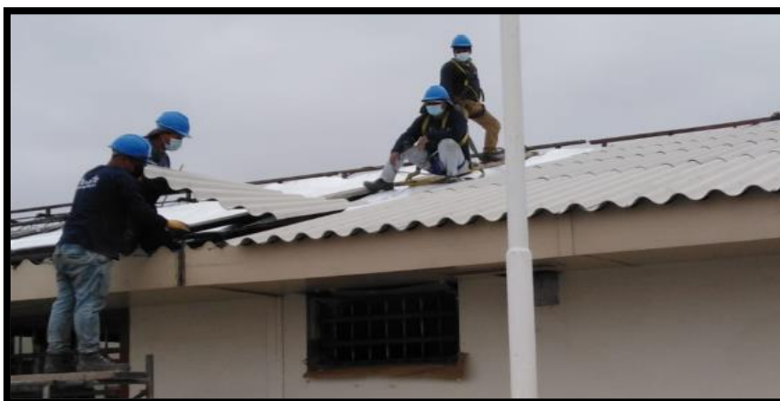
Figura 13. Cambio de cobertura de todo el edificio
