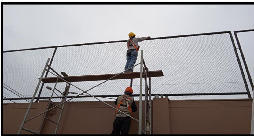
Figura 11. Mantenimiento de malla olímpica de 2"x2"
