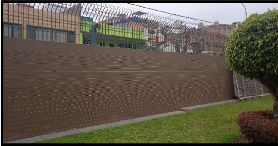
Figura 12. Cerco perimétrico con muro de ladrillo
