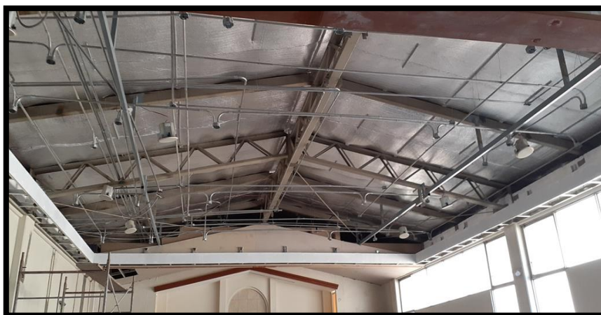
Figura 29, cambio de tuberías Conduit con BIM
