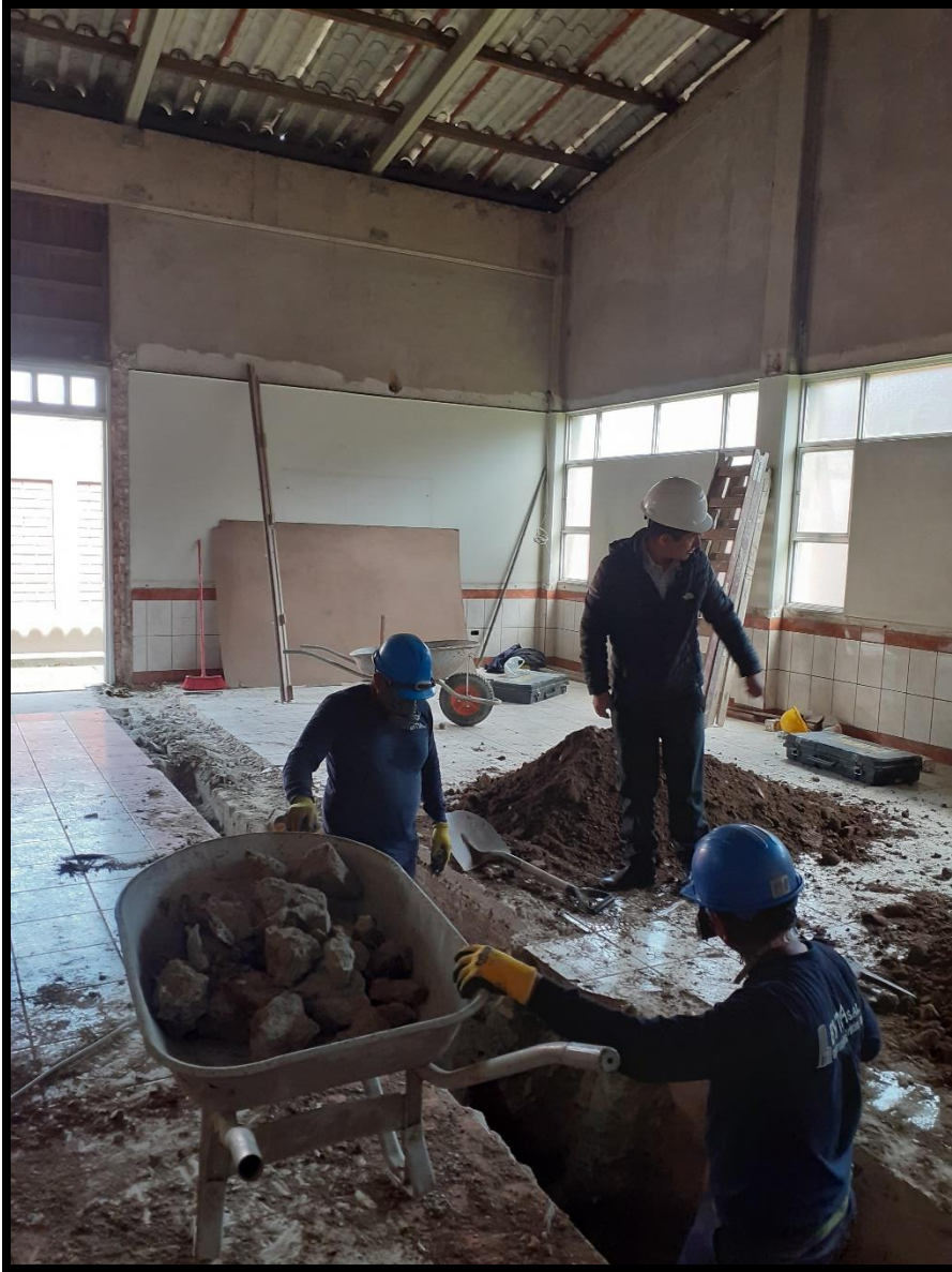
Figura 53. Ampliación y construcción de escenario.
