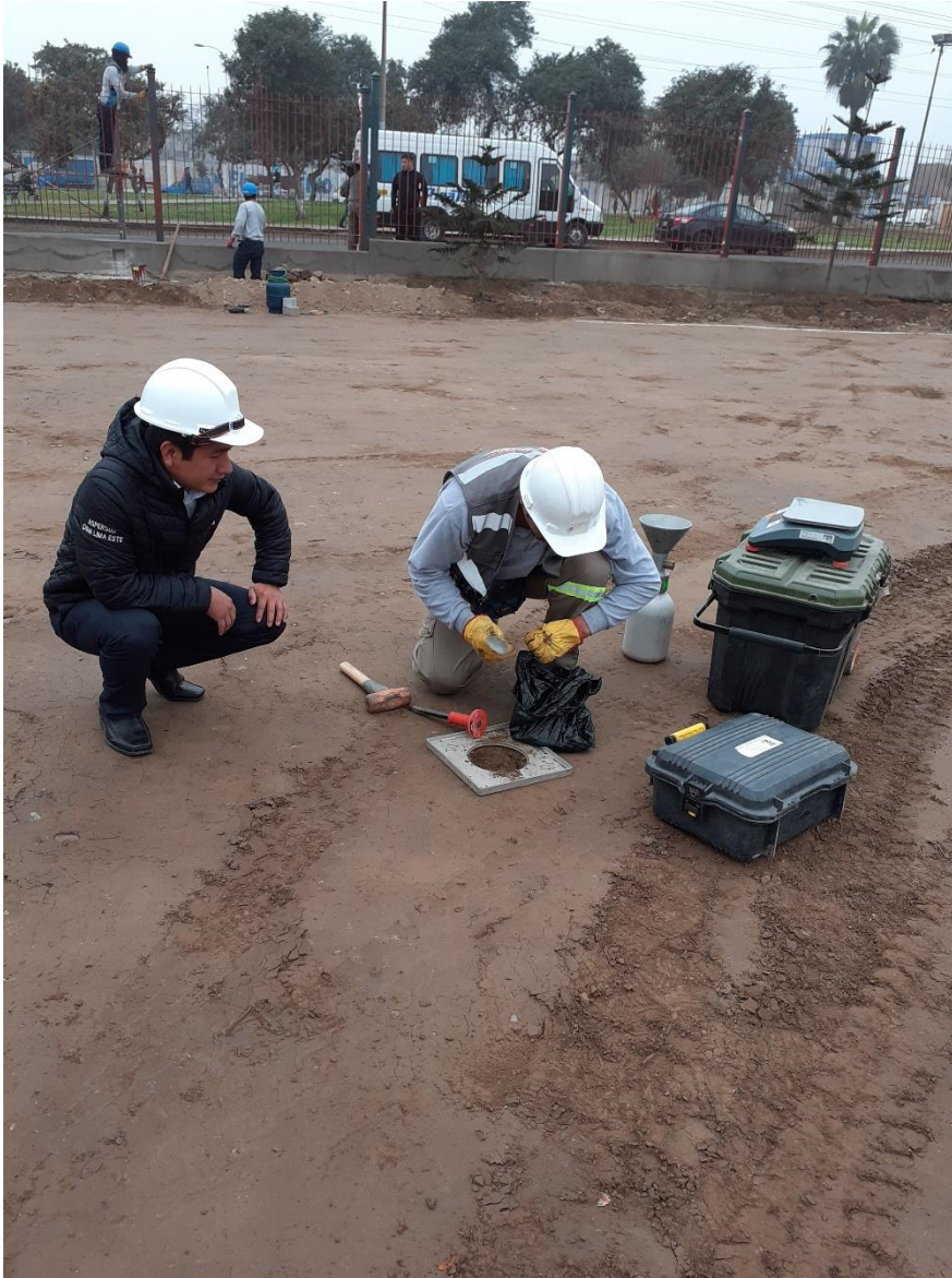
Figura 54. Estudio de suelo, compactación de la rasante
