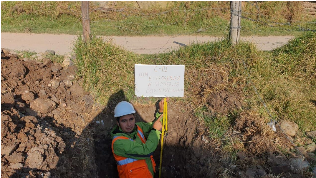
Fotografía 1. Realización de la calicata C-01 con una profundidad de 1.80 m.
