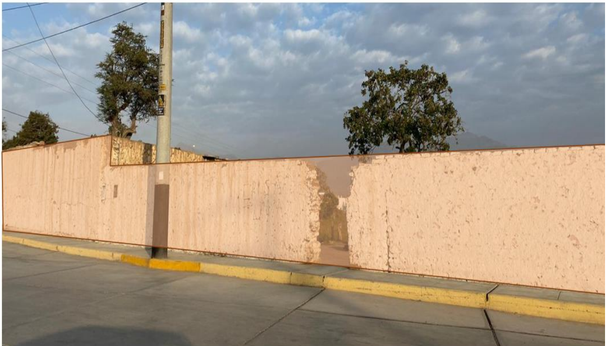
Figura 27: Vista del terreno desde la Prolongación Guadalupe
