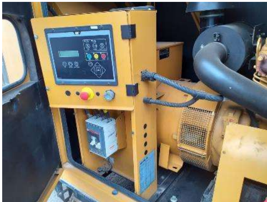
Figura 5. Servicio de mantenimiento y reparación de grupos electrógenos
