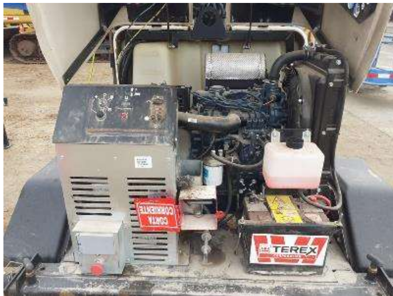
Figura 3. Servicio de mantenimiento y reparación de torres de iluminación
