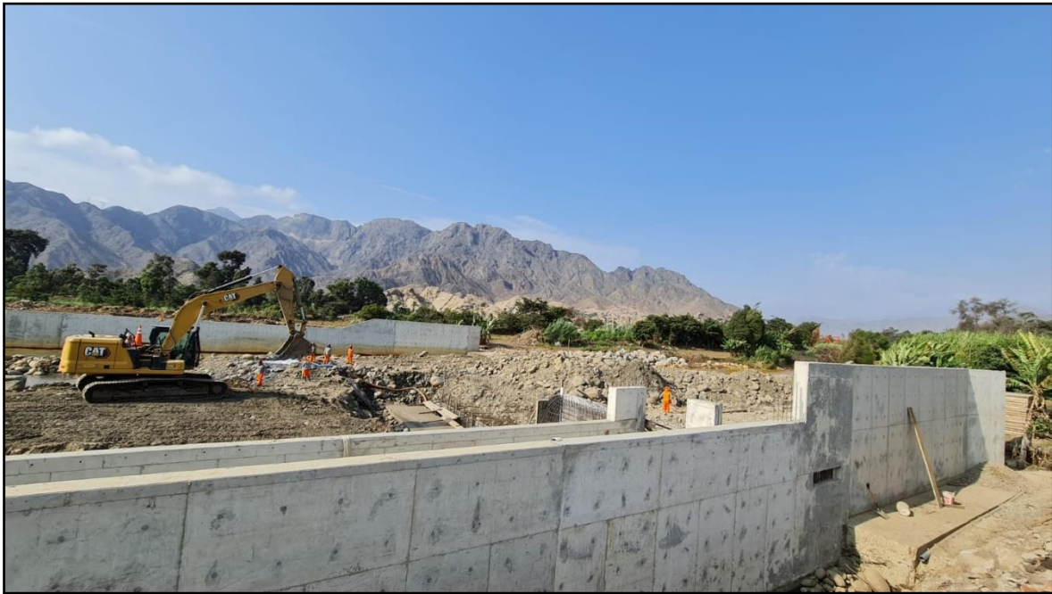
Figura 77: Ejecución de barraje fijo.
