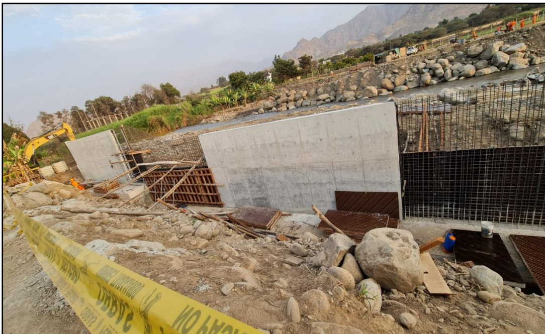
Figura 72: Encofrado y desencofrado con paneles fenólicos en pantallas de Muro de Contención – Margen Izquierdo.
