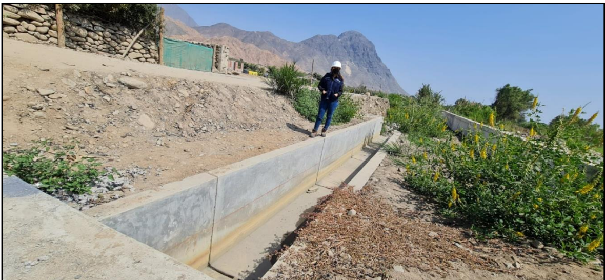
Figura 84: Karla Alegre, Canal de Empalme – Ejecución al 100 %
