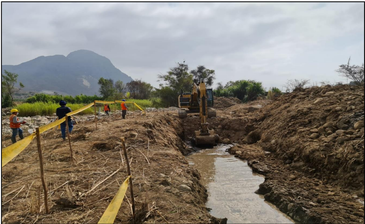
Figura 69: Excavación Masiva en Muro de Contención – Margen Izquierdo
