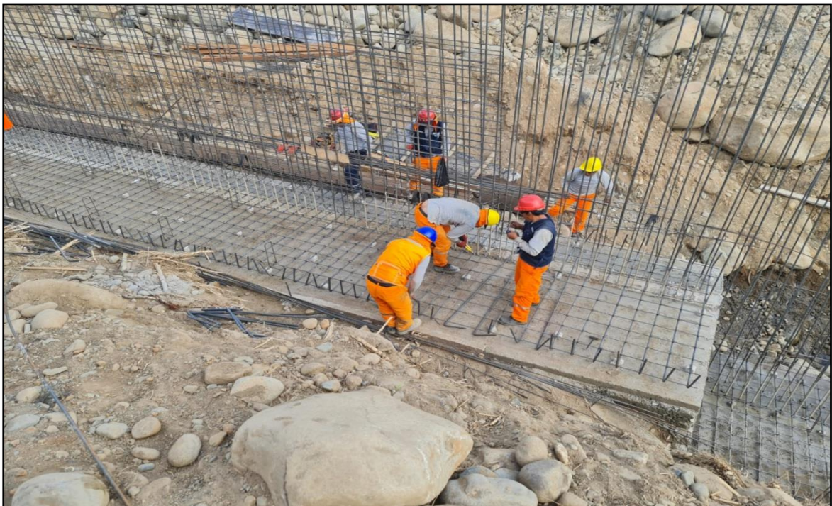
Figura 70: Proceso de armado de acero en zapata y pantalla de muro de contención.
