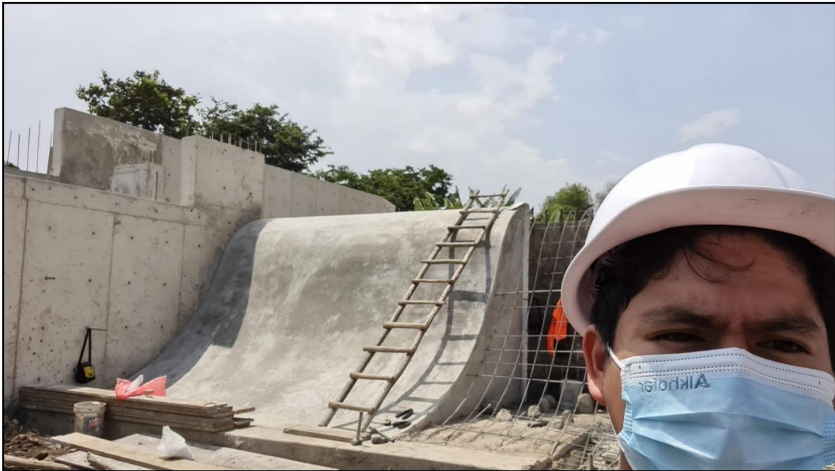
Figura 79: Edwin Pérez en Obra - Ejecución de barraje fijo.
