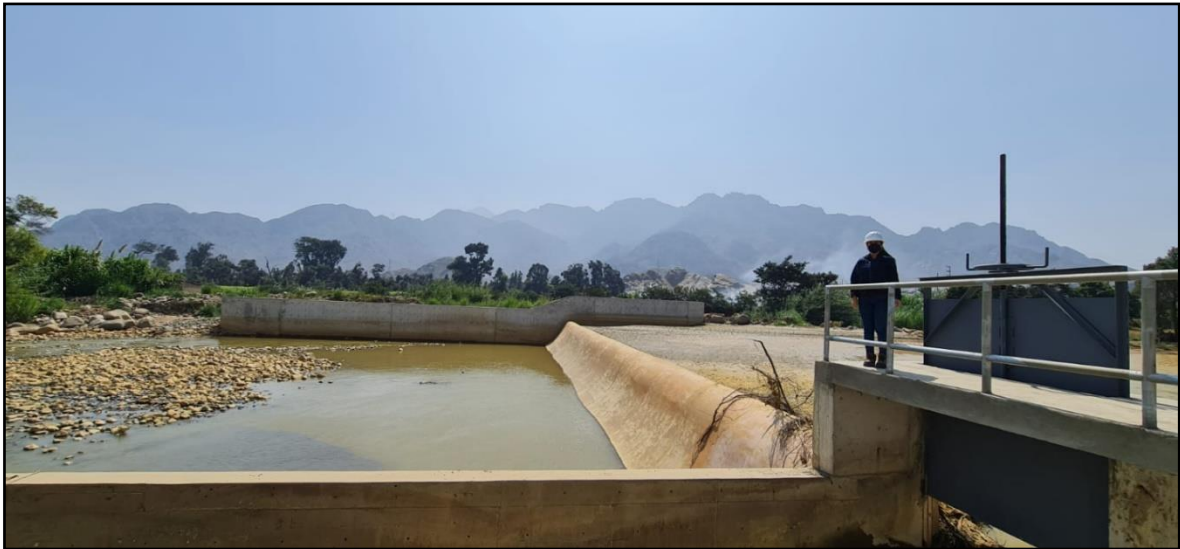
Figura 83: Karla Alegre en Bocatoma Huatape – Ejecución al 100 %
