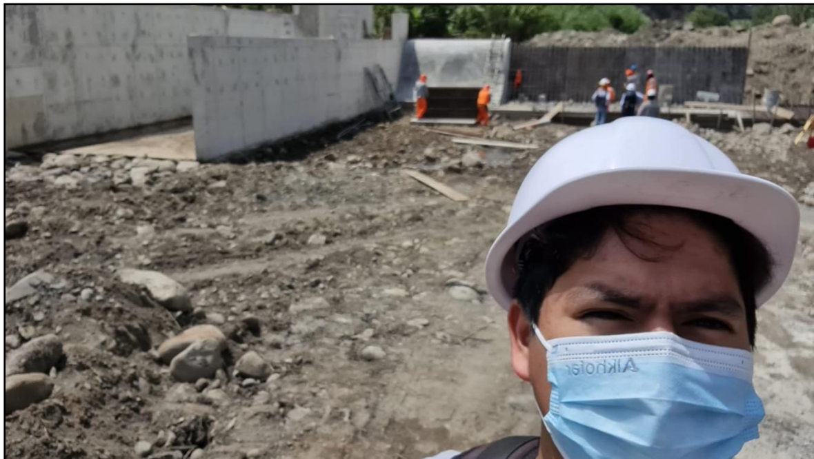
Figura 78: Edwin Pérez en Obra - Ejecución de barraje fijo.
