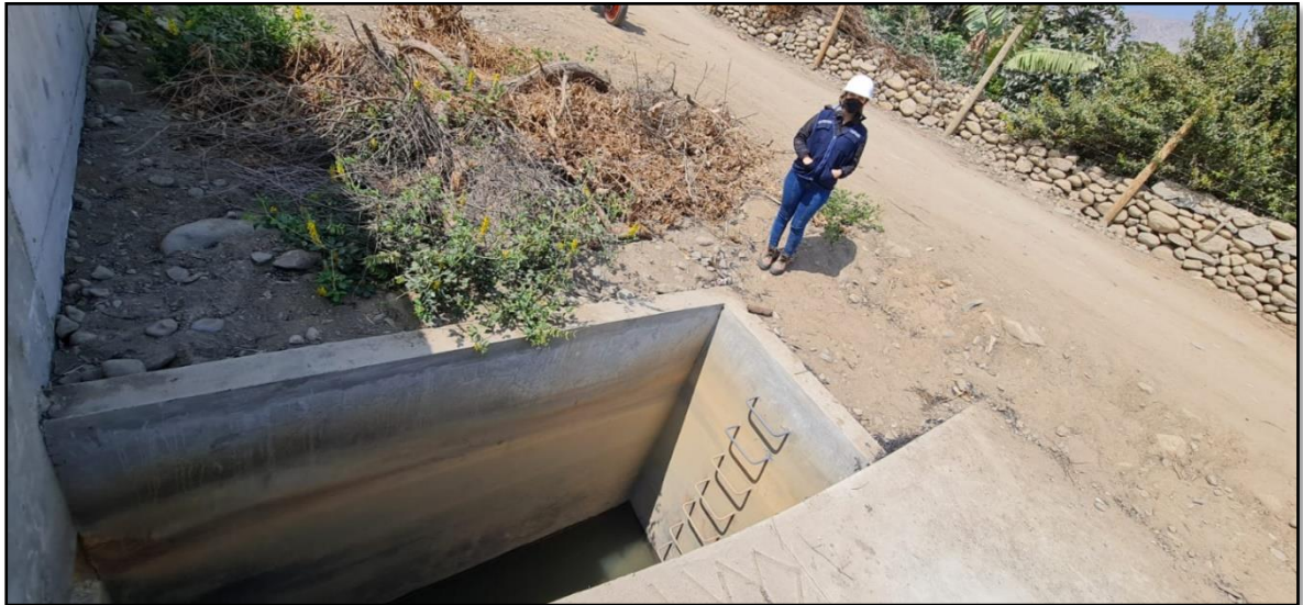
Figura 85: Karla Alegre, Poza Disipadora – Ejecución al 100 %
