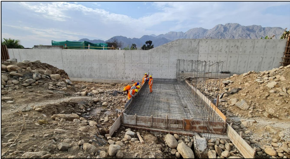
Figura 73: Ejecución de zapata en Barraje fijo.
