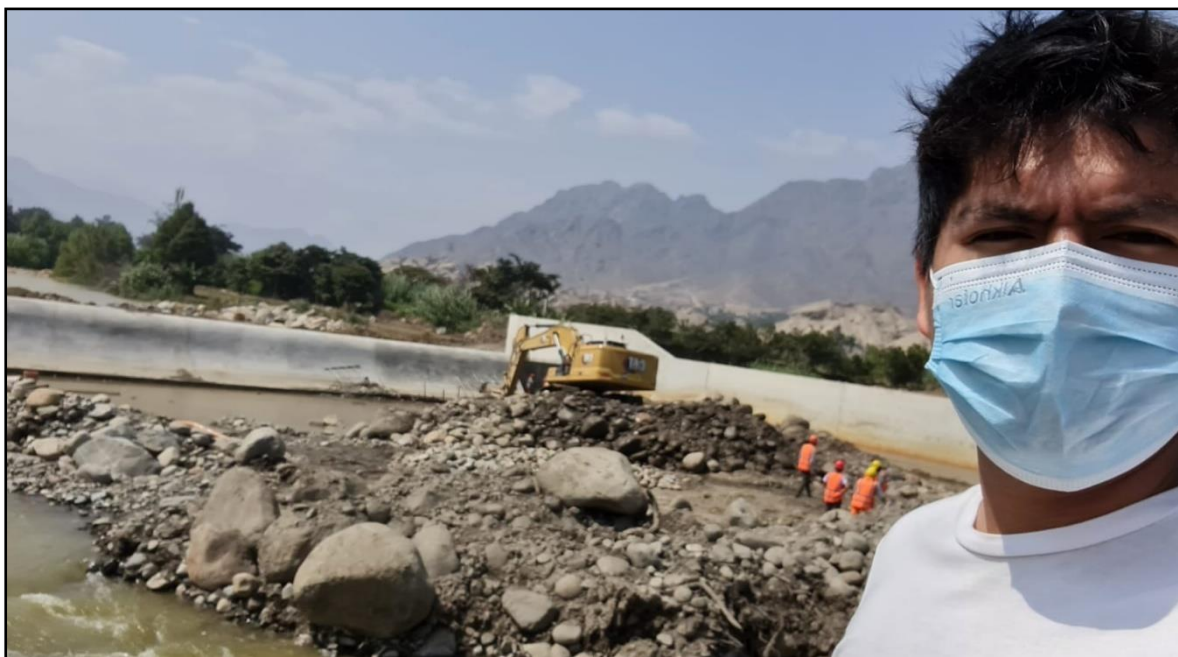
Figura 80: Edwin Pérez en Obra - Ejecución de Plataforma de Salida.
