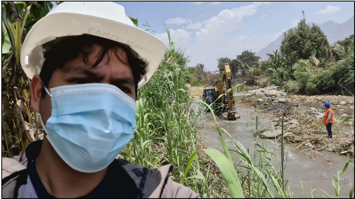
Figura 67: Edwin Pérez en Obra – Actividad de Desvío de Río.
