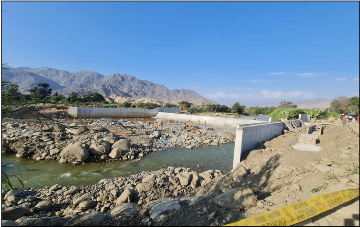
Figura 81: Ejecución de Plataforma de Entrada y Salida.
