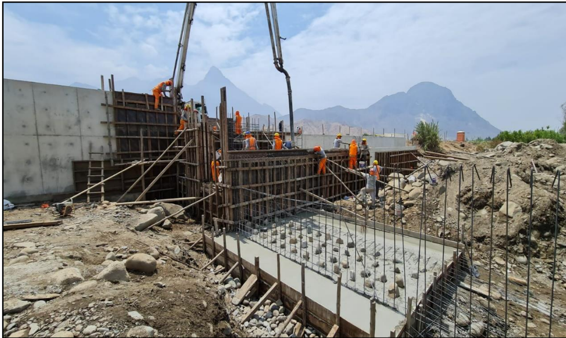
Figura 75: Ejecución de Barraje móvil y Barraje fijo.
