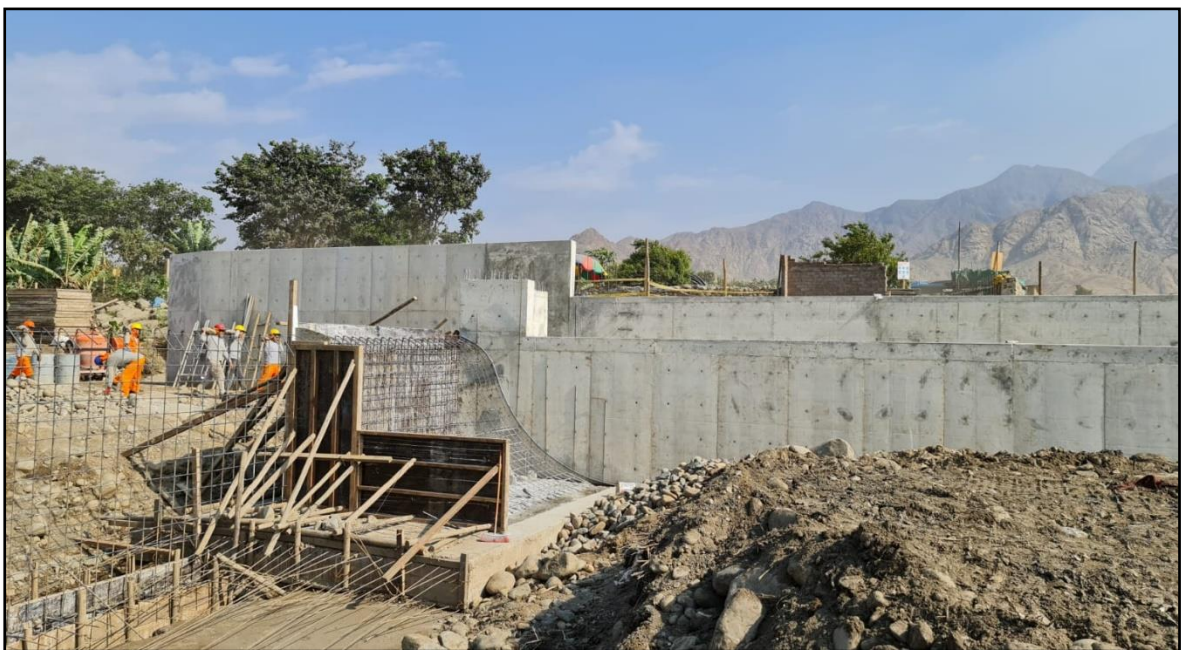
Figura 76: Ejecución de Barraje móvil y Barraje fijo.
