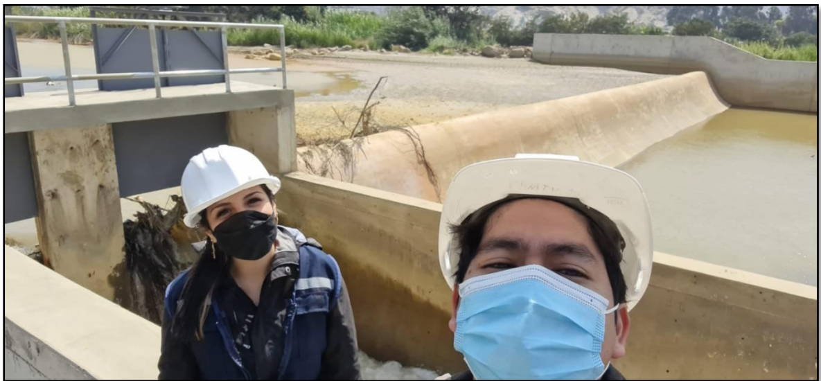
Figura 86: Karla Alegre y Edwin Pérez en Bocatoma Huatape – Ejecución al 100 %
