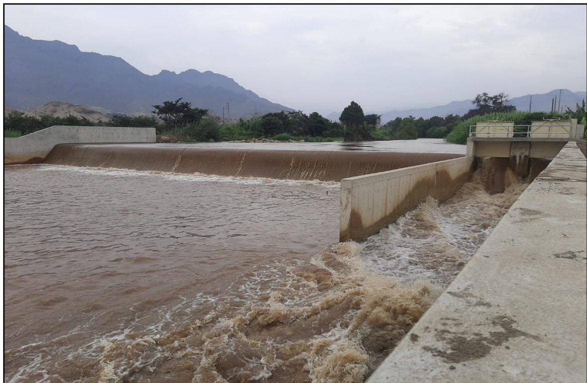
Figura 82: Bocatoma Huatape – Ejecución al 100 %
