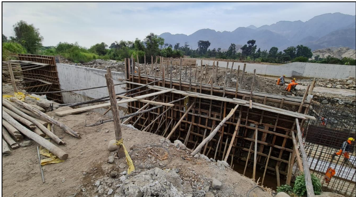
Figura 74: Ejecución de Muro de Contención Margen Derecha.
