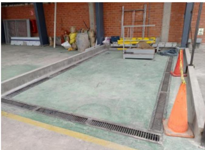
*Figura 30.* Instalación de la bahía de lavado para los vehículos. Fuente: Catalogo de fotos internas Renting SAC.
