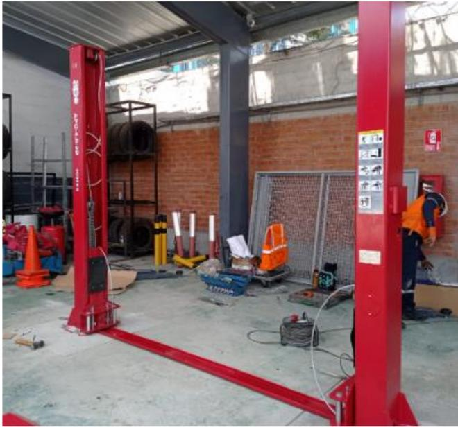
*Figura 29.* Instalación de elevadores automotrices de dos postes. Fuente: Catalogo de fotos internas Renting SAC.
