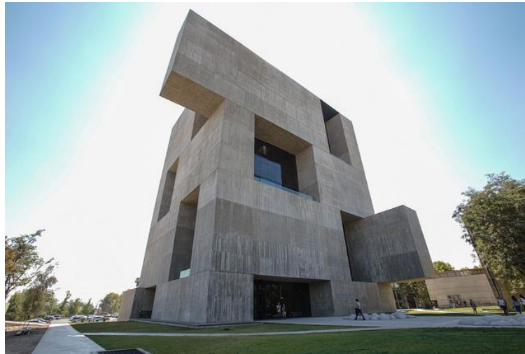
Figura 4. Vista principal de caso número 4. Fuente: Archdaily, 2017
