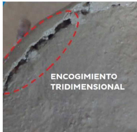
Figura 13: Retracción por secado
