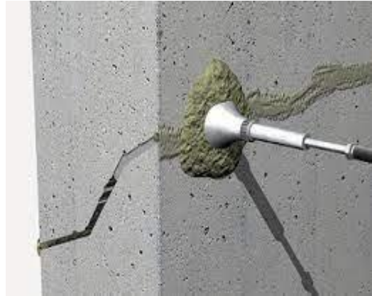
Figura 28: Inyección de resina epoxi en fisuras
