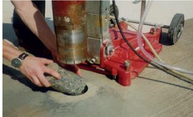
Figura 27: Toma de núcleos para verificar la profundidad de fisuras
