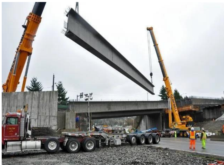
Figura 18: Transporte de elementos prefabricados
