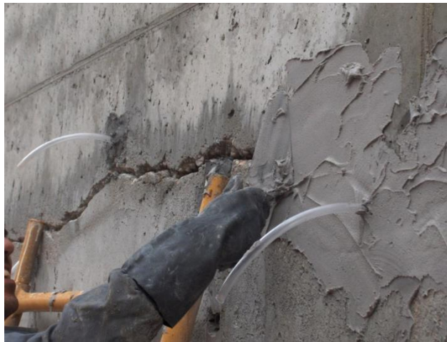
Figura 34: Tratamiento superficial de fisuras
