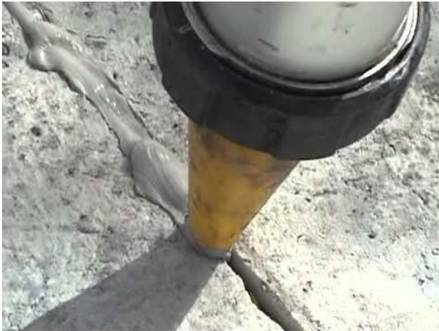
Figura 33: Llenado de fisura con mortero químico
