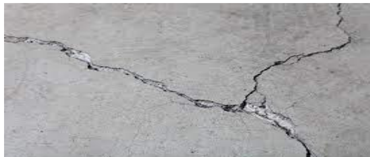
Figura 10: Fisuras
