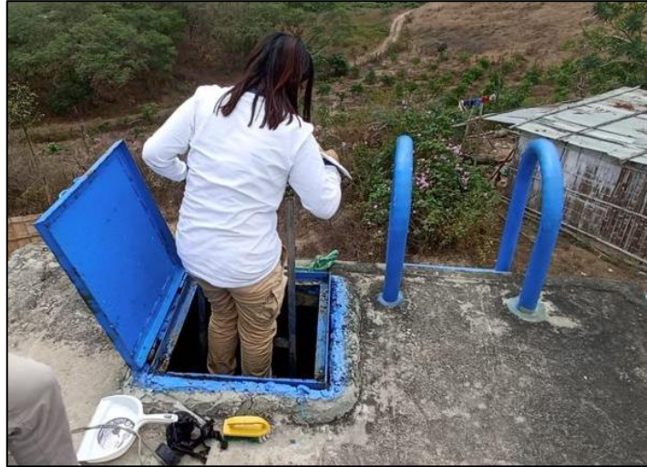
Fotografía 5: Revisión del estado de los componentes del SAP.
