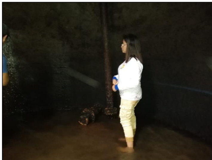
Fotografía 6: Revisión de la estructuras internas de los reservorios de los SAP en el ámbito rural del distrito de Papayal
