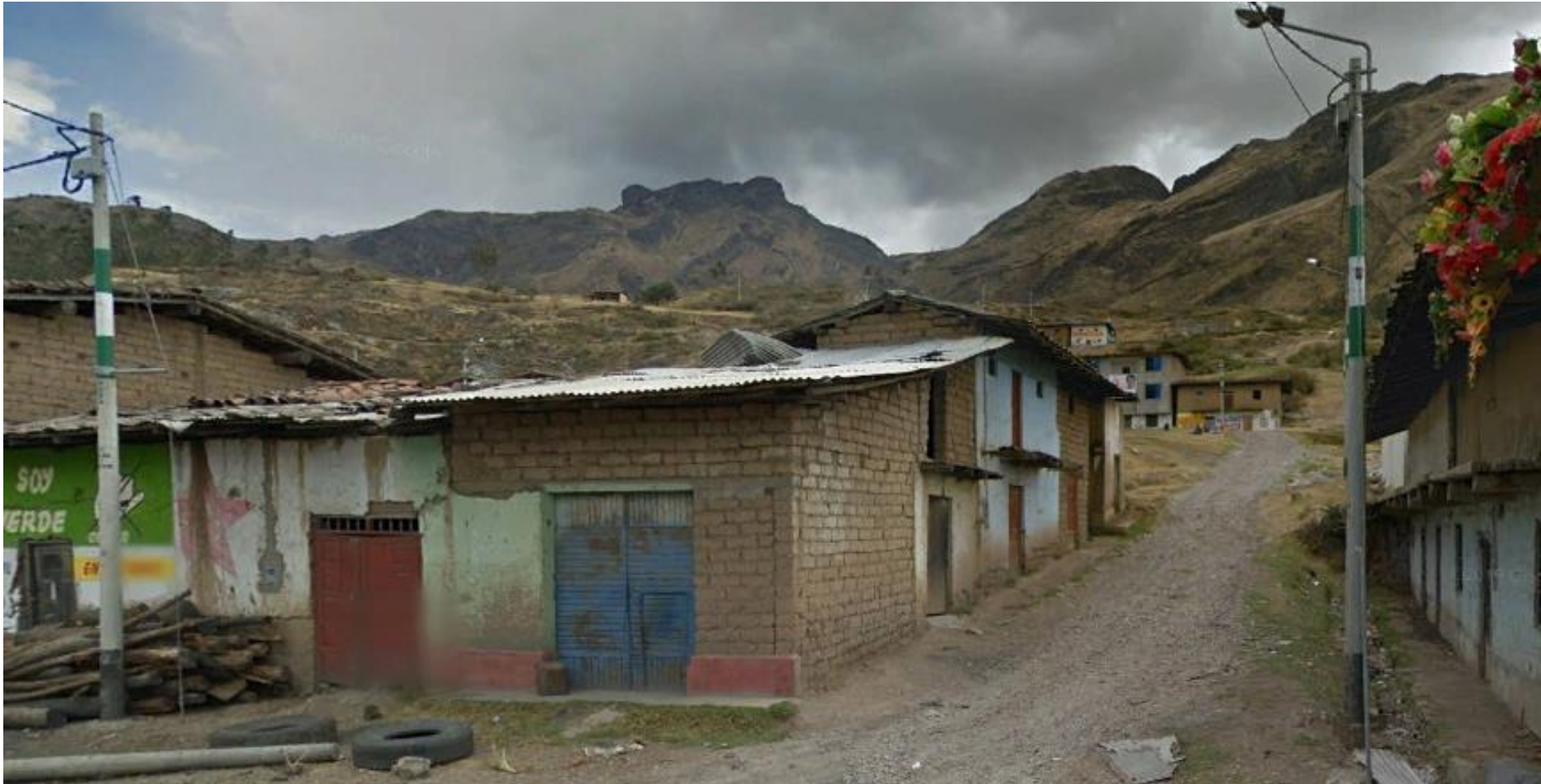
Figura 53: Viviendas del Centro Poblado Rural Carcel, tomada por Juan de Jesus Valdez Barón.
