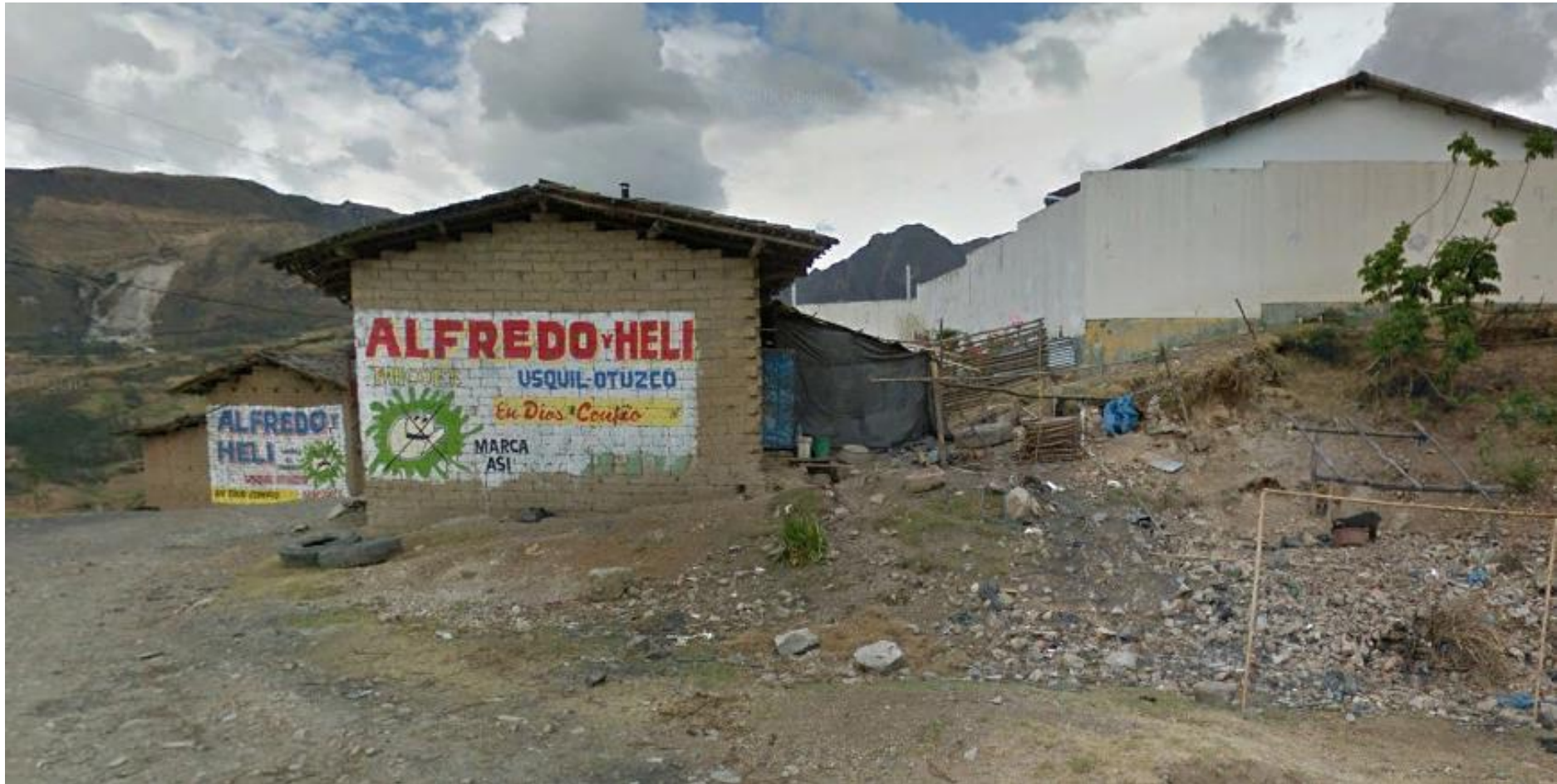
Figura 54: Viviendas del Centro Poblado Rural Carcel, tomada por Juan de Jesus Valdez Barón.
