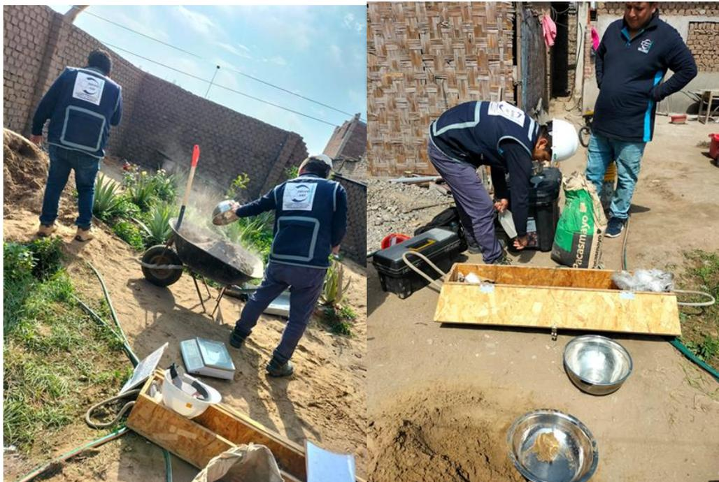
Fotografía 14. Estabilización con muestra de cemento tipo I y ceniza de madera.
