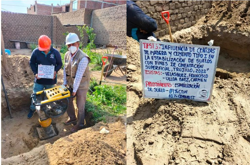
Fotografía 15. Procesos de compactación con cemento y ceniza de madera.
