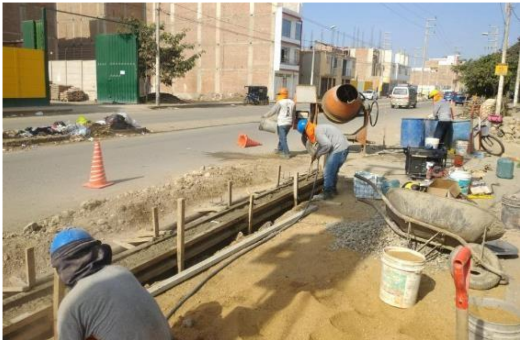
Foto N°02: Construcción de sardineles peraltadas
