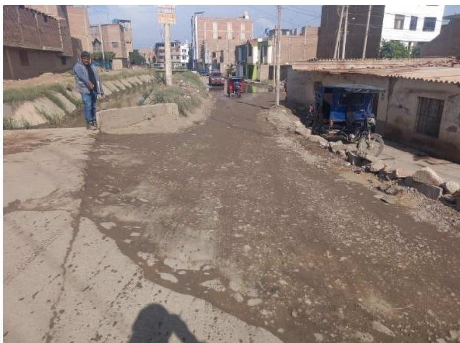
Figura N°39: Tramo del canal donde se ejecutará Parchado Profundo
