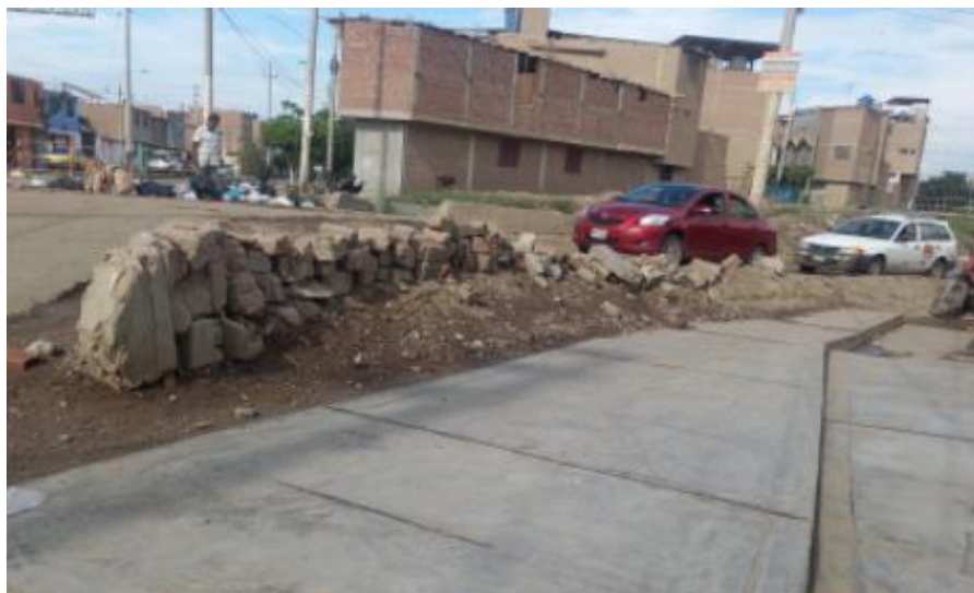
Figura N°38: Vista lateral de la zona de ejecución de parchado profundo
