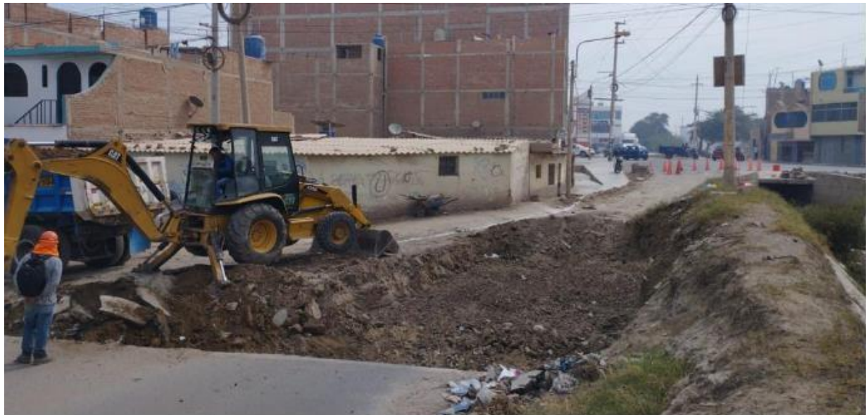
Foto N°04: Excavación para Parchado Profundo
