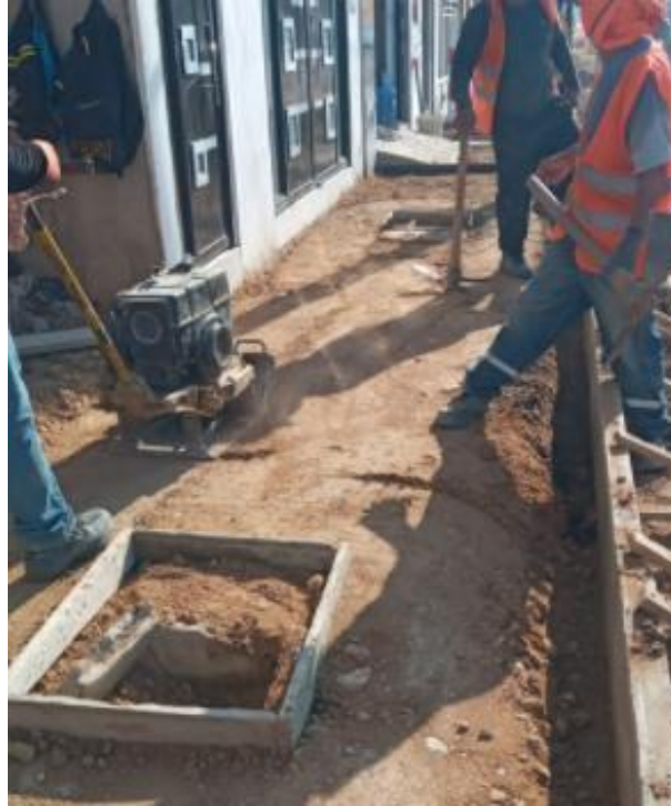
Figura N°21: Ejecución de Adicional de Obra N°01 (Conformación y Compactación de base granular) aprobada.
