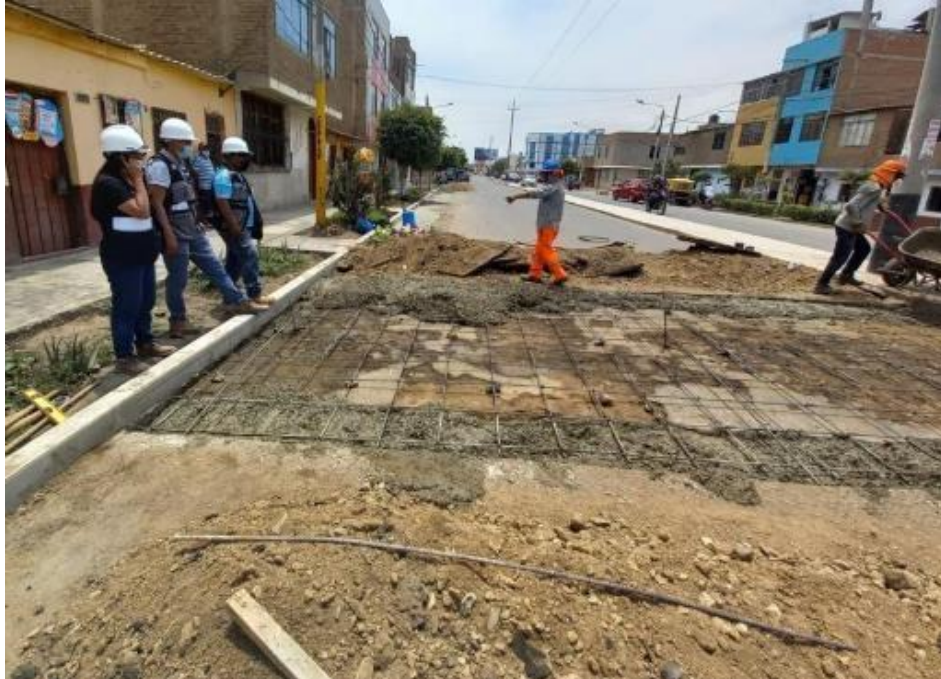
Foto N°07: Construcción de giba de concreto féc.=280kg/cm 2
