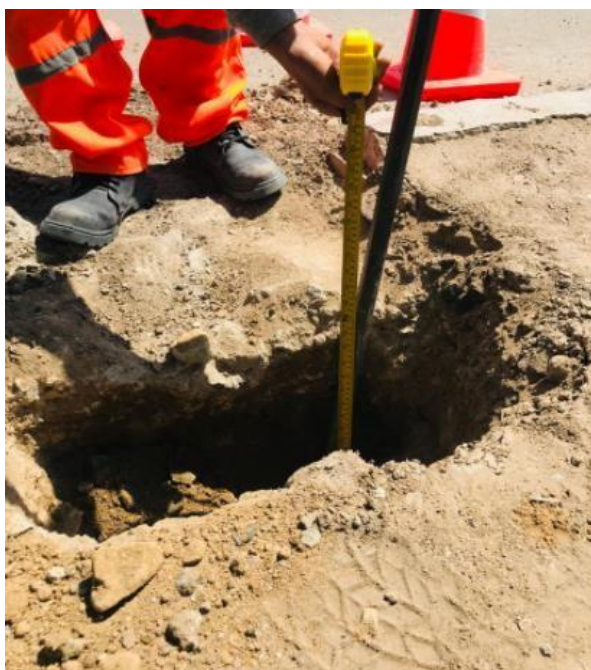
Figura N°37: Base de concreto de sardineles existentes.
