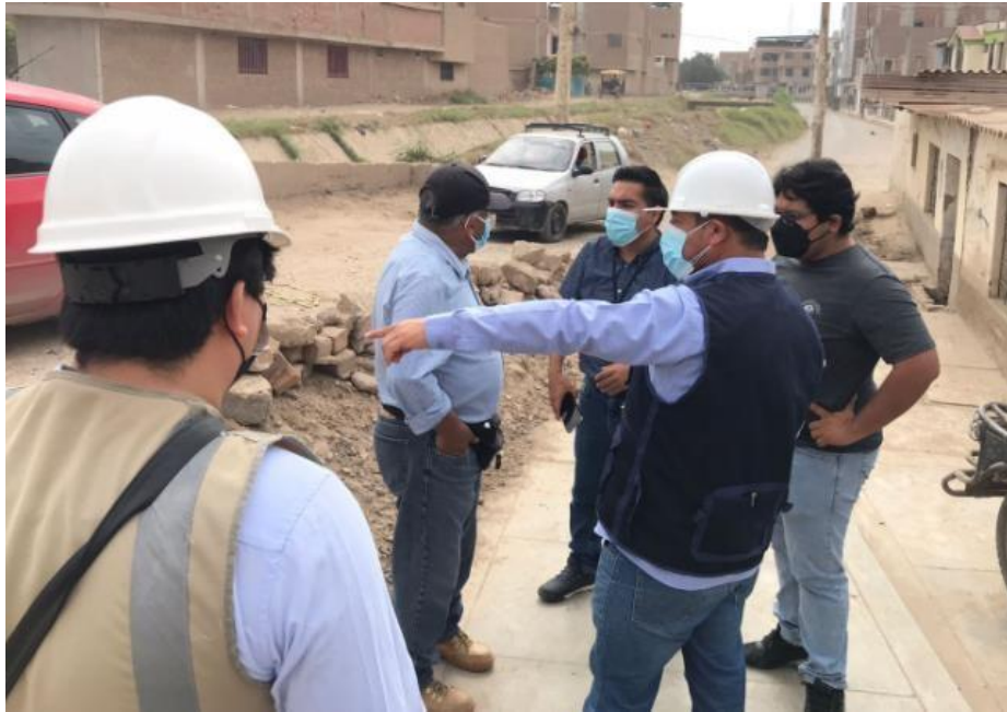
Figura N°40: Diagnostico de necesidades en el tramo del Canal
