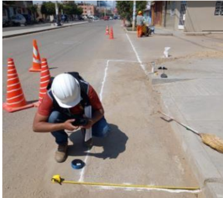
Figura N°41: Verificación de metrados
