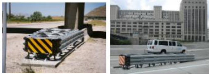
Figura 13 Amortiguadores de impacto. Fuente: Tomada de “AMORTIGUADORES DE IMPACTO QUE SALVAN VIDAS” por Signo Vial.
