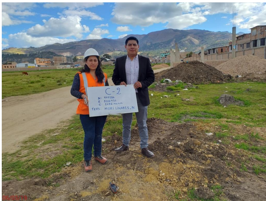
FOTO 16: Coordenadas de la calicata C2.
