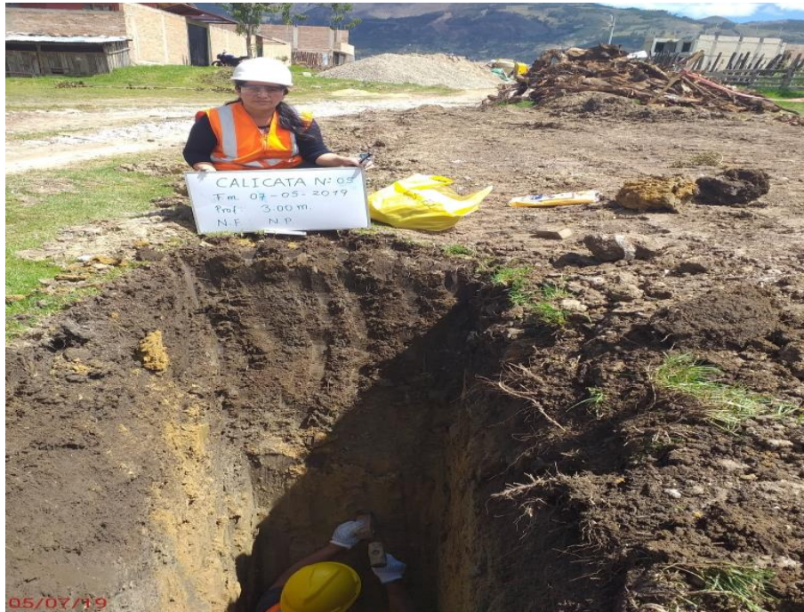
FOTO 5: Perfil de terreno existente en la calicata C5.
