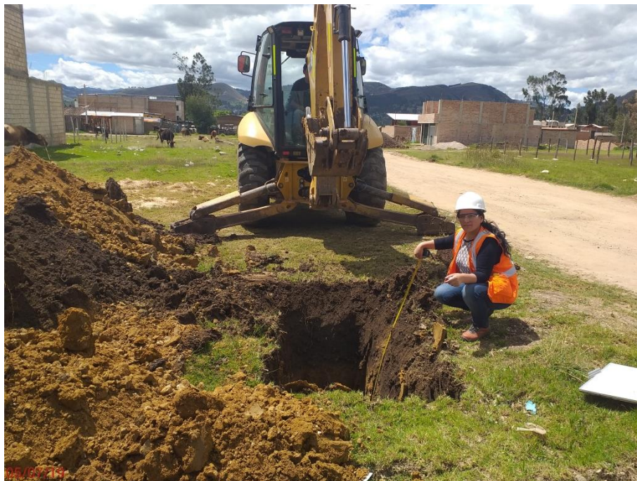
FOTO 4: Verificando la profundidad de las calicatas y de cada uno de los estratos.
