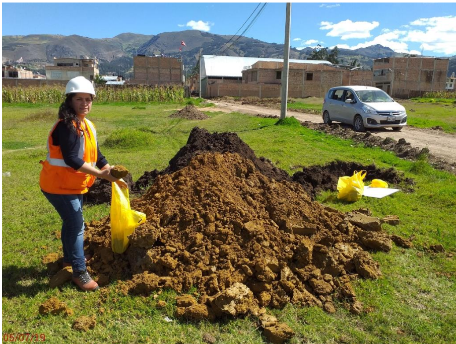
FOTO 2: Material existente en las calicatas, dos estratos diferenciados por los colores.
