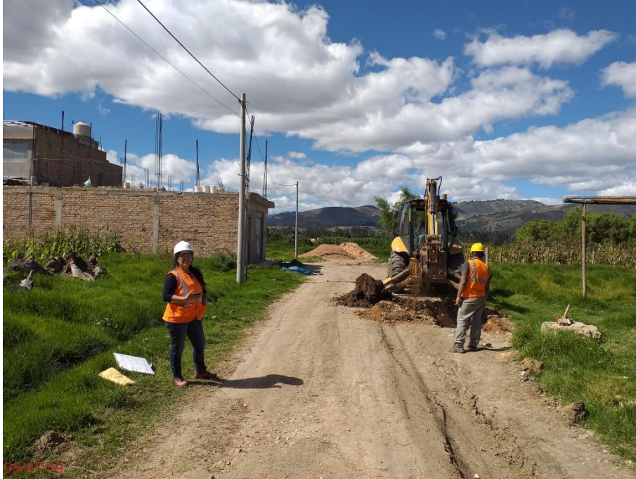
FOTO 1: Excavación de las calicatas.
