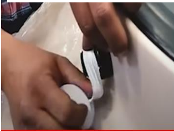
Figura N. 46 Contra tuerca con teflón"
