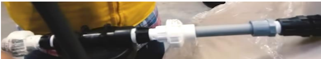
Figura N 48: "Colocación de filtro y llaves universales"
