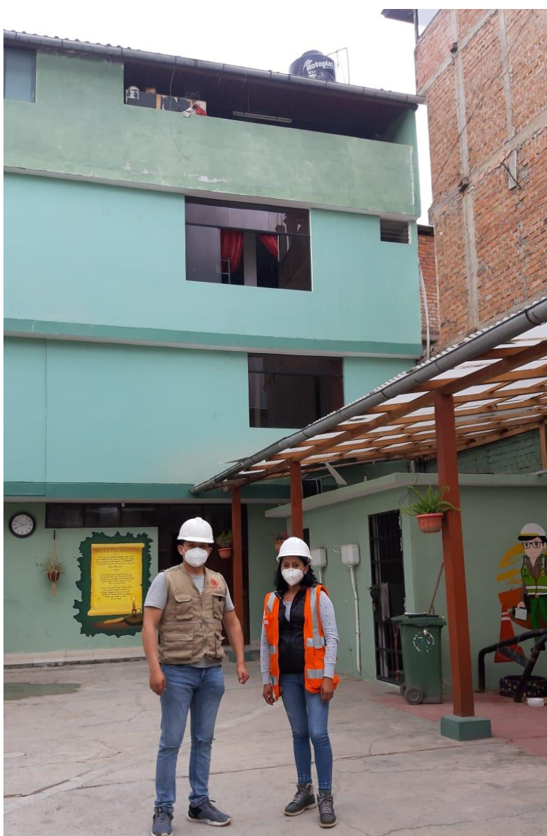
Figura N 61: Tanque elevado no cuenta con acceso para mantenimiento, corresponde a la comisaría de tránsito
