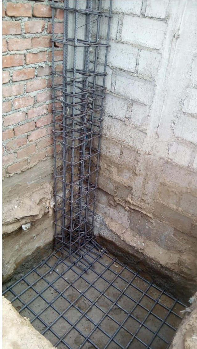
Figura 174. Detalle de armadura de zapata y columna.
