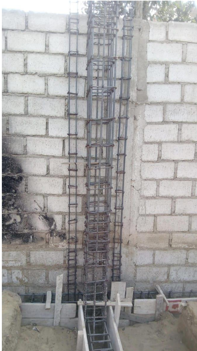
Figura 175. Detalle de armadura de columna y columneta.
