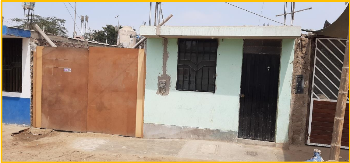
Figura 172. Fachada principal de la edificación en estudio.
