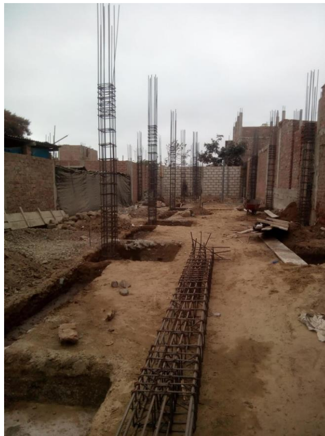
Figura 173. Levantamiento de armadura de columnas.
