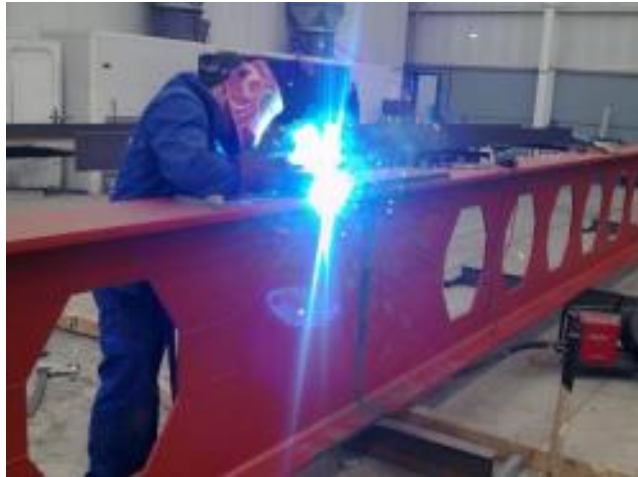
Figura 12 Soldadura Estructuras Metálicas
