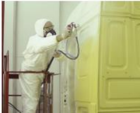
Figura 17 Pintura de Estructuras Metálicas
