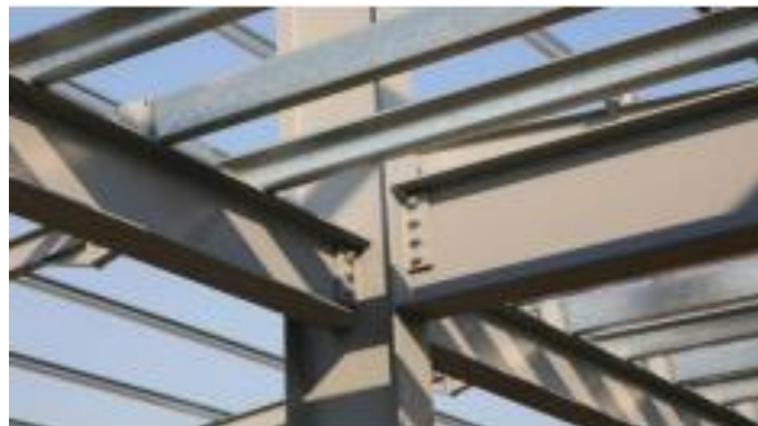
Figura 13 Conexiones Empernadas
