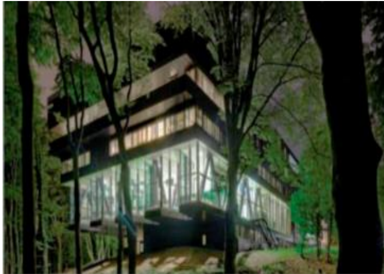
Figura n° 5: Fachada del centro de rehabilitación
