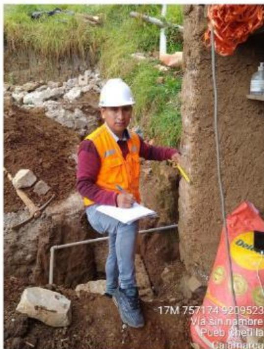
Muro en condiciones regulares, de 25 cm. de espesor.
