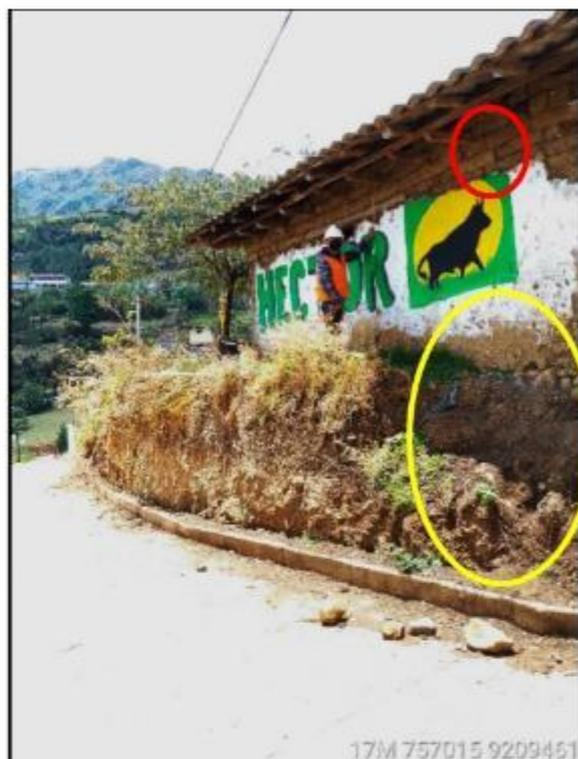
Vivienda cerca de una pendiente muy pronunciada, inadecuada trabazón de las unidades de adobe (círculo rojo), y la cimentación está expuesta por el colapso de elementos del entorno (círculo amarillo).
