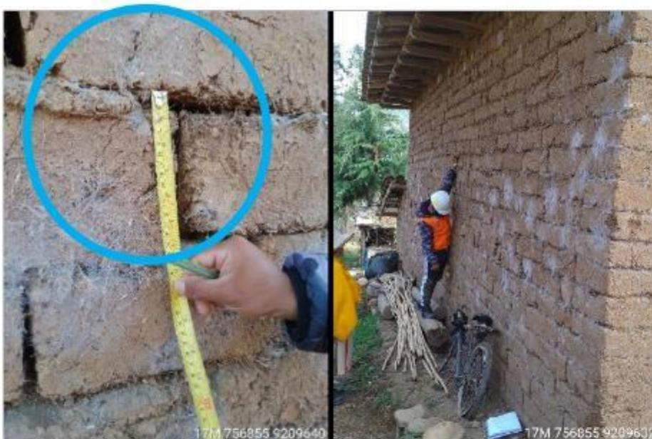
Muro con vacíos entre las unidades de adobe entre 0.5 cm y 2.5 cm (circulo color celeste) y verificación de la verticalidad del muro mediante el uso de la plomada (fotografía de la derecha)
