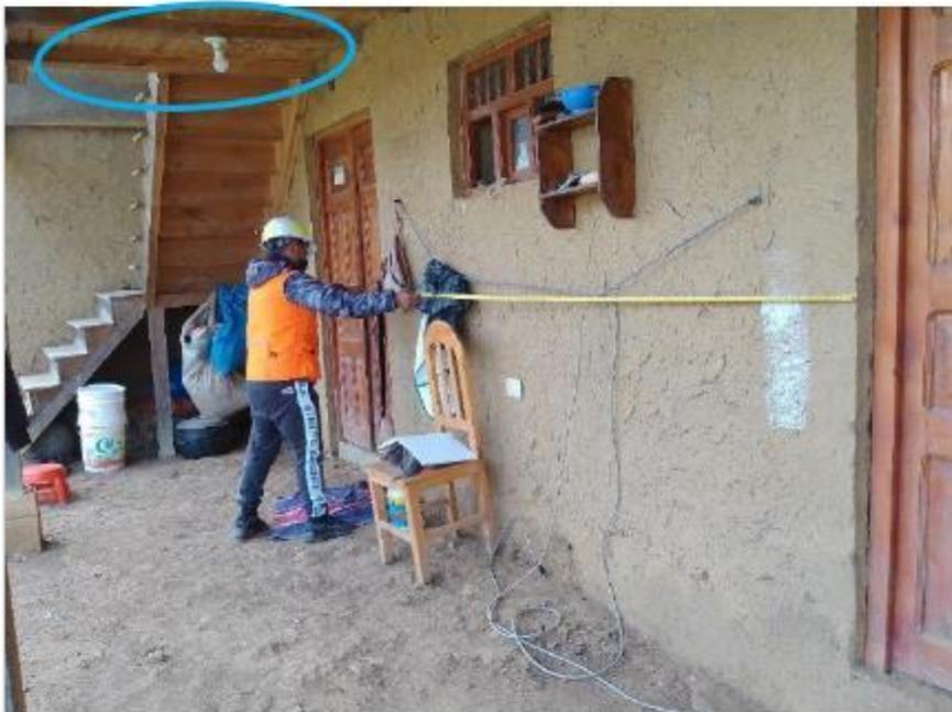
Entablado del balcón en buenas condiciones (color celeste), y muros sin presencia de humedad o grietas grandes.
