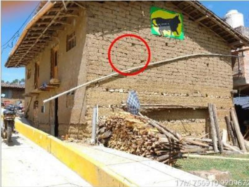
Muro en la parte baja de tapial y adobe en el segundo piso, con inadecuada trabazón del adobe y desprendimiento de parte de algunos adobes (círculo de color rojo).
