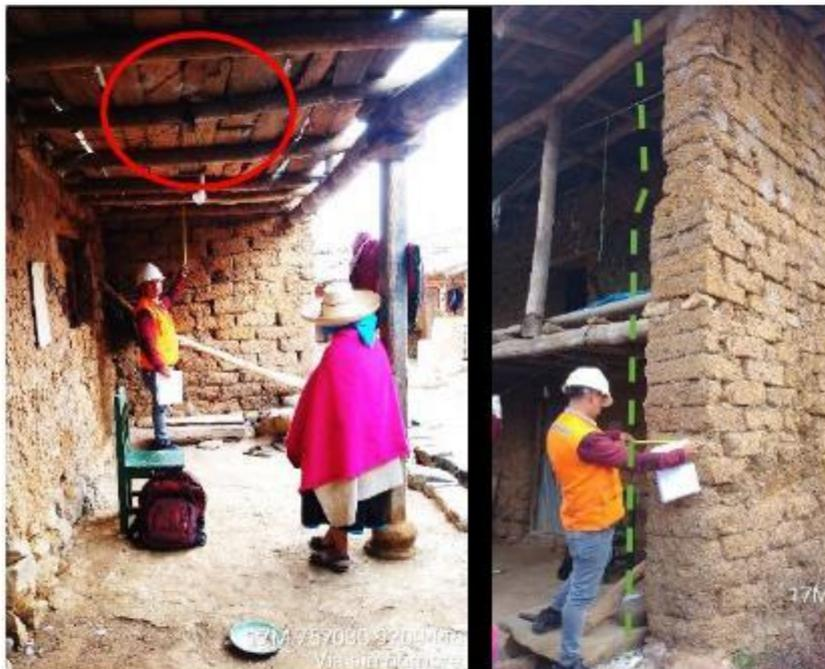
Balcón con entablado roto (Círculo cojo rojo), modificaciones del espesor del muro (línea punteada verde) y deteriorado en la parte baja del muro
