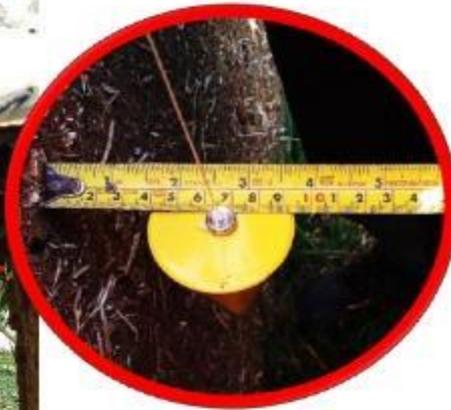
Muro con un desplome de 4 cm en la verticalidad del muro
