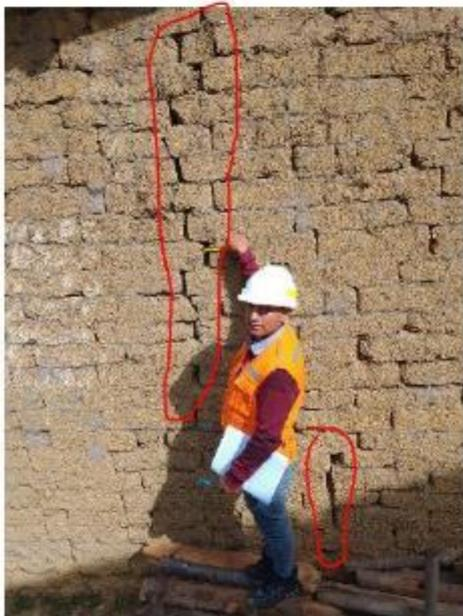
Muro con agrietamiento longitudinal vertical
