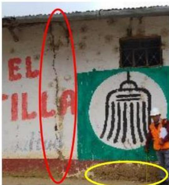
Muro para la parte de adelante con grieta vertical (círculo rojo) y la parte baja del muro presenta deterioro por humedad (círculo amarillo).
