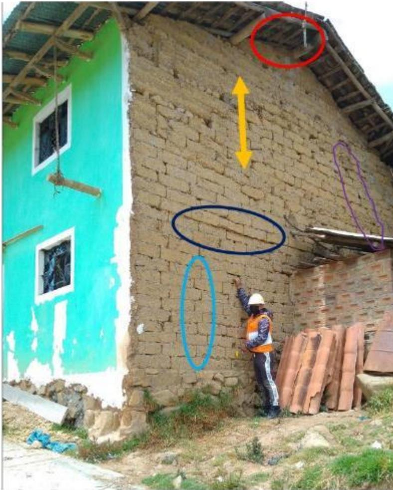
Techo con madera en estado deteriorado por las goteras (círculo rojo), muro con materiales no homogéneos, consta de unidades de adobe en la parte baja y con tapial en la parte superior (doble flecha amarilla), Unidades de adobe con incorrecta trabazón (color celeste) y unidades sobresalidas (color azul) y grietas transversales
