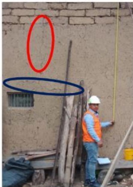
Muro con fisuras longitudinales verticales (elipse color rojo) y fisuras longitudinales horizontales (elipse color azul)
