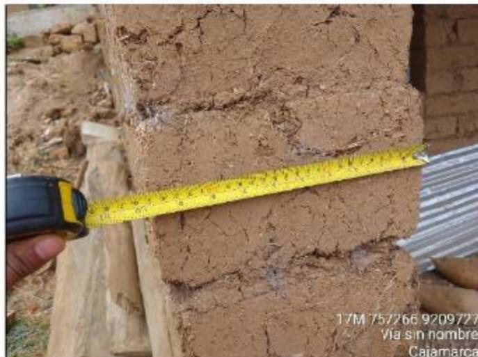
Muros de 0.25 metros de ancho, con mortero discontinuo.
