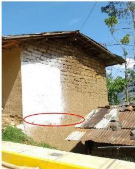
Muro con una grieta horizontal (color rojo) y muros con trabazón de adobe inadecuados, construido en una pendiente pronunciada.
