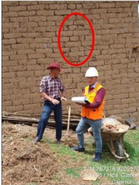
Muro con presencia de pequeñas fisuras y grietas, además el terreno de la vivienda tiene una topografía pronunciado de 21 %.
