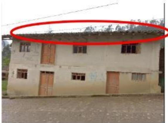
Vivienda reforzada con malla y tarrajeado con cemento, pero la cobertura de teja no está en buenas condiciones debido a la antigüedad del techo, sin mantenimiento ni cambio de tejas.
