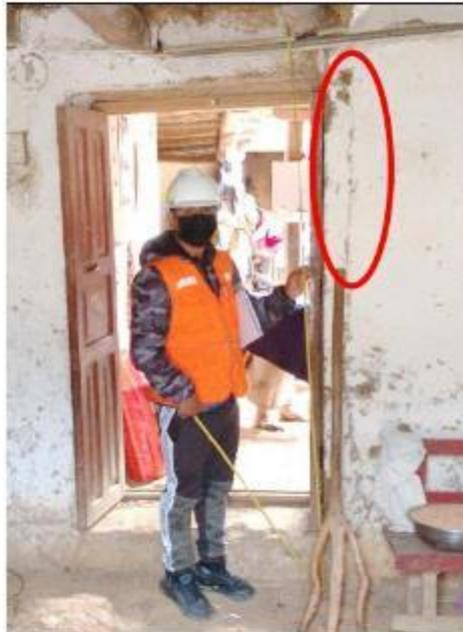
Muro interior con pequeñas grietas y fisuras
