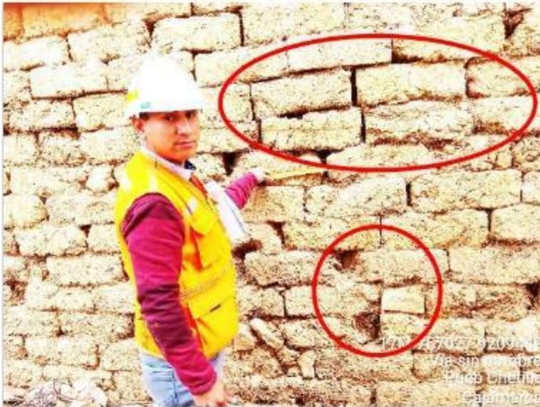
Muro en malas condiciones, con trabazones de adobe incorrectas y discontinuidad del mortero de barro.
