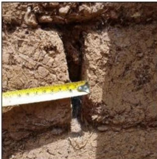
Muros con mortero de barro discontinuo (2.5 cm).
