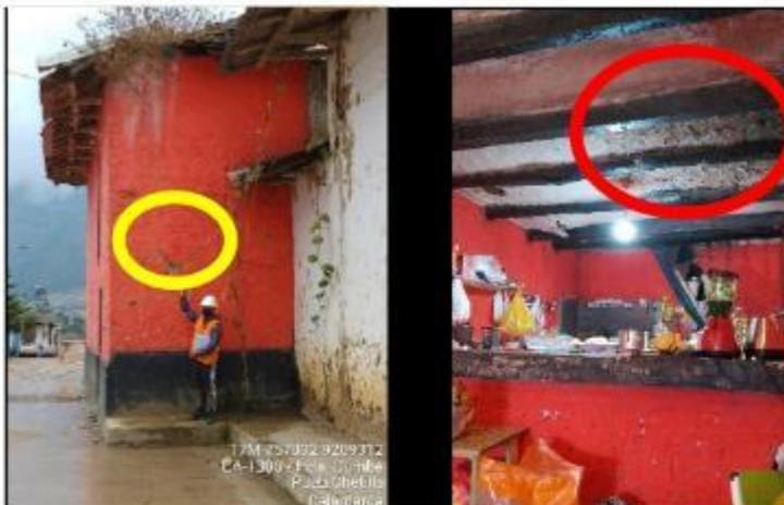
Muro con fisuras y grietas (círculo de color amarillo) y techo en mal estado (círculo de color rojo).
