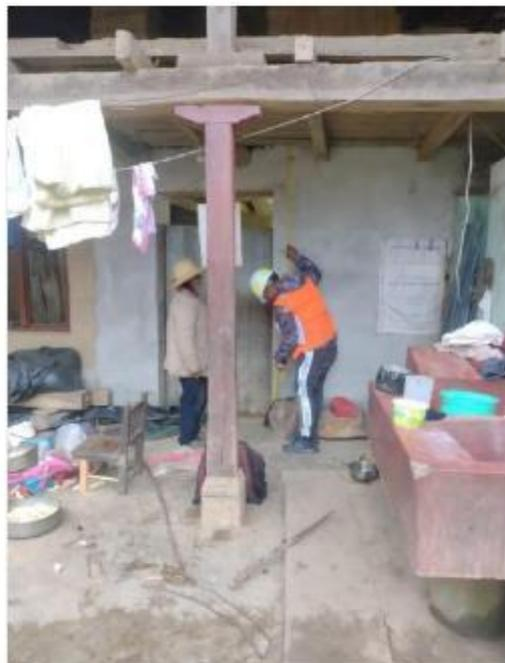
Parte del muro del primer piso esta tarrajado con cemento y otra parte embarrado.
