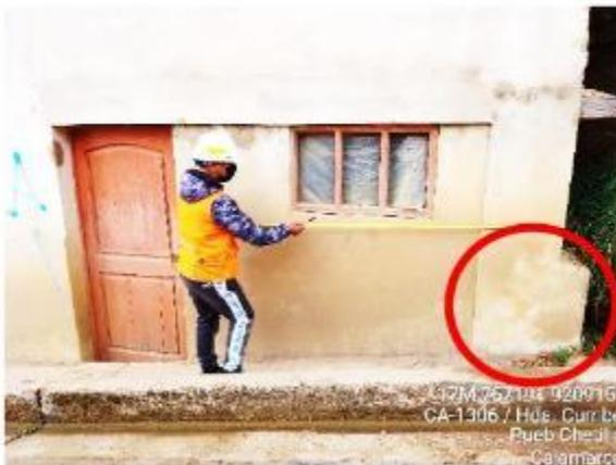
Sobrecimiento recubierto con malla y tarrajeado con cemento (círculo de color rojo)
