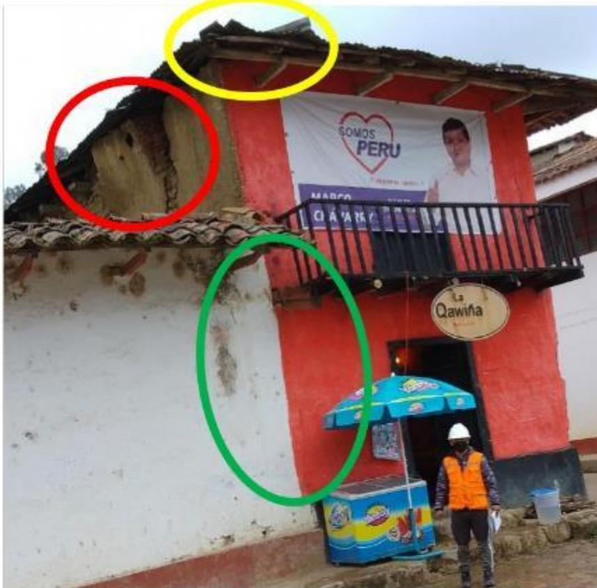
Parte del muro de adobe en el segundo piso está separado e inclinado al borde del colapso (círculo de color rojo), techo en malas condiciones (círculo de color amarillo), falta de junta sísmica (círculo de color verde)
