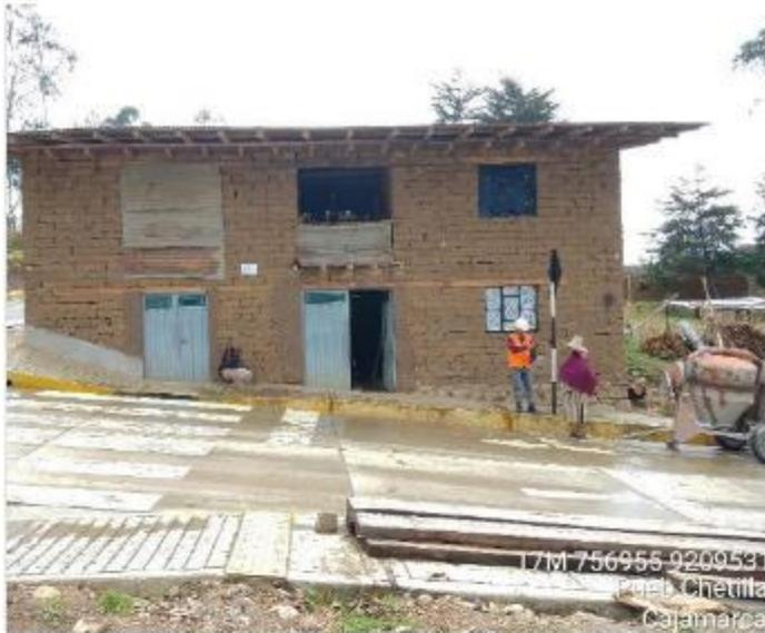
Muro en buenas condiciones, además la vivienda está ubicada en un terreno con topografía moderada, con una pendiente del 12 % igual que el terreno colindante.
