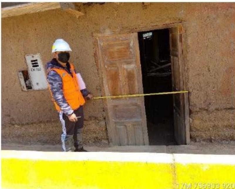
Puerta de 1.20 m. de ancho y la parte baja del muro no está embarrado a desprendimiento del mismo.
