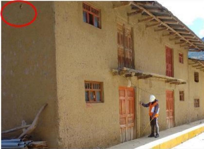
Muro en regulares condiciones, con huecos en la parte lateral (color rojo) y pequeñas fisuras
