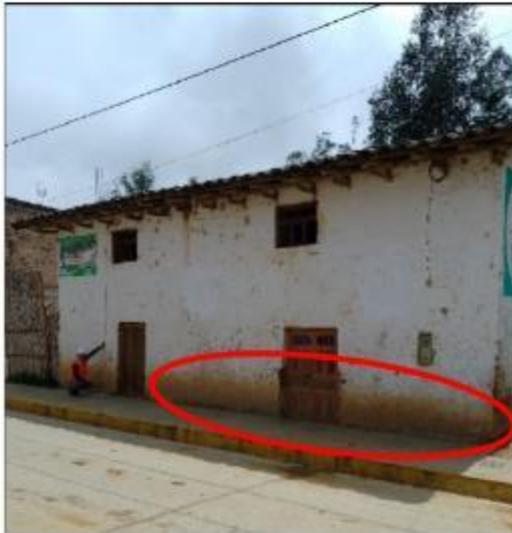
Muro de la parte baja afectado por la humedad.
