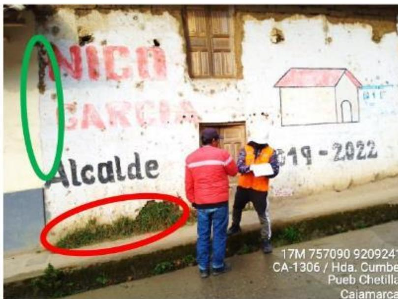
Parte baja del muro con desprendimiento del embarrado y con presencia de humedad (color rojo) y crecimiento de hierba, además no existe junta con la vivienda continua (color verde).
