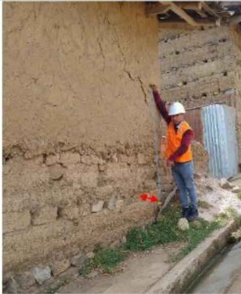
Muro de tapial y adobe con pandeo de 13 cm (doble flecha roja), el muro no tiene una correcta verticalidad, el cual no está a plomo con las hiladas inferiores.
