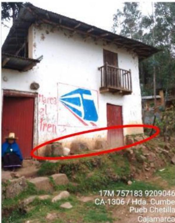
Presencia de humedad en la parte baja del muro
