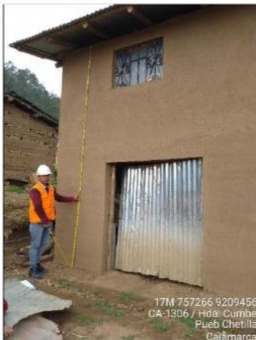
Muro de 3.75 metros de altura, en buenas condiciones, embarrado en sus cuatro lados e interiores.
