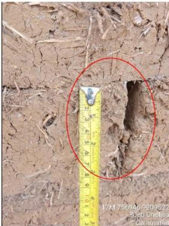
Muro con mortero de barro discontinuo (0.1 mm de espesor), y espacios vacíos entre unidades de adobe.
