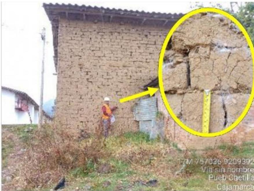
Muro con mortero de barro discontinuo, presencia de fisuras, grietas y el adobe no tiene una buena trabazón.
