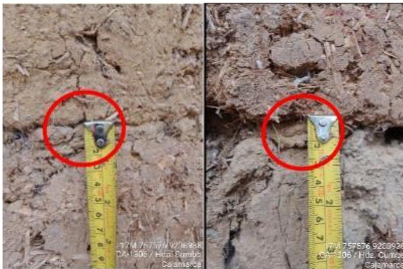
Mortero de barro discontinuo, en la fotografía de la izquierda el espesor es mínimo (0.2 mm) y en la fotografía de la derecha es de 1.5cm.
