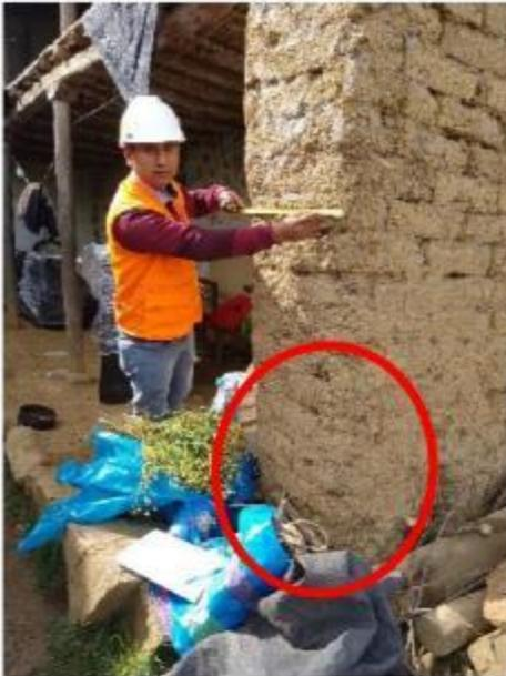
Muros en malas condiciones, reducción de espesor en la parte baja del muro.
