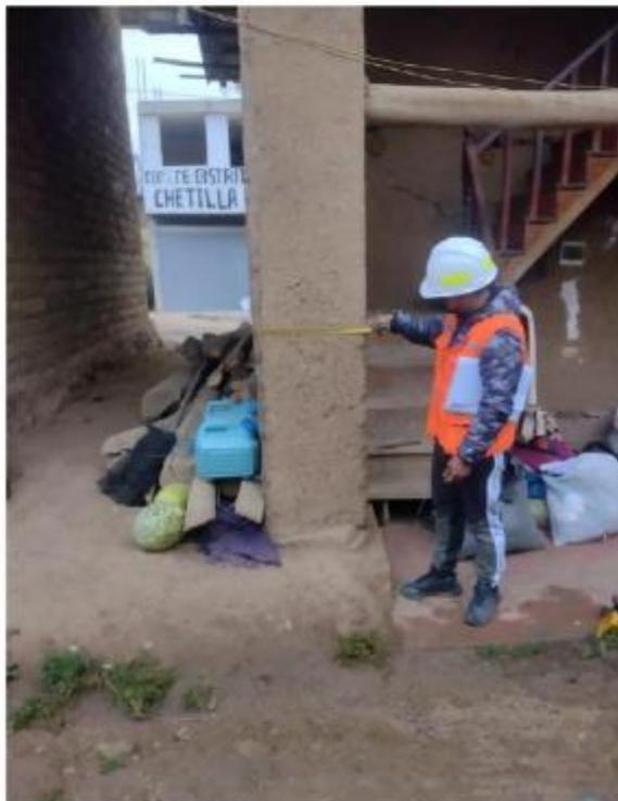
Muro en buenas condiciones de 0.50 m. de ancho.
