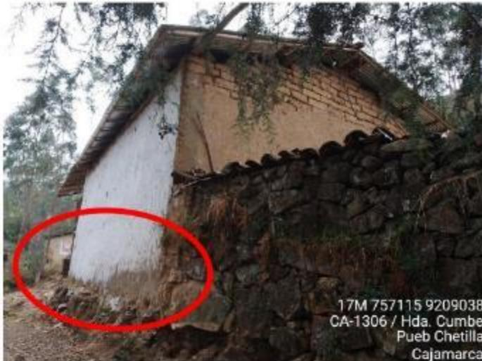
Cimentación expuesta a la intemperie y esta sobre un talud con pendiente pronunciada al costado de la carretera, en terreno rocoso.
