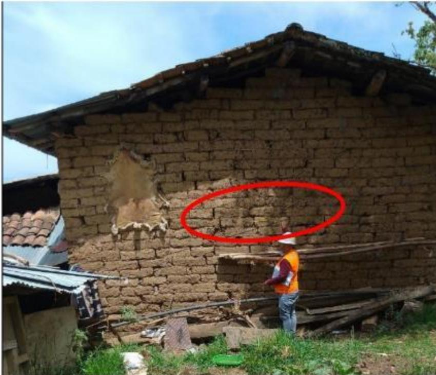
Muro con presencia de fisuras y grietas, además los adobes no tienen una buena trabazón.
