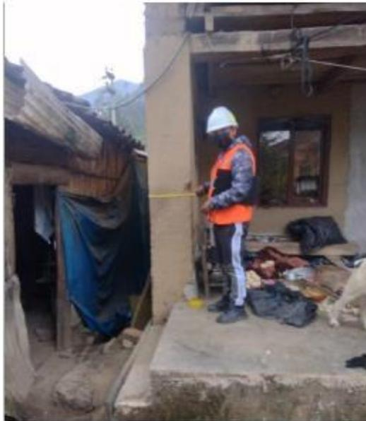
Muro de adobe en buenas condiciones y de espesor 0.30 m.
