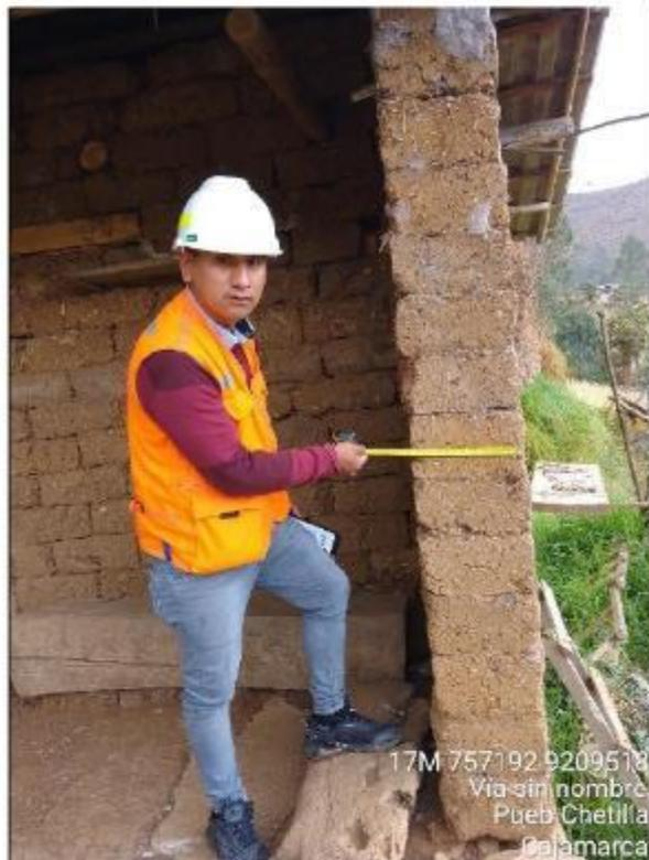
Muro en buenas condiciones de 25 cm. de espesor.
