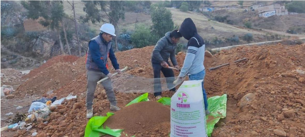
Fotografía 5. Proceso tamizado por la malla N° 3/8” con la finalidad de obtener solo el suelo necesario para la elaboración de adobes, libre de gravas u otros componentes
