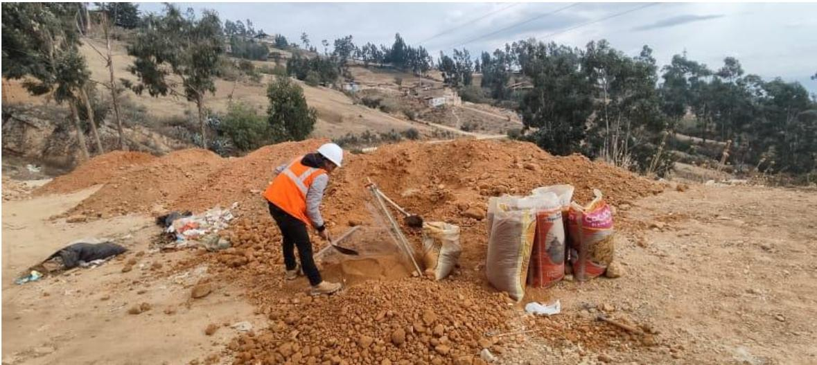
Fotografía 6. Proceso de recolección de suelo previamente tamizado por la malla N° 3/8” con la finalidad de obtener solo el suelo necesario para la elaboración de adobes, libre de gravas u otros componentes
