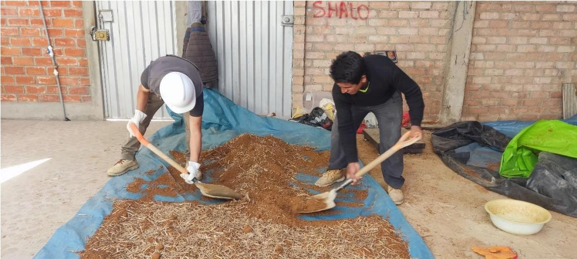
Fotografía 17. Mezcla de Suelo con Fibras de Vaina de Bambú para Elaboración de Adobes
