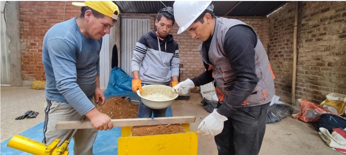
**Figura 18** Colocación de la Tierra Combinada en la prensa CINVA-RAM
