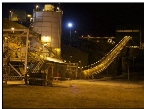
Figura 8. Chancado del mineral Fuente: Gold Fields
