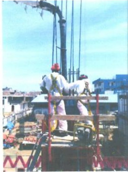
Fig. N°03: VERTIDO DE CONCRETO f'c=210 kg/cm 2 COLUMNAS C-1
