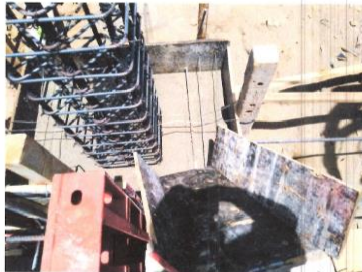
Fig. N°02: VERTIDO DE CONCRETO F'c=210 kg/cm 2 EN ZAPATAS Z-9
