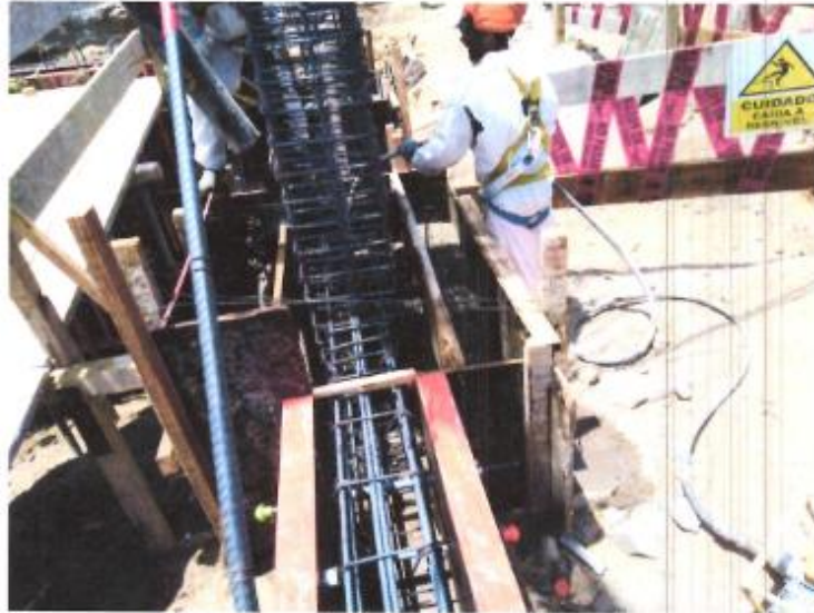
Fig. N°01: VERTIDO DE CONCRETO F'c=210 kg/cm 2 EN ZAPATAS Z-6
