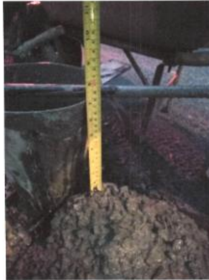
Fig. N°01: VERIFICACION DEL SLUMP 7''
