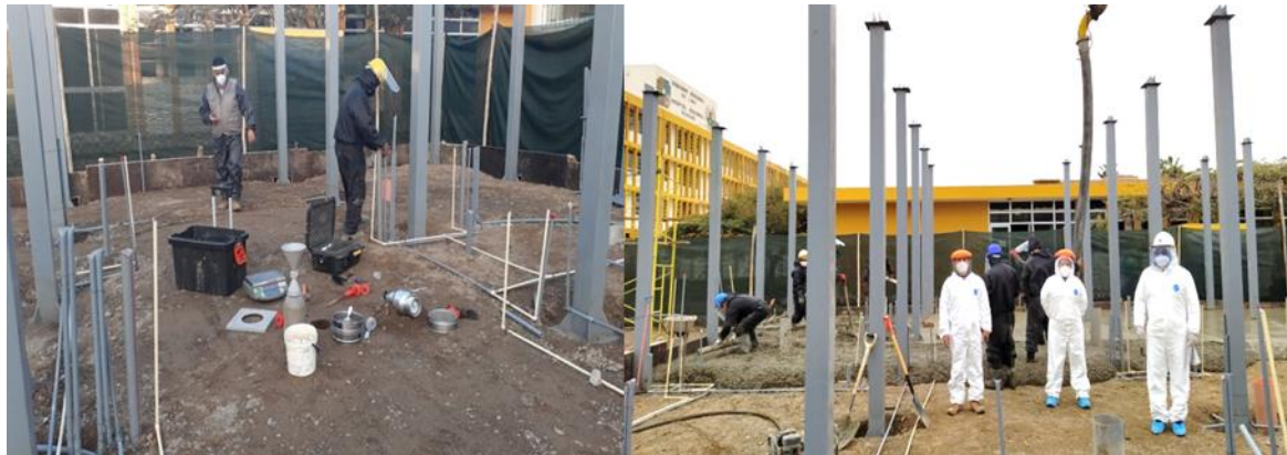
Figura N° 3-69: Ensayo del grado de compactación por el método del cono de arena así como la Colocación del concreto premezclado en el módulo UCI-Hospitalización.
