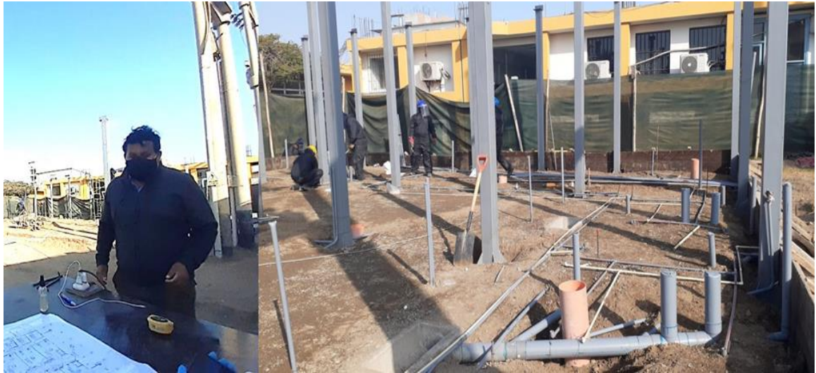
Figura N° 3-68: Instalación de redes de tuberías de desagüe, agua fría, agua caliente Modulo UCI-Hospitalización.
