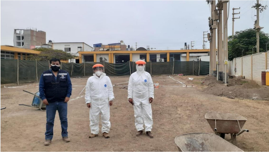
Bachiller en inspección del replanteo de terreno e Inicio de obra.
