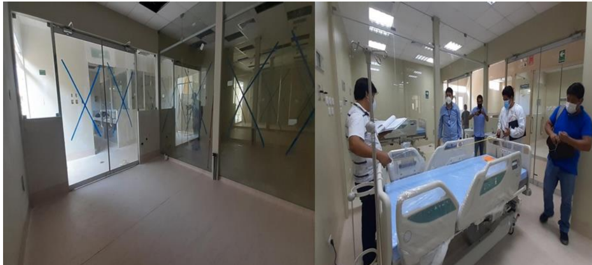
Figura N° 3-72: Instalación del mobiliario y equipamiento médico
