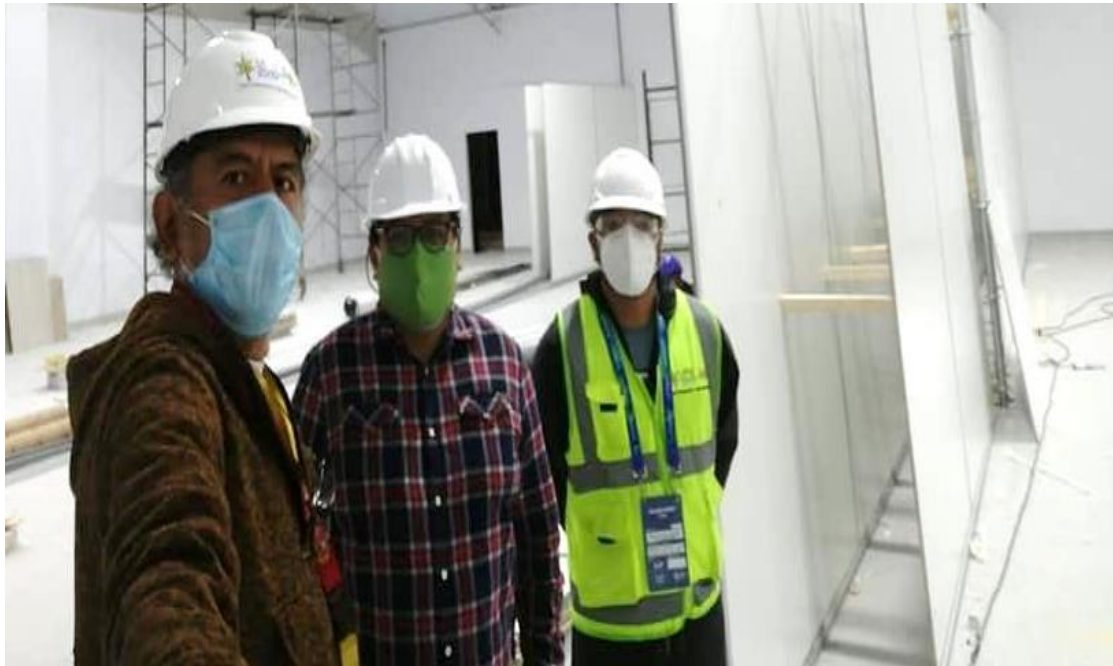
Inspección de campo de la instalación de las tabiquerías.
