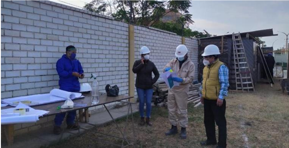
Figura N° 3-62: Equipo profesional a cargo de la ejecución de la Obra
