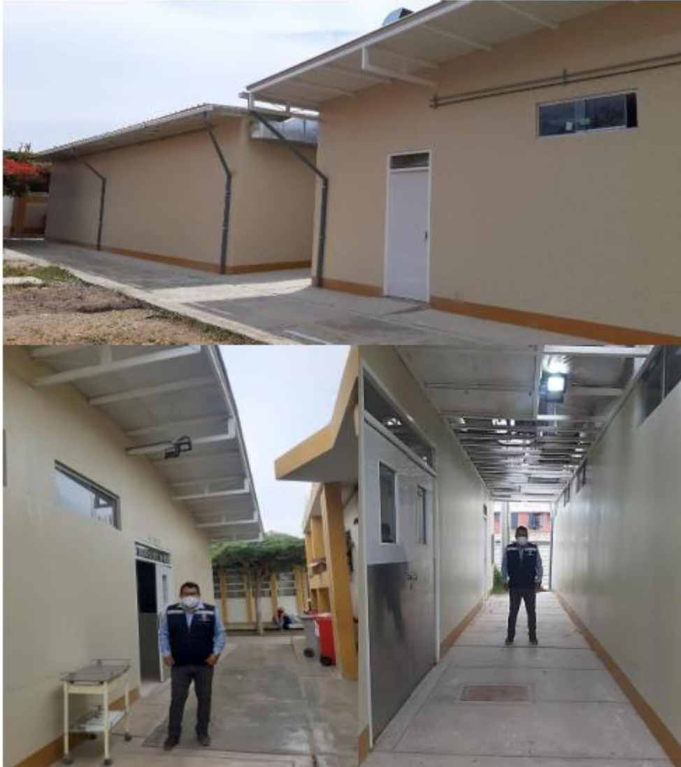
Figura N° 3-73: Inspección Final por el bachiller de los módulos Terminados
