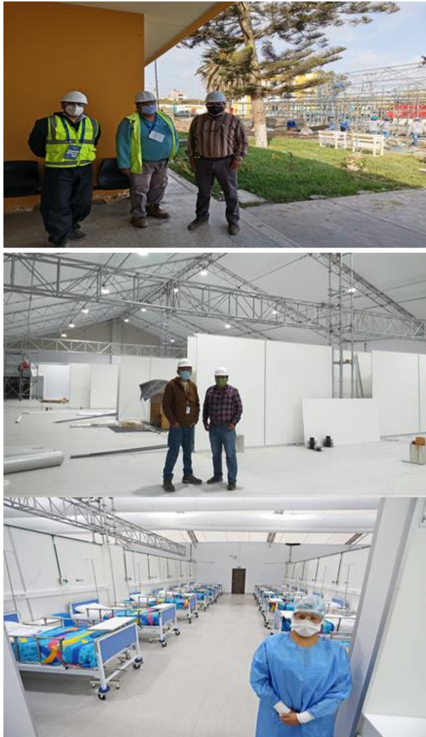
Figura N° 3-18: Imágenes de las Inspecciones desarrolladas en la ejecución del Hospital Temporal.
