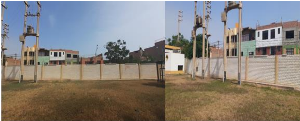
Figura N° 3-46: Área libre colindante a la UPS UCI-Emergencia seleccionado para la ejecución del Proyecto.
