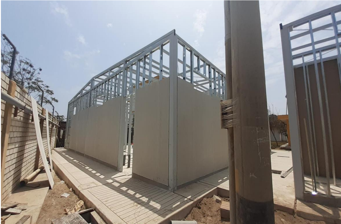
Instalación de tabiquerías de fibrocemento en cerramiento externo.
