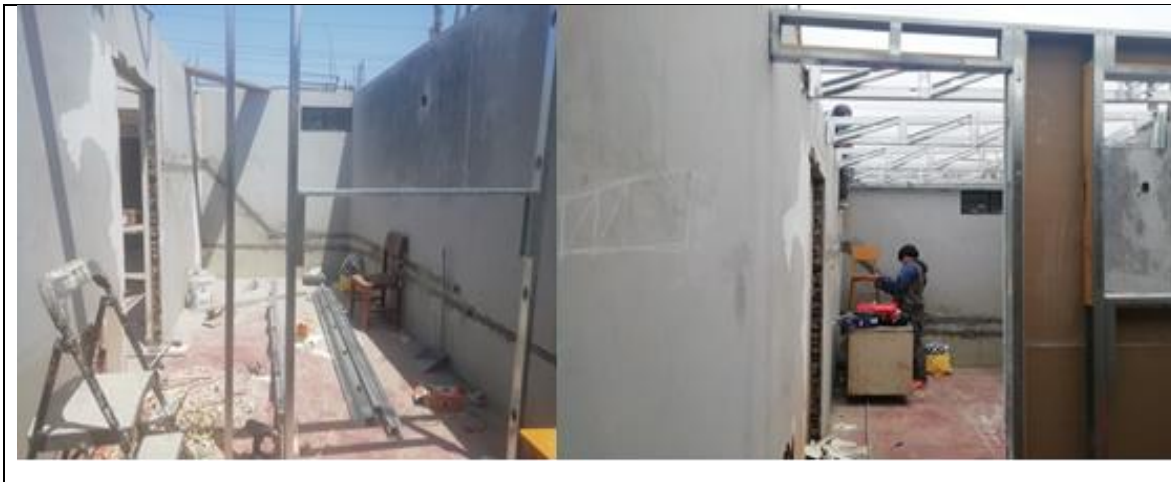
Figura N° 3-32: Inspección del proceso de ejecución (retiro de cobertura existente, instalaciones eléctricas y colocación de estructura de techo prefabricado).
