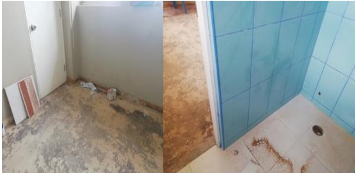
Figura N° 3-39: Vista de la inspección en el proceso de acondicionamiento (retiro de pisos existente, zócalo, enchape de SS:HH.).
