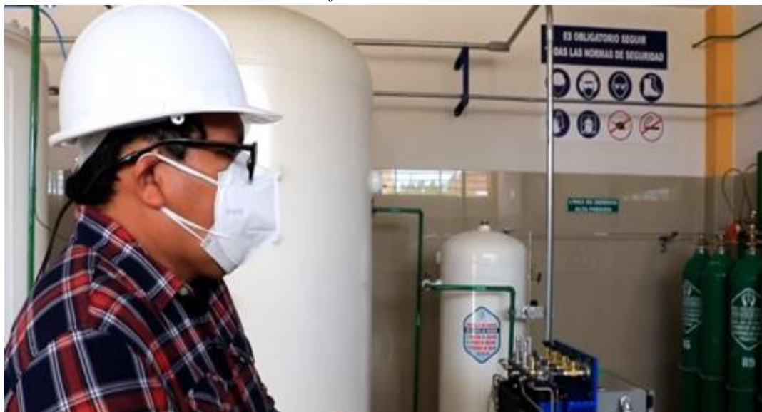
Figura N° 3-16: Inspección por el bachiller de las instalaciones terminadas de la planta de oxígeno previo a la conformidad.
