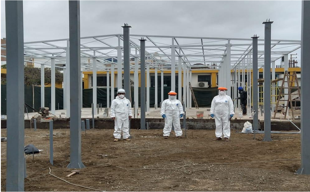
Instalación de los elementos estructurales metálicos.
