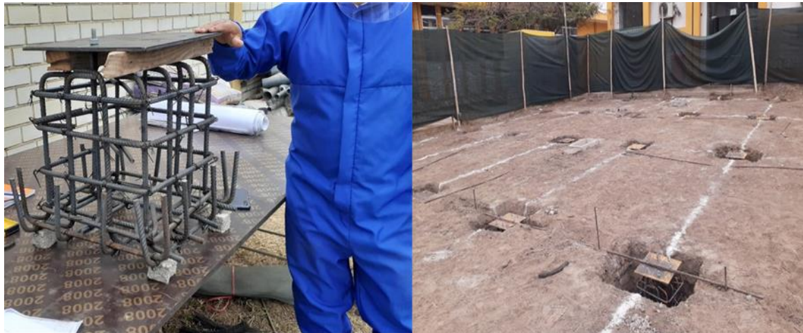
Figura N° 3-66: Colocación de acero y plancha metálica para dados de concreto
