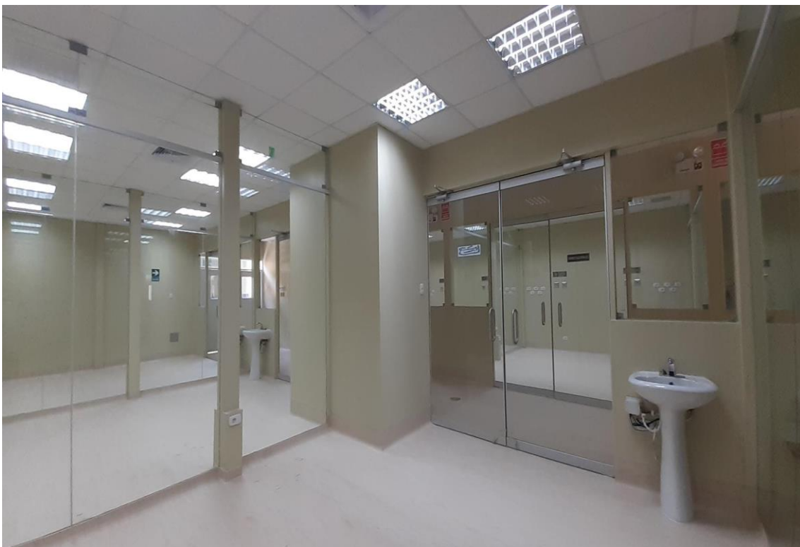
Módulo uci con acabados terminados
