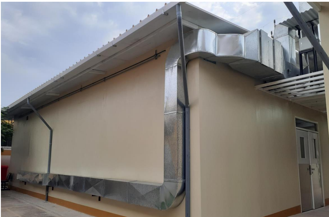
Instalación del sistema de presión negativa ductos de extracción de aire
