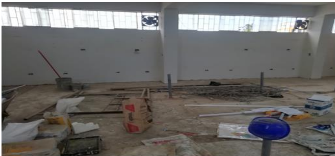
Figura N° 3-38: Vista de la inspección en el proceso de acondicionamiento (tratamiento de paredes, circuitos eléctricos y red de datos).
