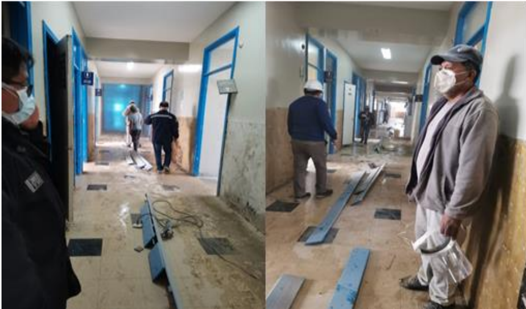
Figura N° 3-14: Inspección de los avances de la remodelación de la UPSS Hospitalización. (retiro de protectores de manera, zócalos y contra zócalos).
