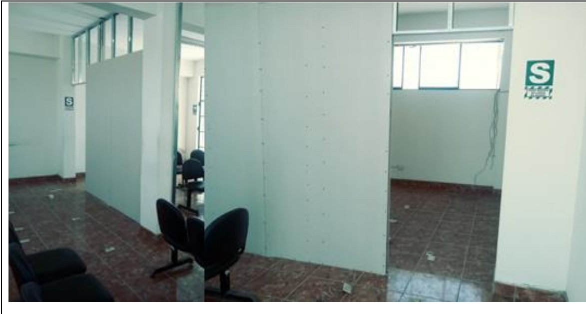
Figura N° 3-33: Inspección de la instalación de la tabiquería (drywall), Circuitos eléctricos y de datos.
