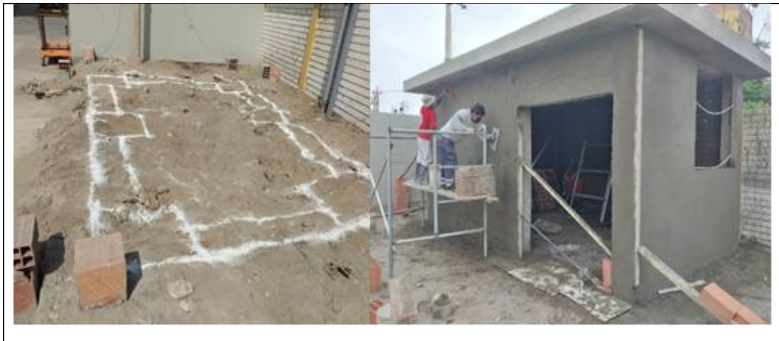
Figura N° 3-31: Inspección del inicio de obra (trazo y replanteo) y del avance (revoques enlucidos).
