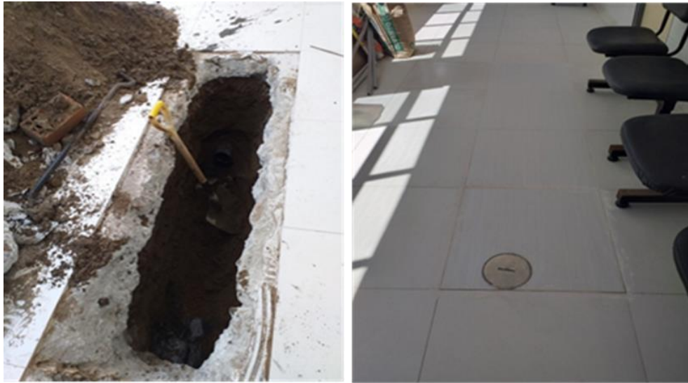
Figura N° 3-12: Inspección del mantenimiento redes de desagüe UPSS Consulta externa. (proceso de cavado de zanja, reemplazo de tubería y terminado)
