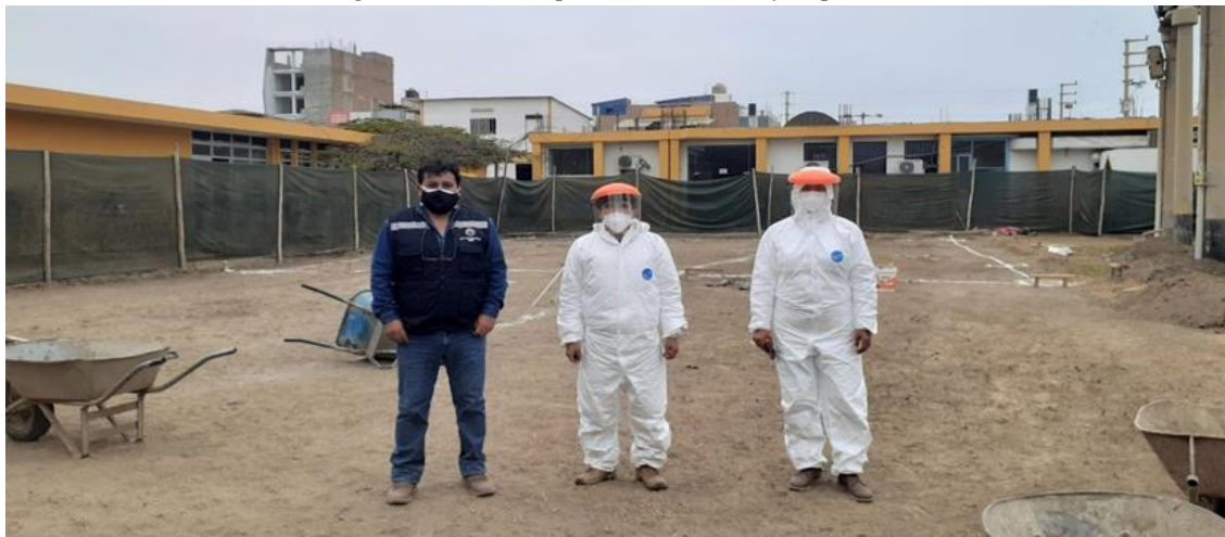
Figura N° 3-63: Inspección del Trazo y Replanteo
