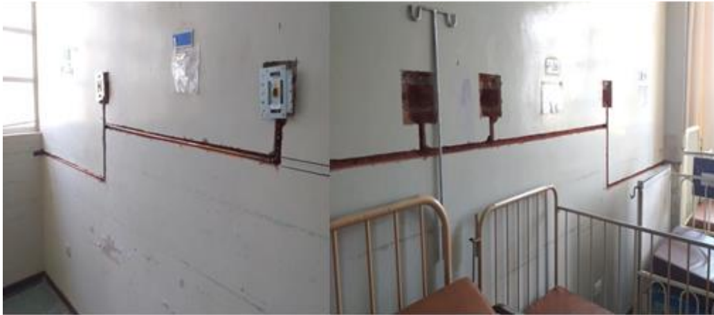
Figura N° 3-15: Inspección de los avances de la Instalación de la redes empotradas de CU (para Oxígeno medicinal) en los diferentes habitaciones
