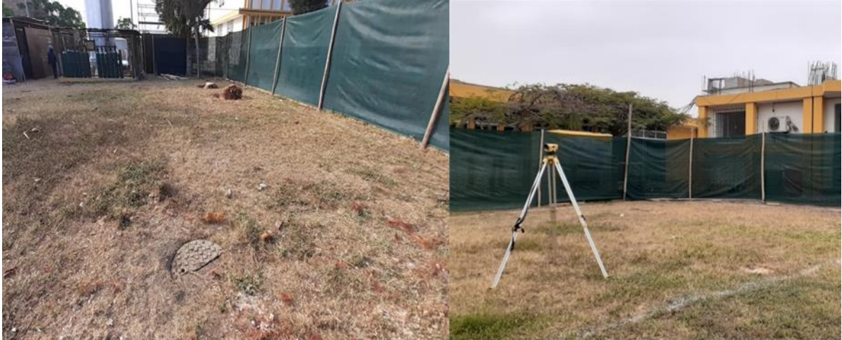
Figura N° 3-64: Medición para la Nivelación de terreno
