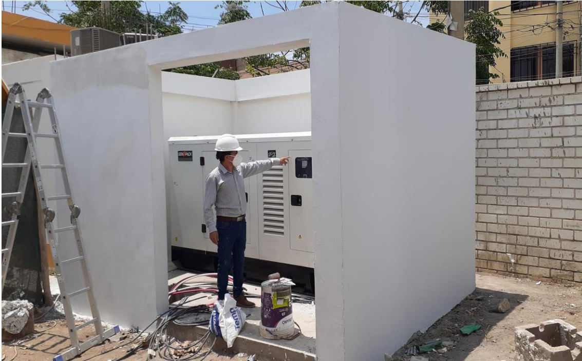
Construcción de caseta e instalación de grupo electrógeno.
