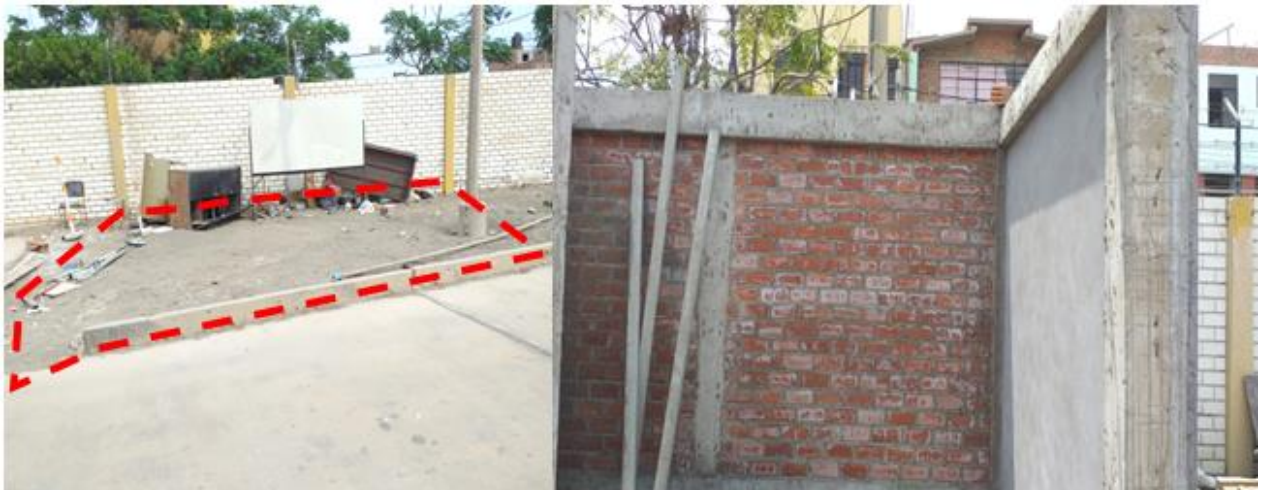
Figura N° 3-13: Inspección de los avances de la construcción de caseta para almacenaje de residuos sólidos.
