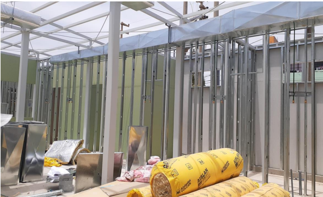
Instalación de tabiquerías de drywall y ductos de ventilación artificial
