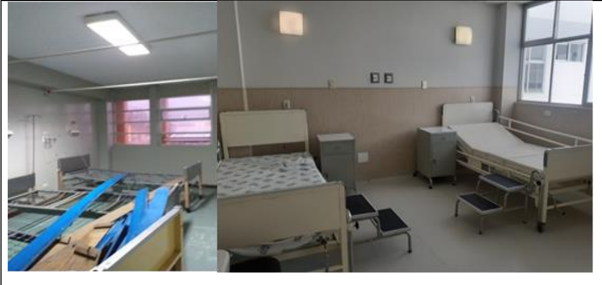
Figura N° 3-30: Inspección de la ejecución del servicio de acondicionamiento (retiro de zócalos, contra zócalos, remoción de acabado de paredes, culminado de los ambientes de pediatría).
