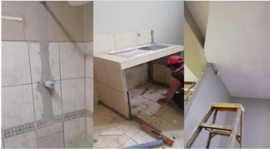
Figura N° 3-40: Inspección de los avances de la ejecución (Instalación de Lavadero, Cambio de cielo raso, renovación de instalaciones sanitarias y enchape.).
