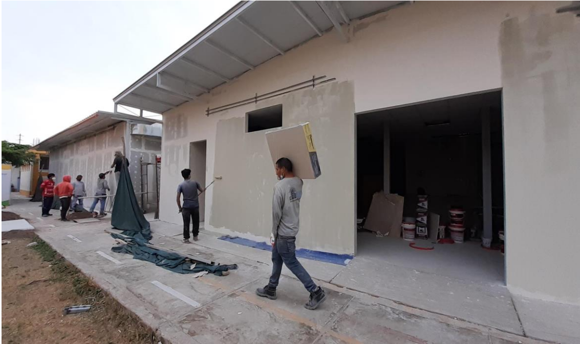
Pintado de la muros de tabiquería.
