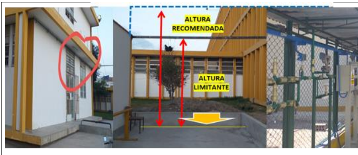
Figura N° 3-29: Inspección de las instalaciones de red de oxígeno medicinal
