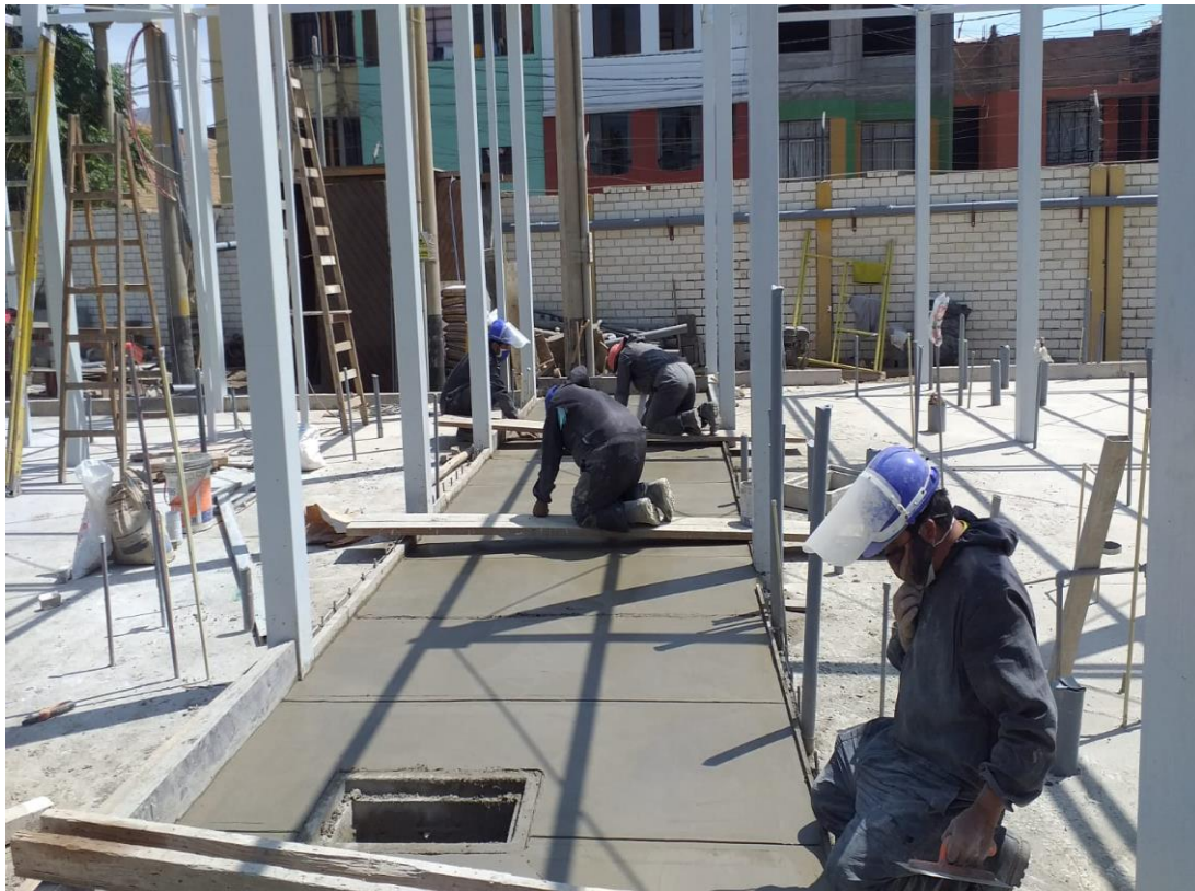
Construcción de veredas y rampas
