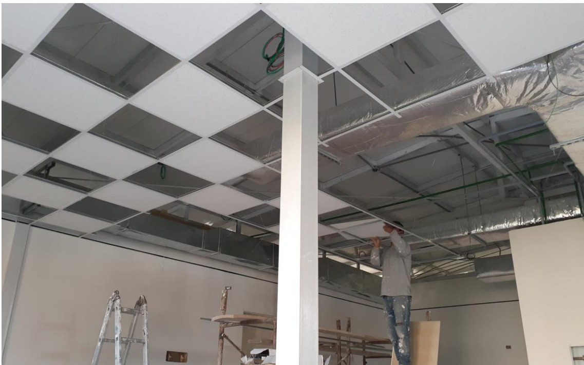
Instalación de falso cielo raso.
