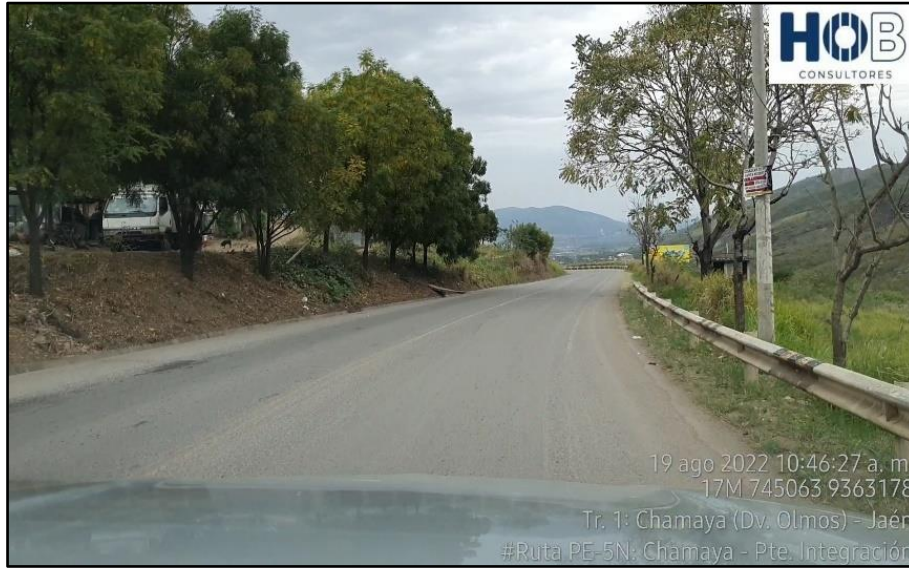
Figura N° 49 - Indicador de Roce del Km. 12+300 al Km. 12+400
