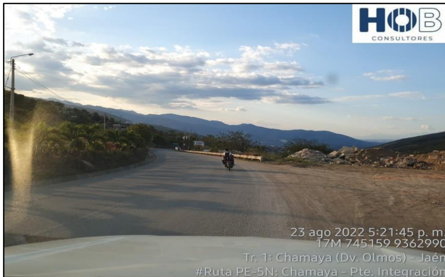
Figura N° 50 - Indicador de Limp. de General del Km. 12+000 al Km. 12+100
