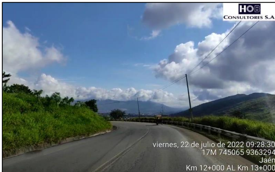
Figura N° 37 - Indicador de Limp. de Calzada y Berma del Km. 12+400 al Km. 12+500
