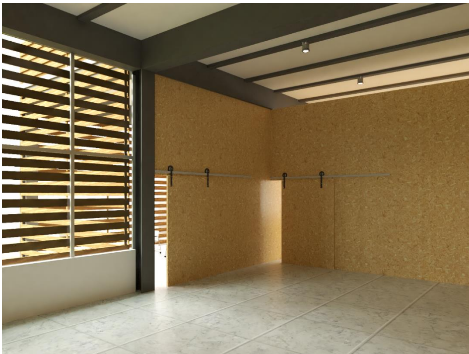
Figura 71: Vista interior – muros corredizos de OSB en escuela gastronómica
