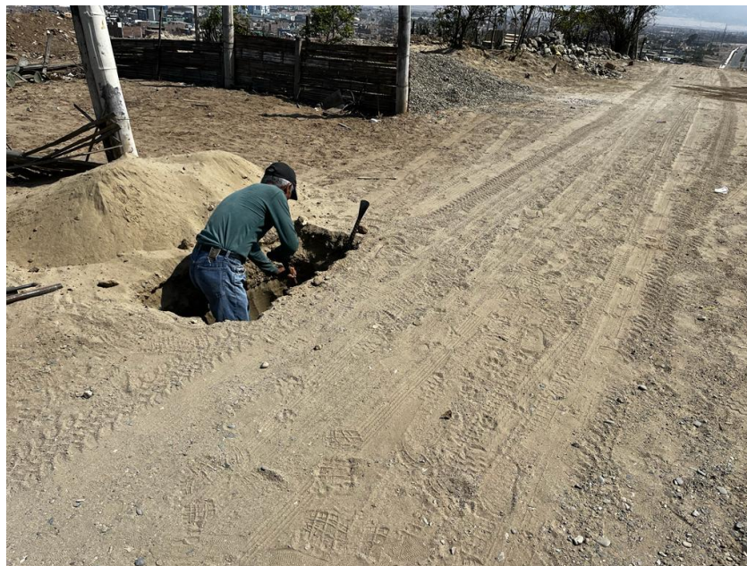
Ilustración 2. Excavacion de calcicata- profundidad 3m
