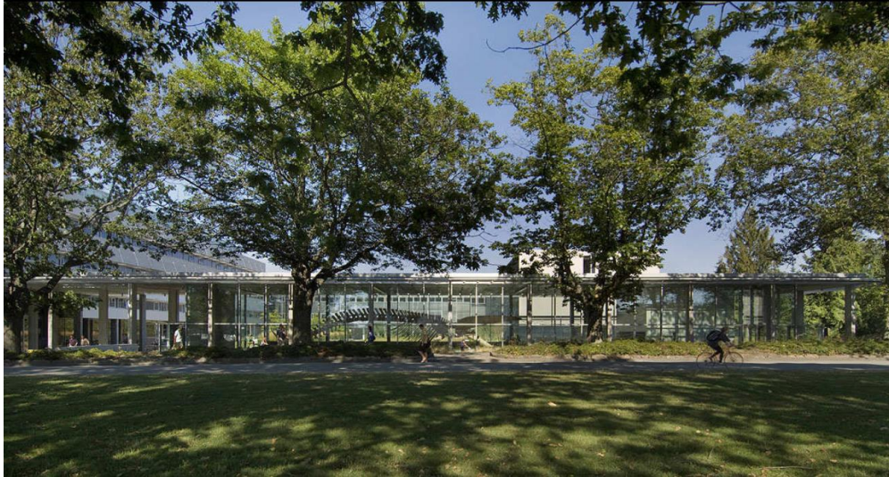
Figura 92. Vista desde el parque exterior a la zona de exhibición del megalodón.
