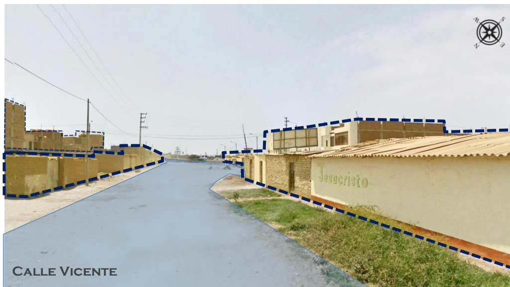
Figura 24. Vista este de la calle Vicente del terreno N° 1
