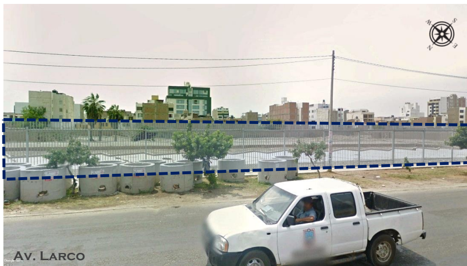
Figura 39. Vista nor – este central de la avenida Larco del terreno N° 3
