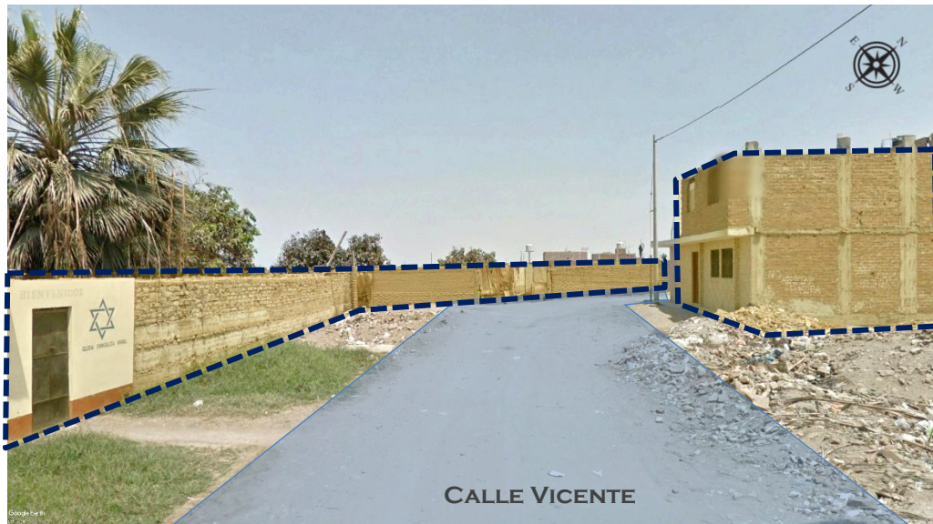
Figura 23. Vista oeste de la calle Vicente del terreno N° 1
