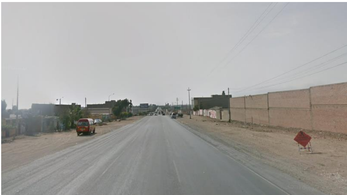
Figura 47. Carretera Panamericana Fuente: Google maps
