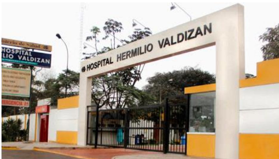
Figura 3. Hospital Hermilio Valdizán Fuente: Hospital Hermilio Valdizán Web
