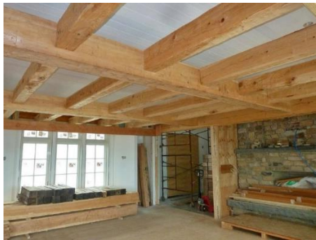
Figura 10. Vigas macizas de madera
