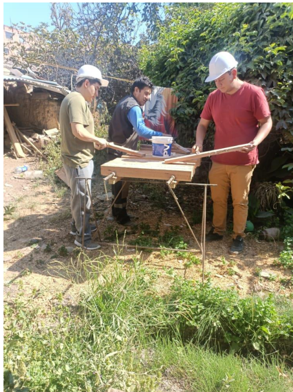
Encolado de láminas para vigas laminadas
