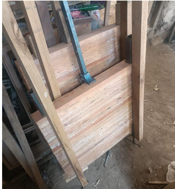
Prensado de vigas laminadas
