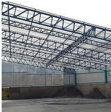
Figura 4.21. Armado de estructura metálica en cobertura.
