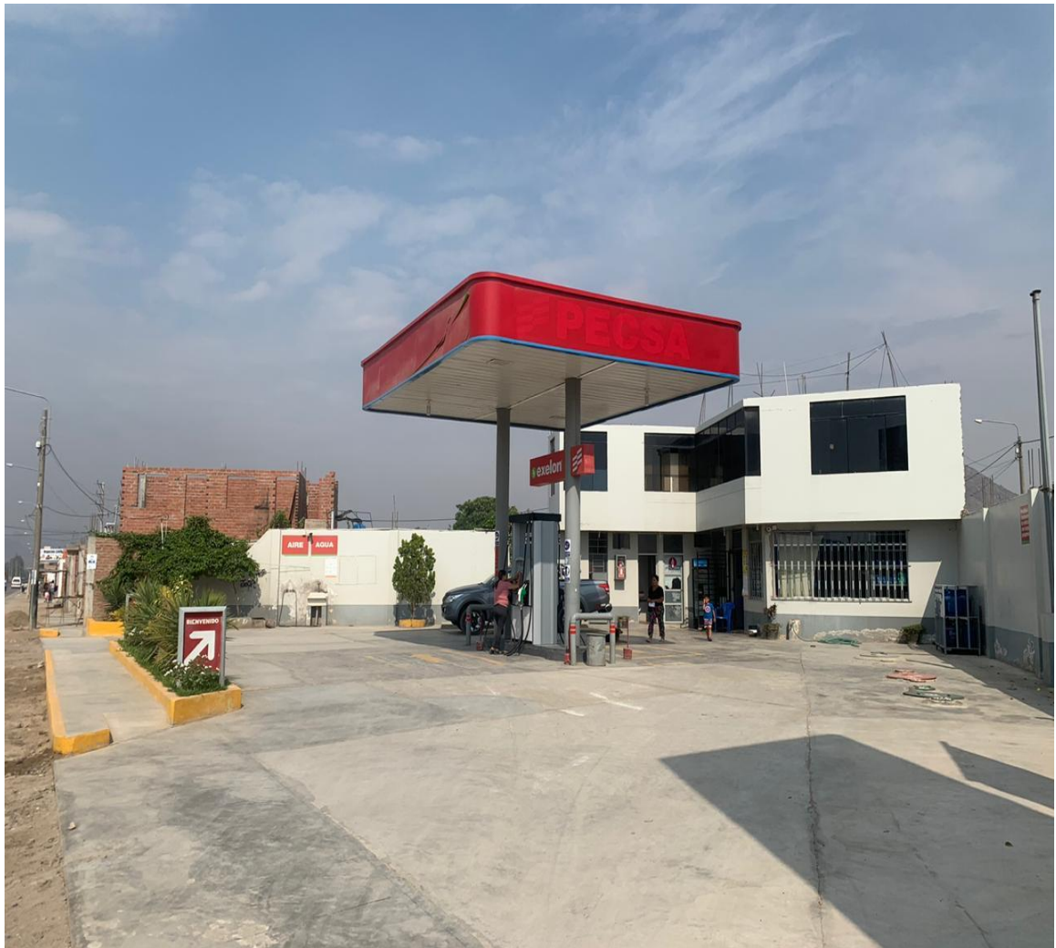
Foto de la empresa INVERSIONES SELFA S.R.L. ubicada en el distrito de Quiruvilca, provincia de Santiago de Chuco.
