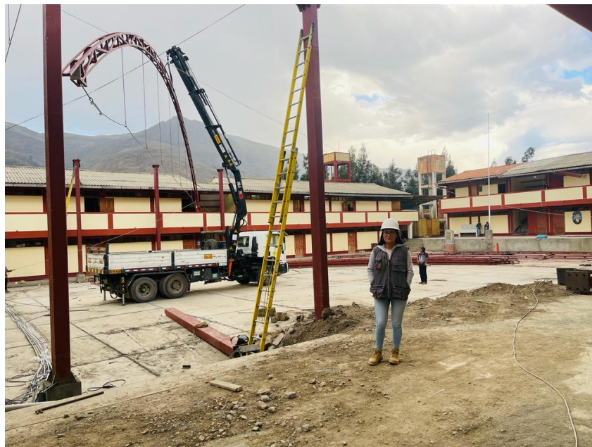
Figura 31. Vista de la instalación de la estructura metálica.
