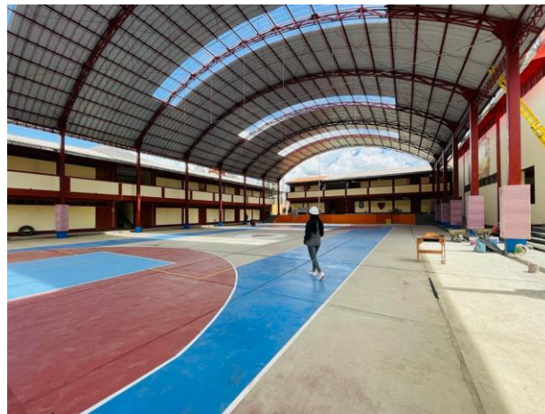
Figura 33. Pintado del patio y techo metálico.
