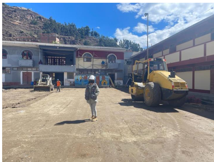
Figura 24. Compactación con maquinaria el patio de formación
