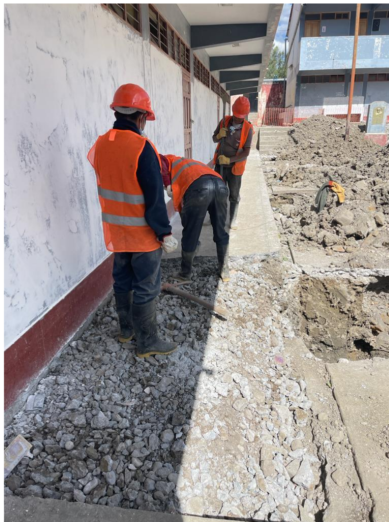
Figura 28. Vista de la demolición de veredas.
