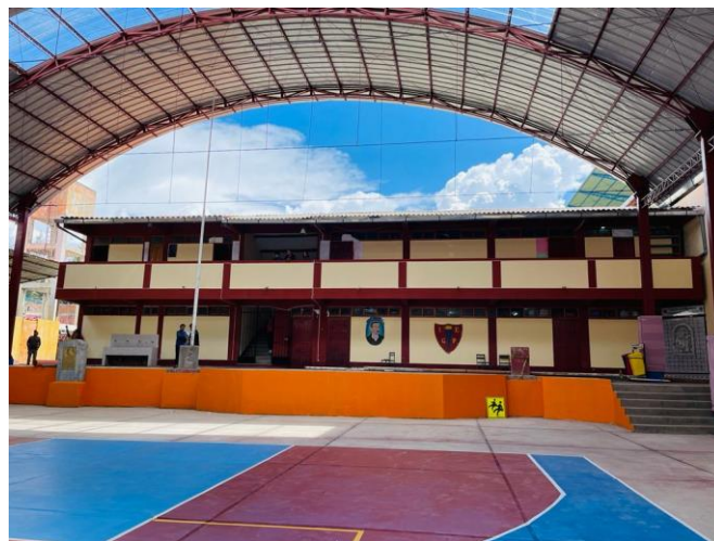
Figura 34. Vista final del proyecto.
