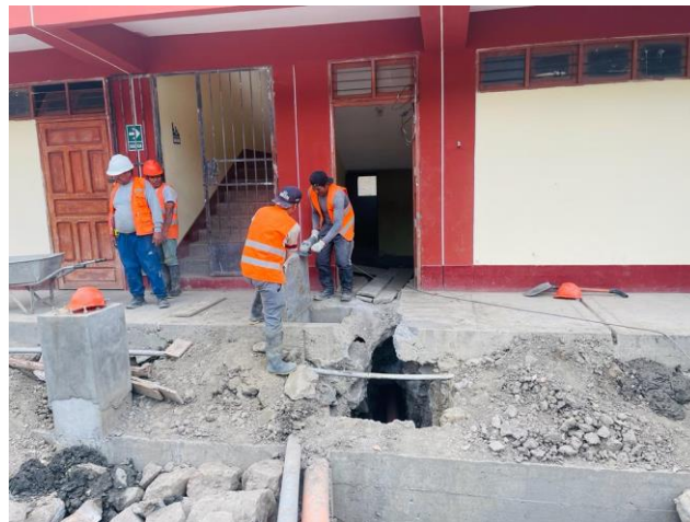
Figura 23. Ejecución de la caja de registro
