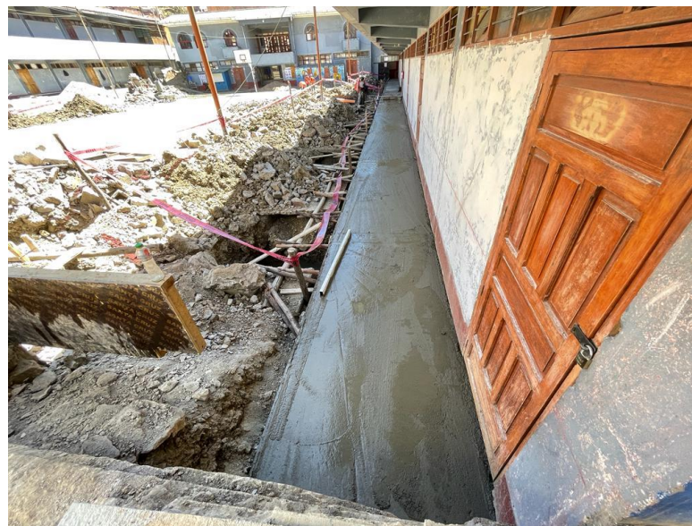
Figura 30. Vista del llenado de concreto f'c=210 kg/cm 2 en las veredas y rampas.
