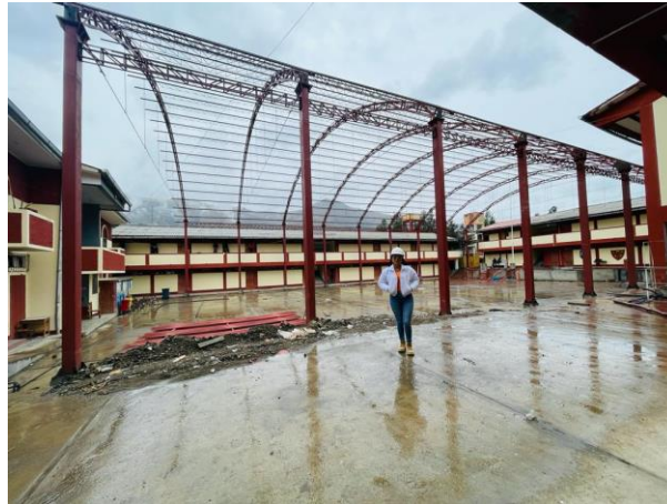
Figura 32. Instalación del techo metálico
