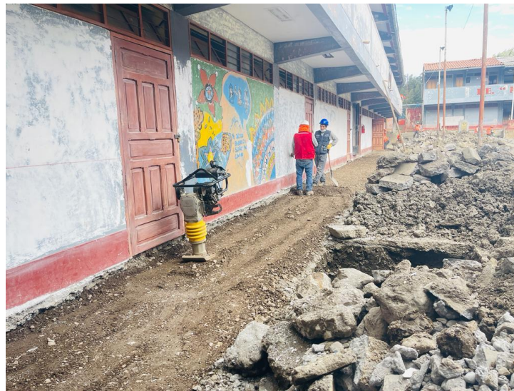
Figura 29. Vista de la compactación de veredas y rampas.
