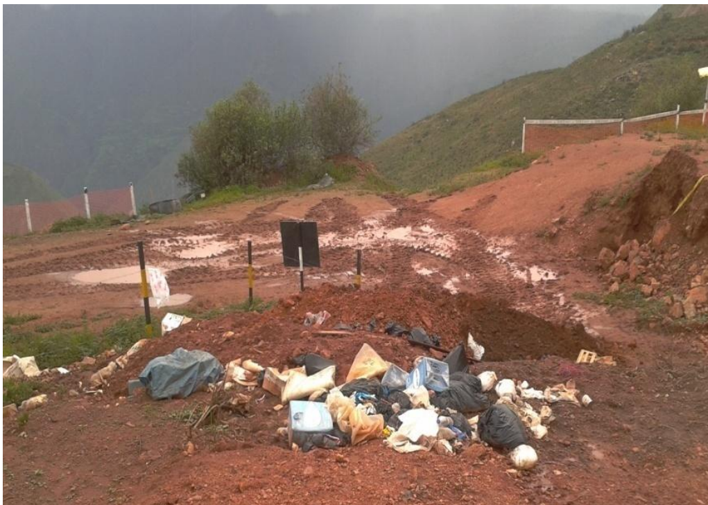
Figura 5. Relleno sanitario inadecuado
