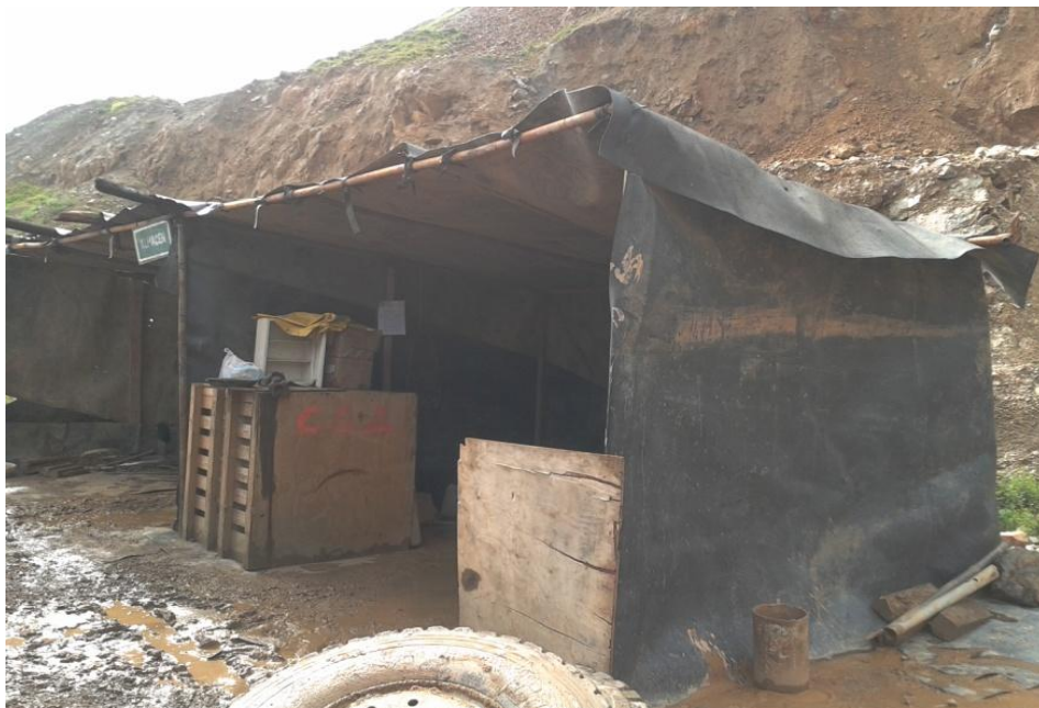
Figura 3. Deficiente almacenamiento de materiales
