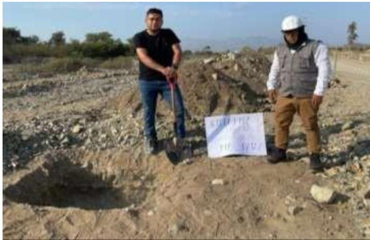
Fotografía 4: Excavación de calicata C1
