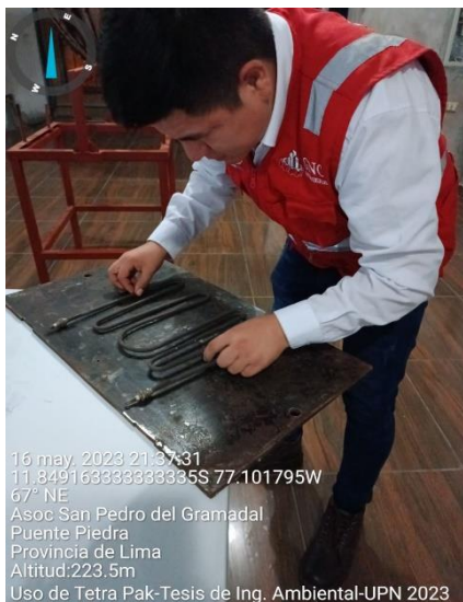
Instalación de resistencias eléctricas en plancha
