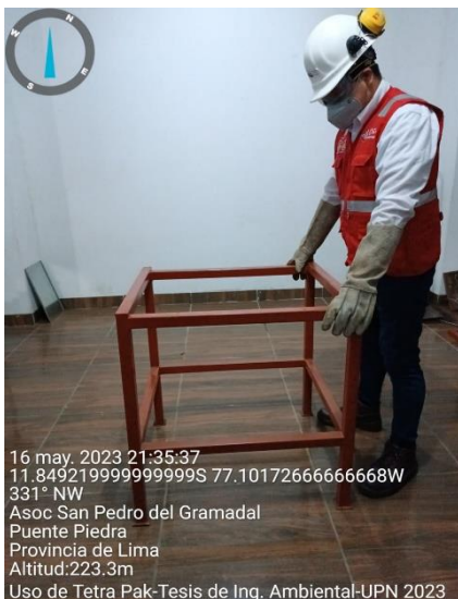
Fabricación de soporte metálico
