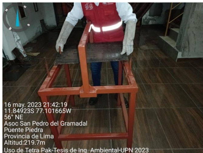
Instalación de plancha de acero inferior
