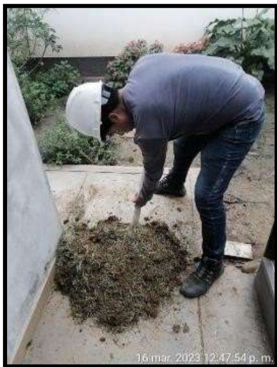
Fotografía 10: Preparación de mezcla para elaboración de adobes.
