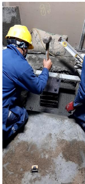
Figura 17: Vaciado y nivelado de estructura
