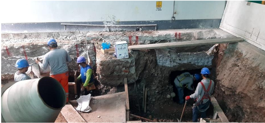
Figura 12: Excavación de los anillos intercalados.
