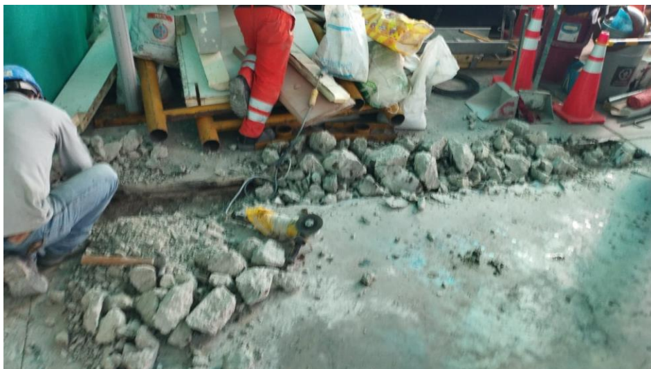
Figura 11: Demolición de muro y losa.
