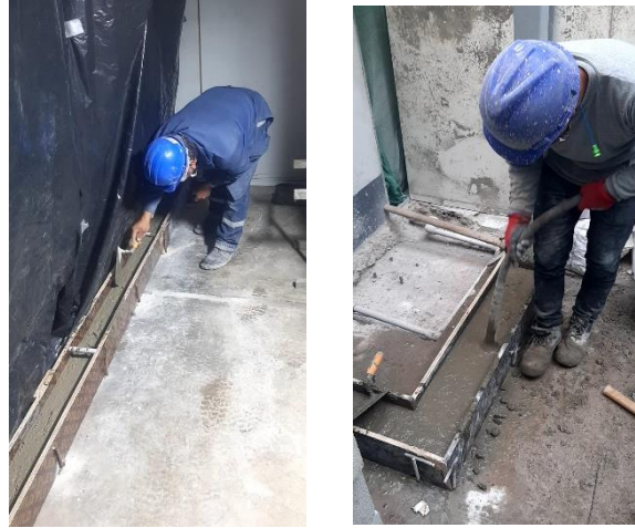
Figura 14: Vaciado de sardineles para el muro de drywall
