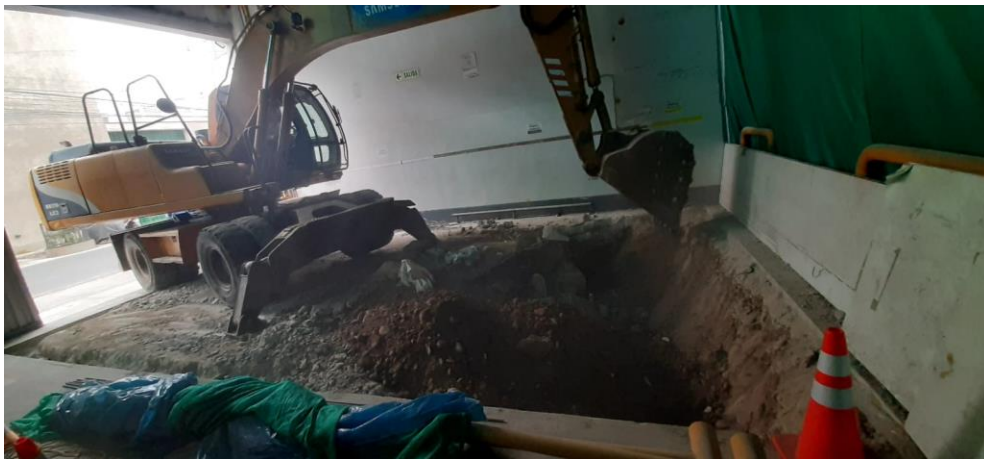
Figura 10: Trabajos manuales y mecánicos.
