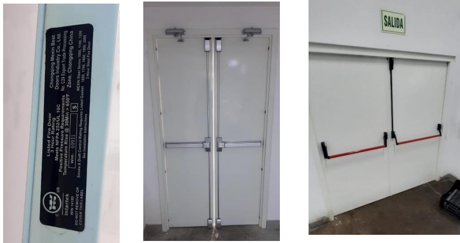
Figura 27: Puerta cortafuego
