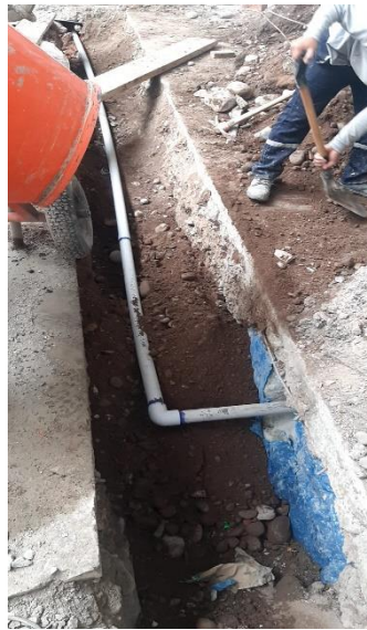
Figura 30: Conexionado de red con la cisterna de agua de consumo existente
