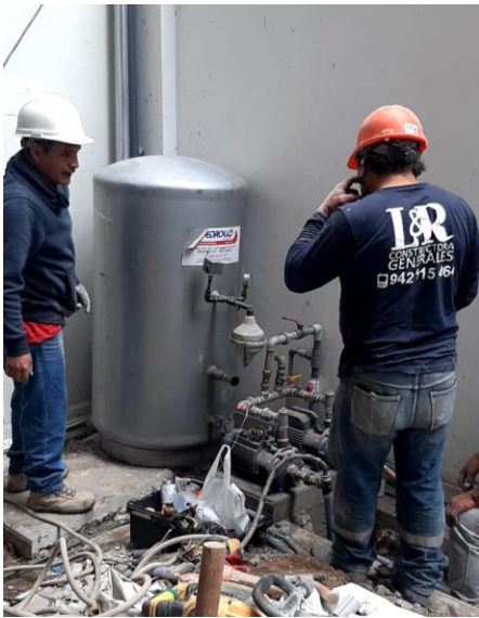
Figura 30: Conexionado de red con la cisterna de agua de consumo existente
