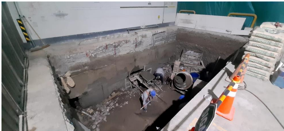
Figura 13: Vaciado de concreto ciclópeo.
