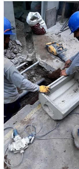
Figura 30: Conexionado de red con la cisterna de agua de consumo existente
