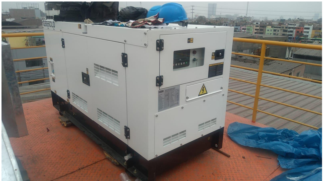
Figura 34: Grupo Electrógeno
