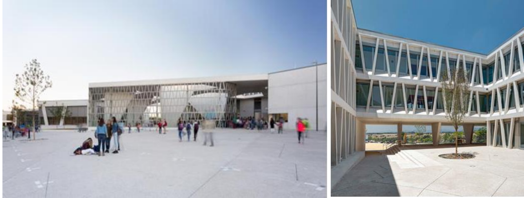
Figura 55: Espacios públicos del colegio alemán (arquitecturaviva.com)
