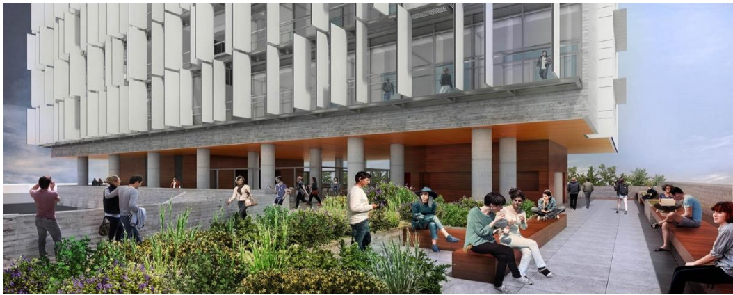
Figura 61: Techos verdes y placas fotovoltaicas del complejo académico PUCP, (archdaily.pe)
