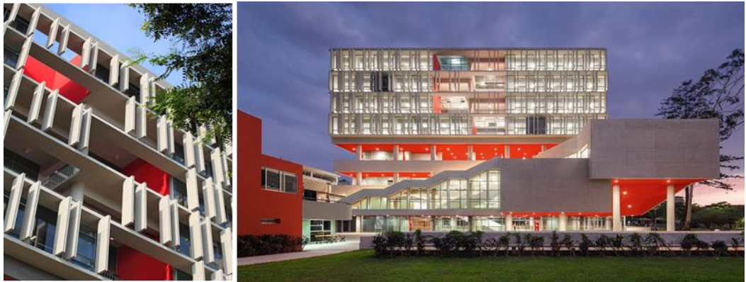
Figura 45: Fachada habilitada del complejo académico PUCP, (archdaily.pe)
