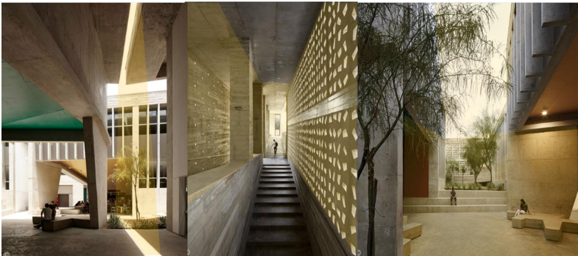
Figura 7: Iluminación Natural y sombra del Aulario UDEP en Piura.
